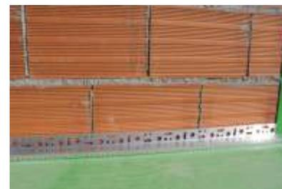
1. Fissaggio del profilo di partenza e impermeabilizzazione del supporto
