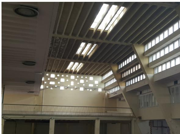
FIG. N°33 Fotografia da sopralluogo. Diffusori a soffitto di forma circolare a cono regolabili: bocchette di mandata a doppia deflessione.
