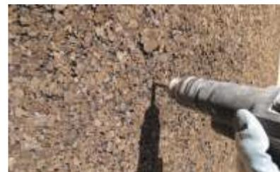
7. Realizzazione dei fori per il fissaggio meccanico tramite tasselli
