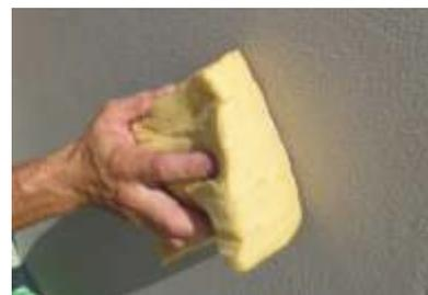
17. Spugnatura della superficie per ottenere un intonaco fine
