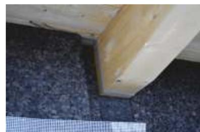
10. Posa del nastro espandente TecnoTape nei punti di contatto tra isolante e superfici rigide e sporgenti
