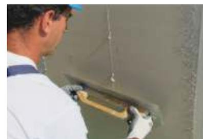
15. Applicazione della prima mano di REABILITA Cal Acabamento. finitura a base di calce idraulica naturale
