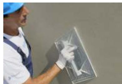
16. Spatolatura a taloscia della seconda mano di finitura REABILITA Cal Acabamento
