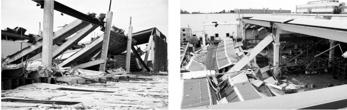
Figura 37 \_ caduta degli elementi di copertura e delle travi per perdita di appoggio
