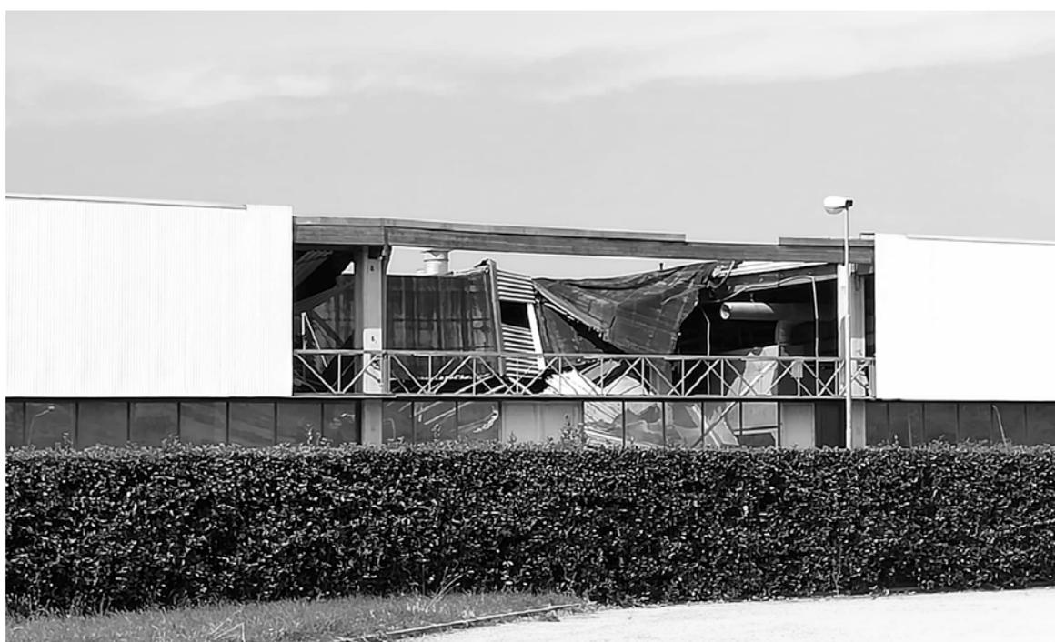
Figura 70 \_ Crollo di un capannone prefabbricato monopiano ad Ascoli Piceno
