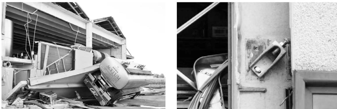
Figura 38 \_ collasso dei pannelli di tamponatura di un capannone per rottura dei sistemi di ancoraggio
