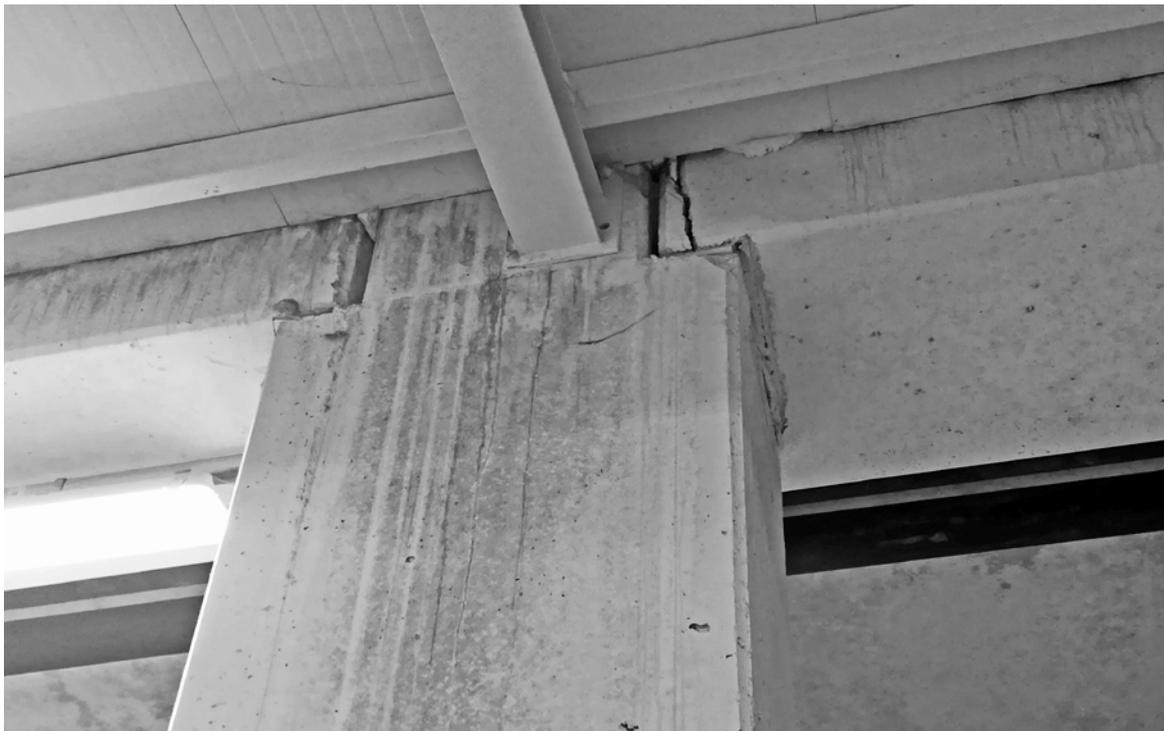
Figura 75 \_ Fessurazione della trave prefabbricata in corrispondenza del nodo
