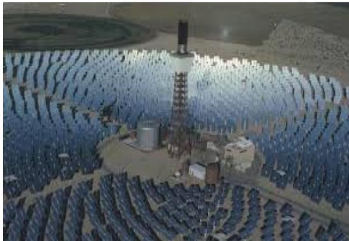
solari tramite un sistema di specchi parabolici a struttura lineare che li concentrano verso un unico punto in cui scorre un fluido termovettore o verso una caldaia. Quando si parla di **energia solare a concentrazione** si fa riferimento alla tecnologia tipica di un **impianto solare termodinamico** noto anche come **centrale solare termoelettrica** o **centrale solare a concentrazione**.
