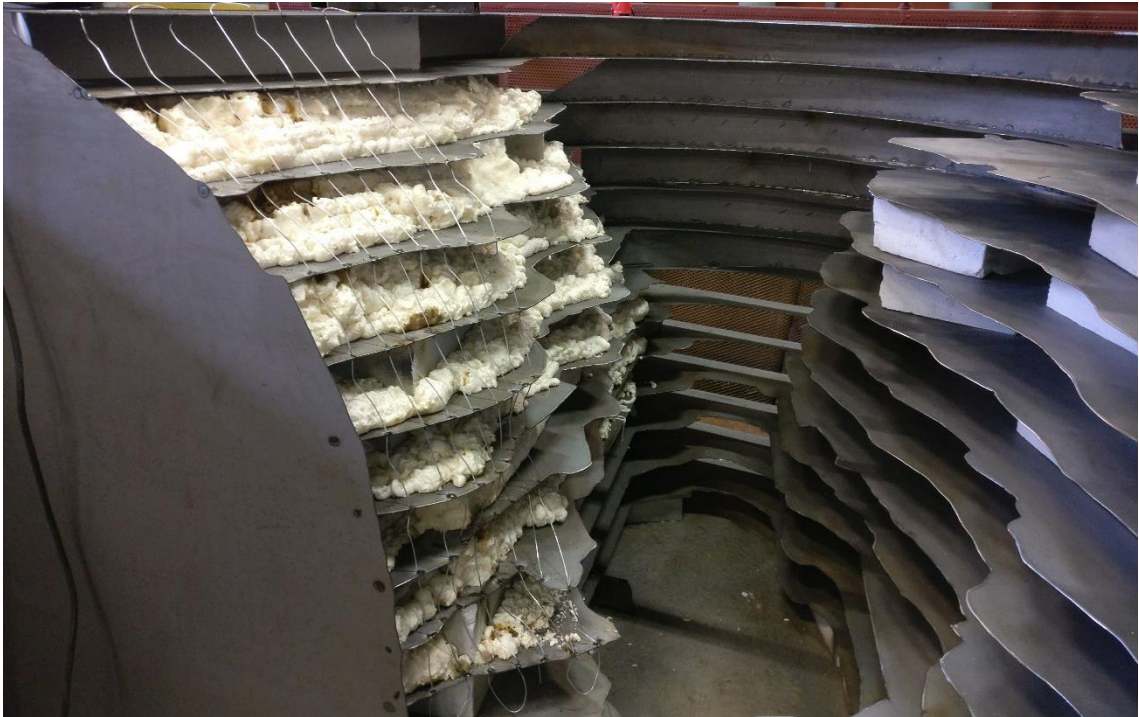
Figura 11: fase di riempimento delle pareti di valle
