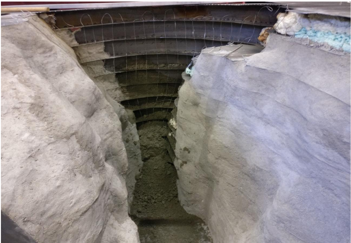
Figura 12: posa del calcestruzzo
