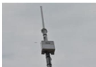
L'infrastruttura di rete è basata sullo standard LoRa. Prevede l'impiego di GATEWAY dislocati sul territorio, in modo da garantire la necessaria copertura dell'area da monitorare.
