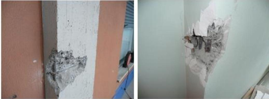
Figura 42 Rilievo dei ferri mediante rimozione copriferro
