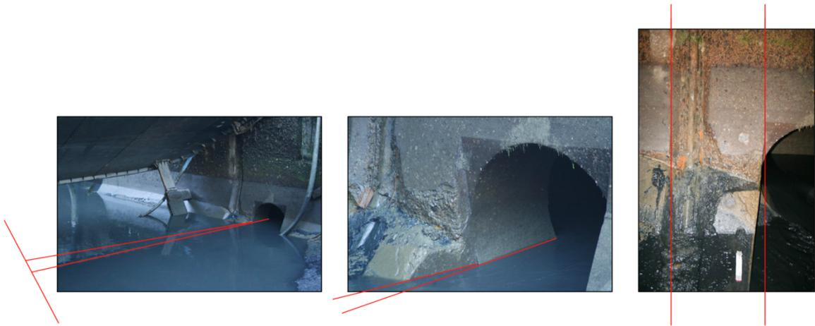
**Figura 22:** Elaborazione con allineamenti atti a mettere in evidenza la superficie non piana di contatto
