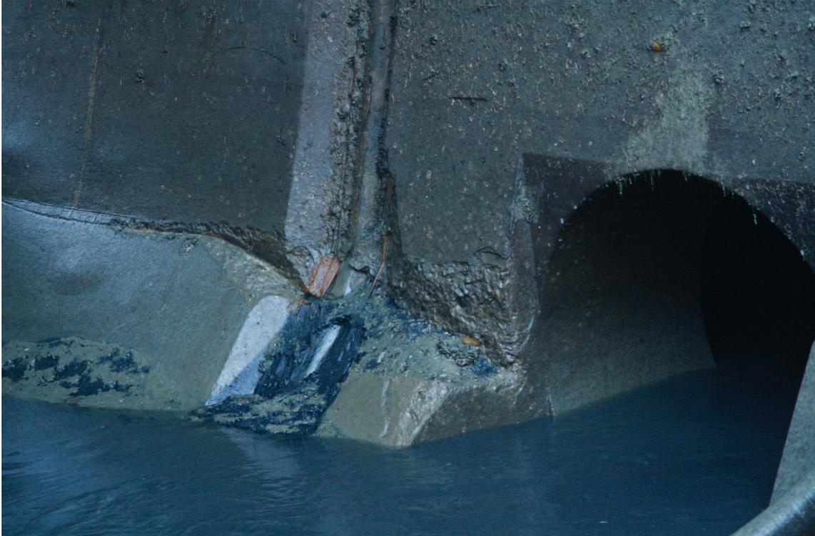
*Figura 102: Zona interessata alla rottura nel cls (lato bosco), in cui si nota l'assenza di armatura*
