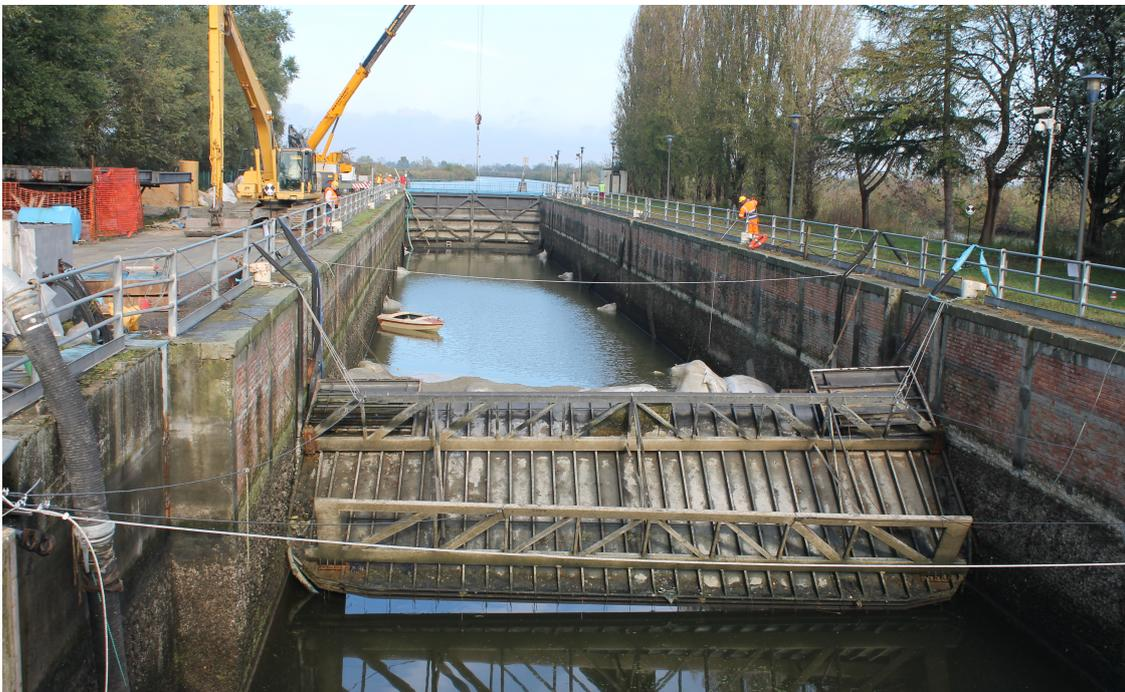
*Figura 21: Conca Valle Lepri con vista verso monte, in primo piano il pancone metallico provvisorio a seguito del collasso*
