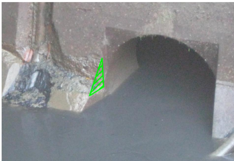
**Figura 63:** Particolare della zona interessata dalla frattura (imbocco cunicolo acquedotto), traccia a sezione triangolare
