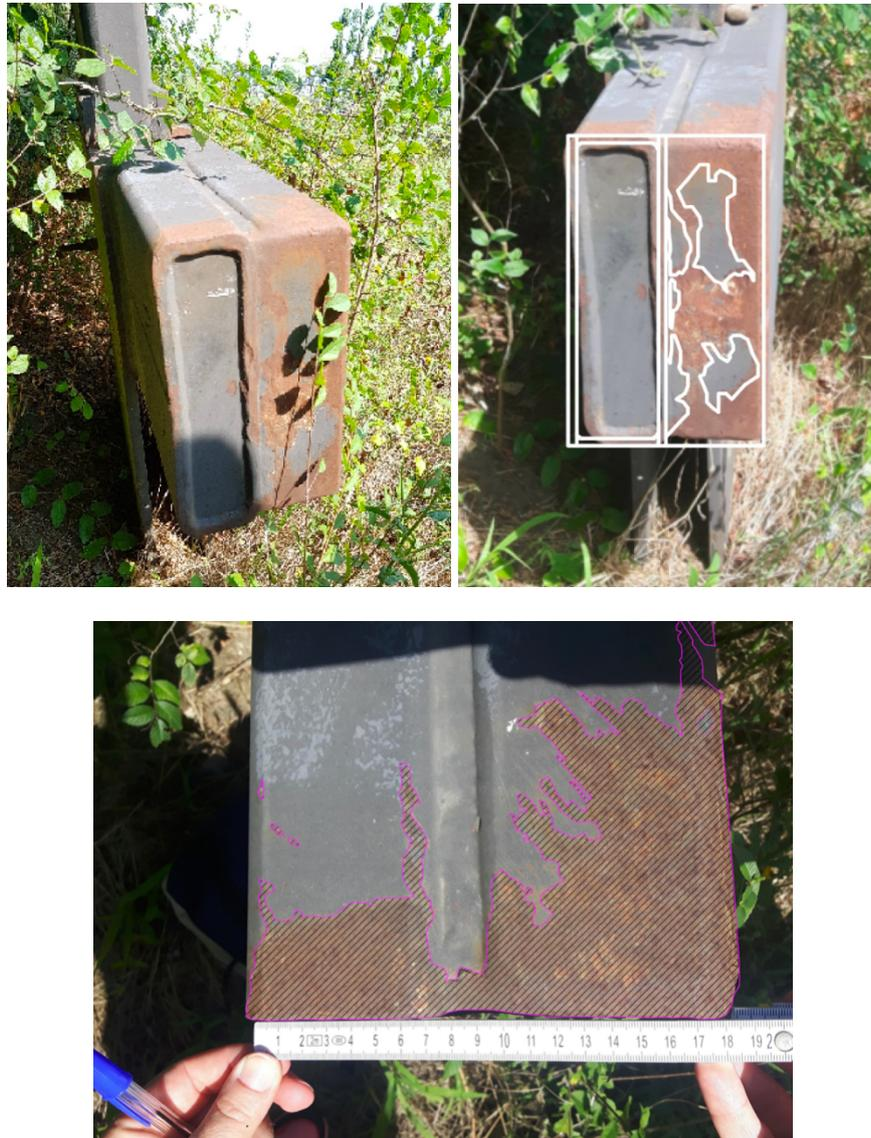
**Figura 69:** Piede di appoggio inferiore del pancone e messa in evidenza della presenza di abrasione sulla superficie (da fascicolo fotografico dell'ultimo sopralluogo)
