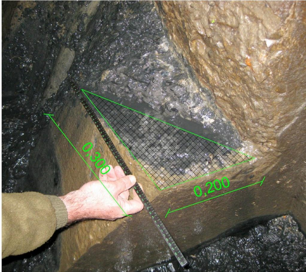
*Figura 75: Elaborazione della superficie di frattura in base alle misure dedotte dai rilievi effettuati (misure in metri)*
