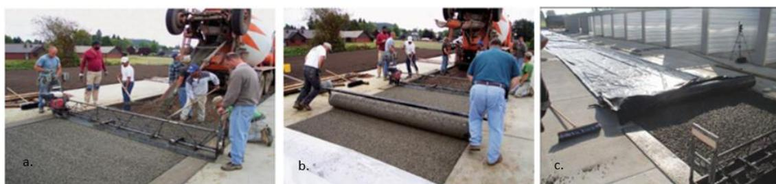
Figura 1-10: a. Messa in opera, b. compattazione e c. applicazione dei teli in fase di maturazione per prevenire l'eventuale perdita di umidità (foto di Banka da Tennis, 2004)
