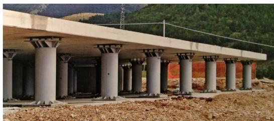
**Figura 3.12:** Soletta di basamento del progetto C.A.S.E
