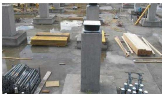
**Figura 3.9:** Ospedale Del Mare di Napoli: isolatori elastomerici sui pilastri in fondazione
