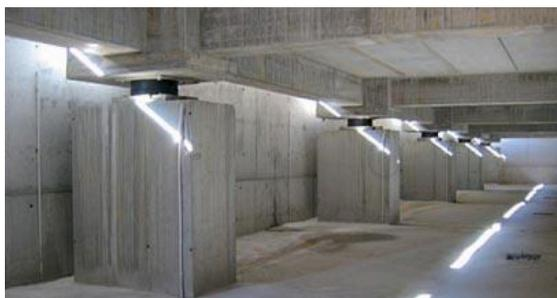
**Figura 3.8:** Ospedale Gervasutta di Udine con dispositivi elastomerici nel seminterrato
