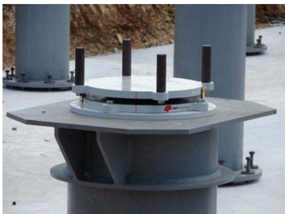
**Figura 3.13:** Dispositivo a pendolo scorrevole montato su un pilastro in acciaio
