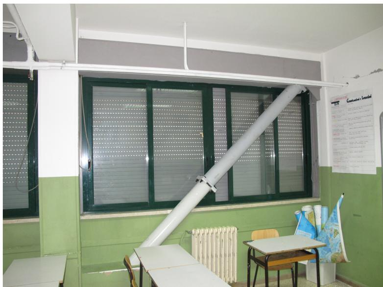
**Figura 1.7:** Edificio visto dall'interno dopo l'ultimo intervento di adeguamento
