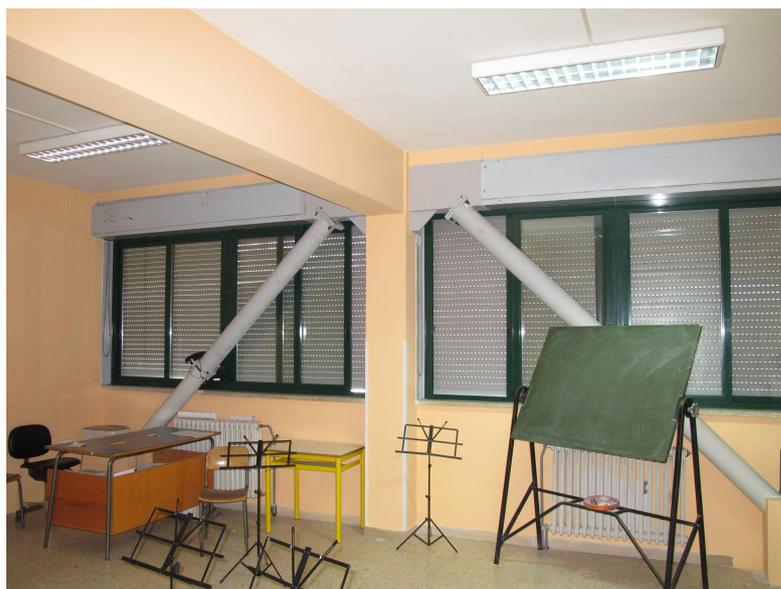
**Figura 1.6:** Edificio visto dall'interno dopo l'ultimo intervento di adeguamento
