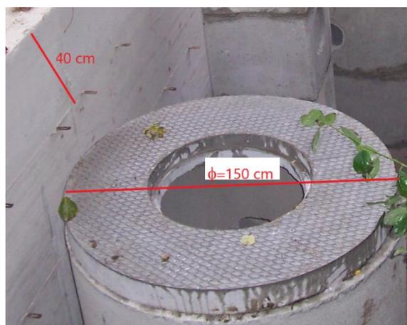
Figura 3.16: diametro serbatoio imhoff
