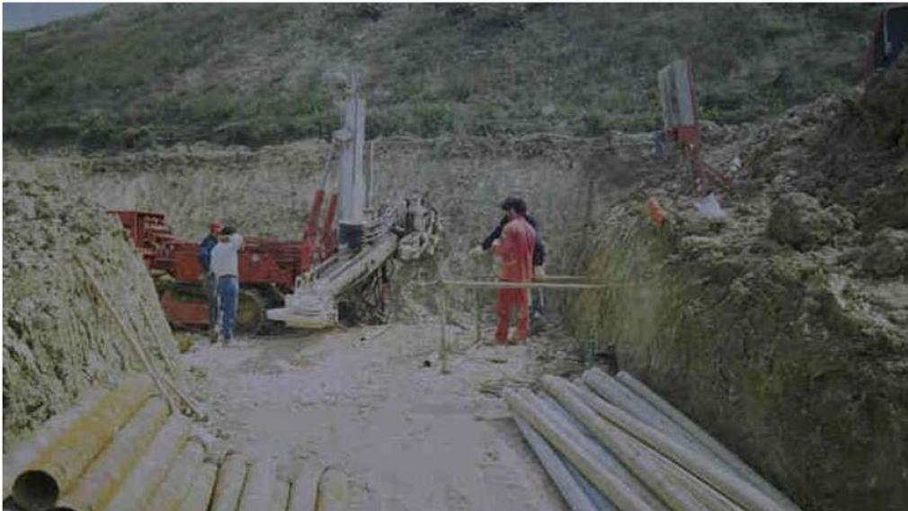
Figura 2.3: perforazione per installazione dreni sub-orizzontali
