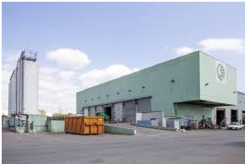
Figura 20 Vista impianto di ricezione e pretrattamento di Valterza
