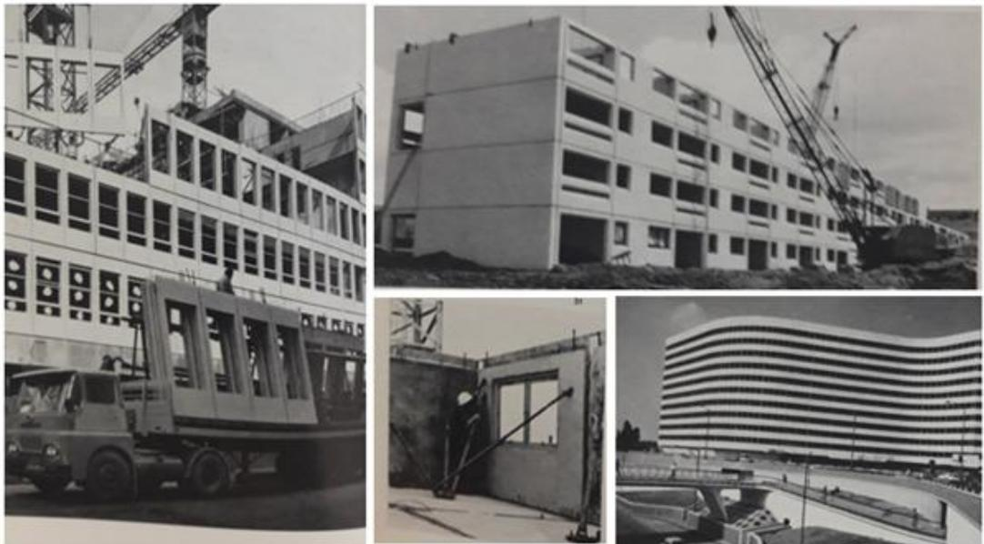
Figura 13. Sistema di prefabbricazione, 1960-1970
