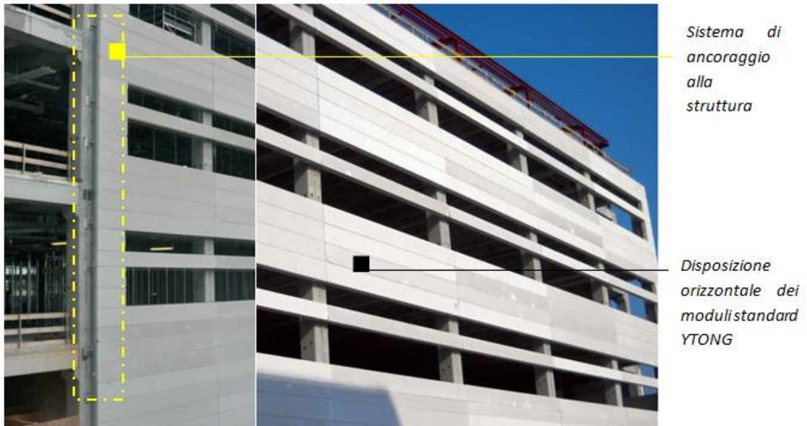
Figura 34. Sistema di ancoraggio alla struttura, pannelli YTONG
