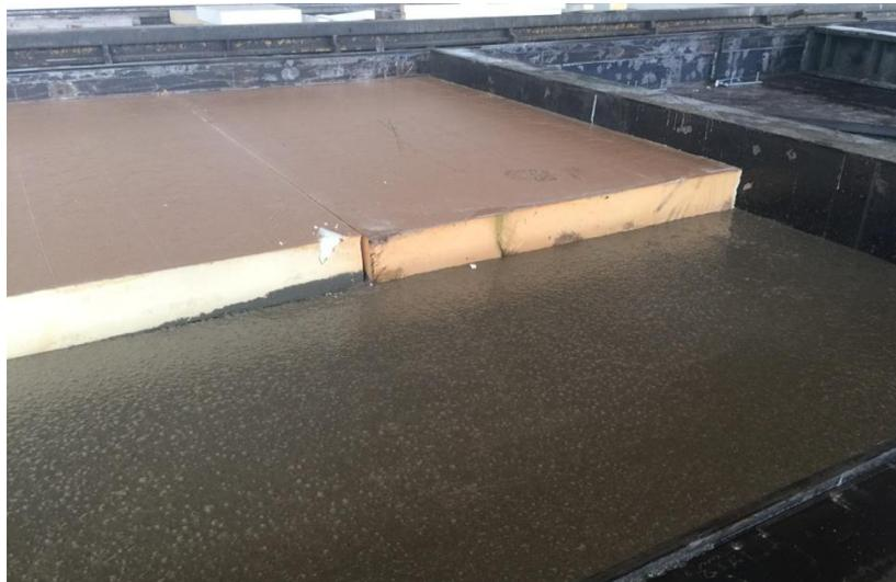
**Figura 21. 2° fase, disposizione dello strato isolante nel pannello di progetto**
