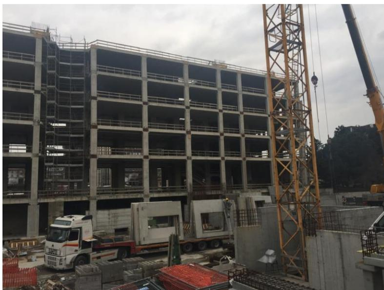
Figura 23. Trasporto dei pannelli prefabbricati in cantiere
