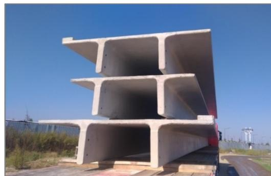
Figure 46-47: Trasporto dei tegoli prefabbricati in cantiere mediante autotreno
