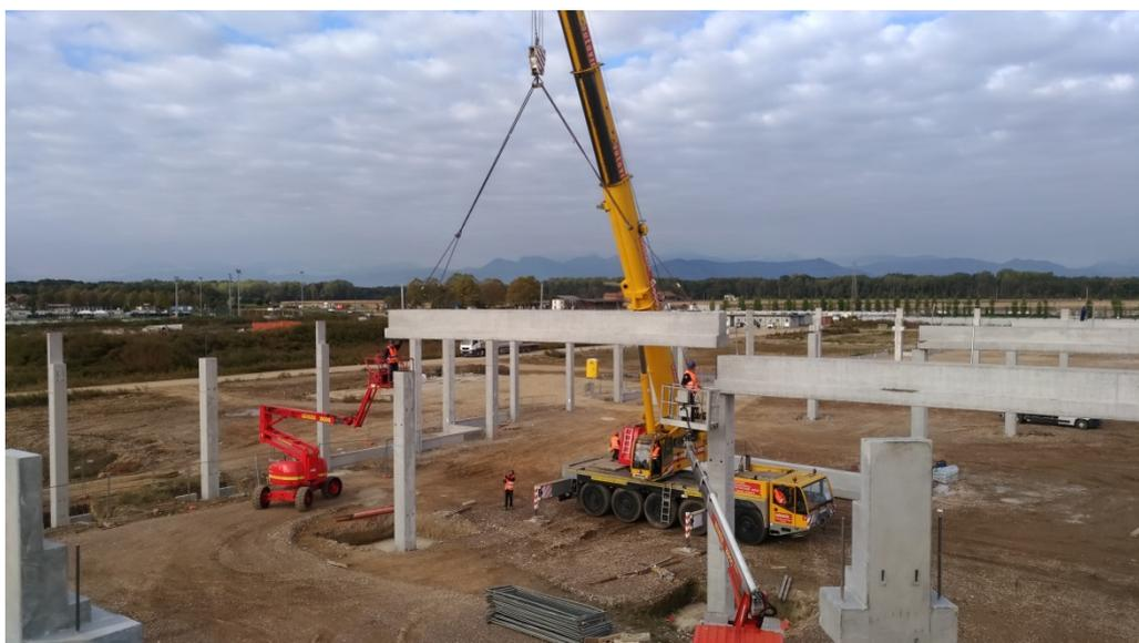
Figura 43: Fase di sollevamento della trave mediante autogru e operatori su PLE per guida alla posizione finale.
