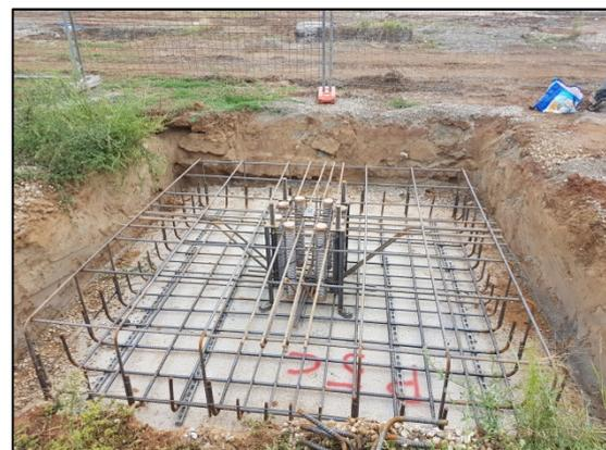
Figure 20-21-22-23: Fasi di realizzazione dei plinti di cls gettati in opera nel cantiere MondoJuve (corpi C ed E); dettagli di armatura e innesto di fondazione con tubi corrugati.
