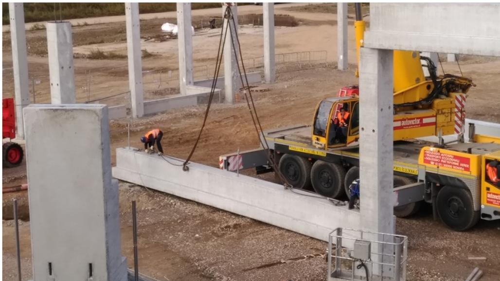
Figura 42: Fase di posa in opera; aggancio delle funi alle boccole della trave prefabbricata.
