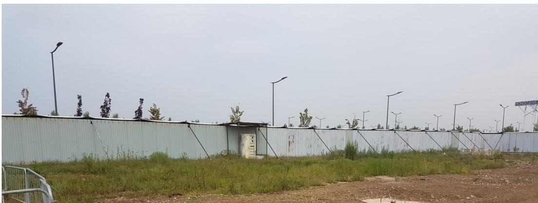
Figura 17: Recinzione di cantiere "cieca" in metallo con puntellature di controvento.
