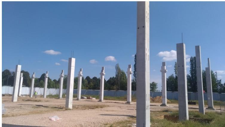
Figura 28: Montaggio pilastri prefabbricati; cantiere MondoJuve.
