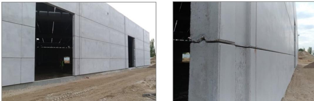
Figure 51-52: Elemento Pannello prefabbricato orizzontale esterno di tipo "sandwich"
