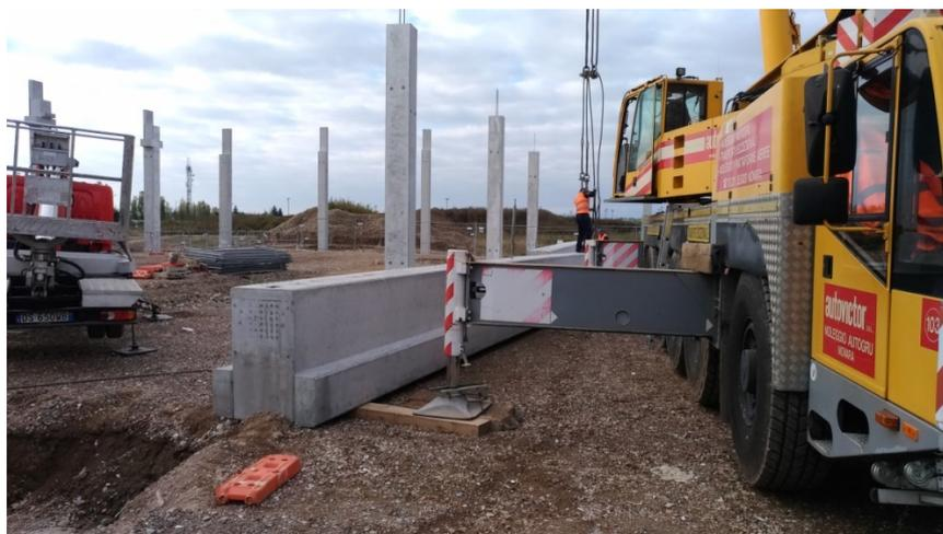
Figura 41: Dettaglio traversine in legno per stoccaggio travi a terra.
