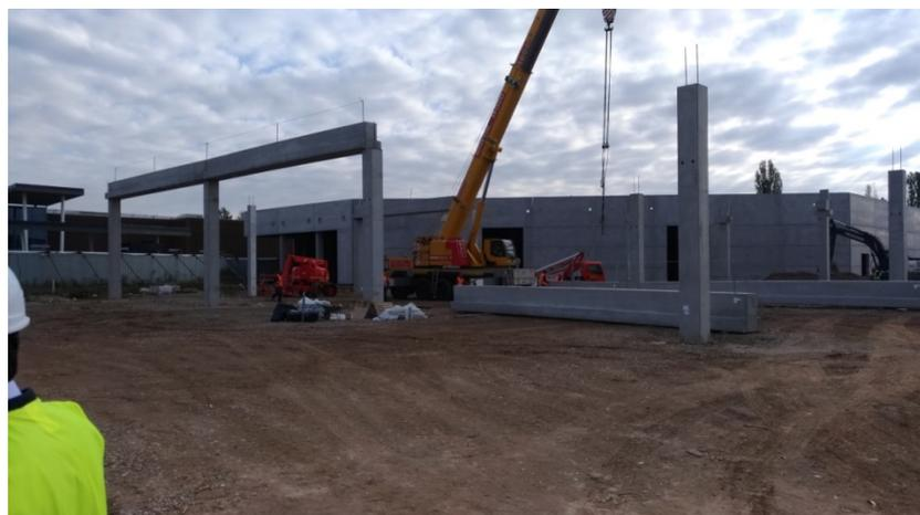
*Figura 40: Stoccaggio a piè d'opera delle travi prefabbricate in cantiere.*
