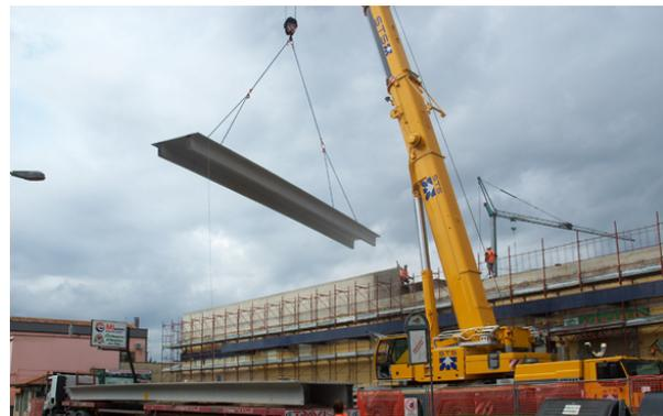
Innanzitutto l'operazione necessita di due addetti che, saliti sull'autotreno mediante una scala fino alla sommità dell'ultimo tegolo della pila, aggancino le funi agli 8 ancoraggi predisposti dal prefabbricatore, 4 per
