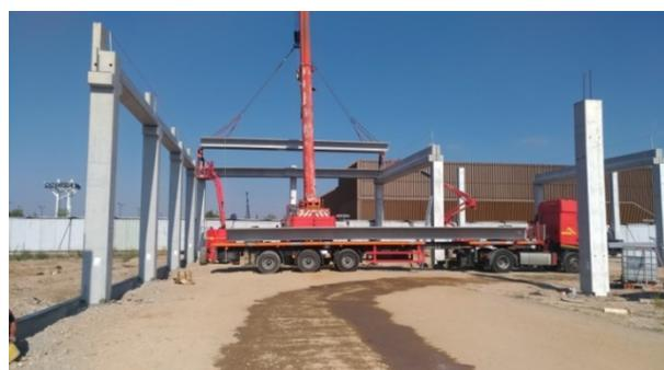
Figure 48-49: Sollevamento dei Tegoli prefabbricati mediante autogru e l'ausilio di operatori su PLE.
