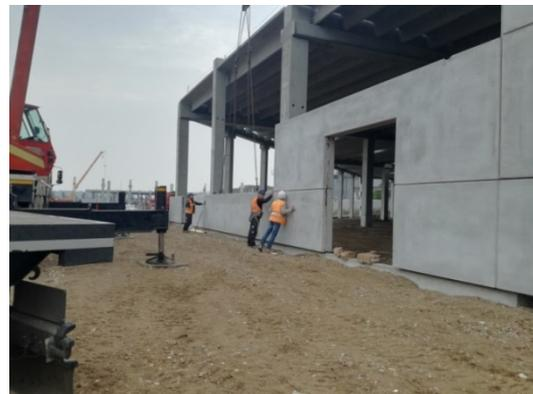
*Figura 54: Fase di posa in opera pannelli prefabbricati in cantiere.*
