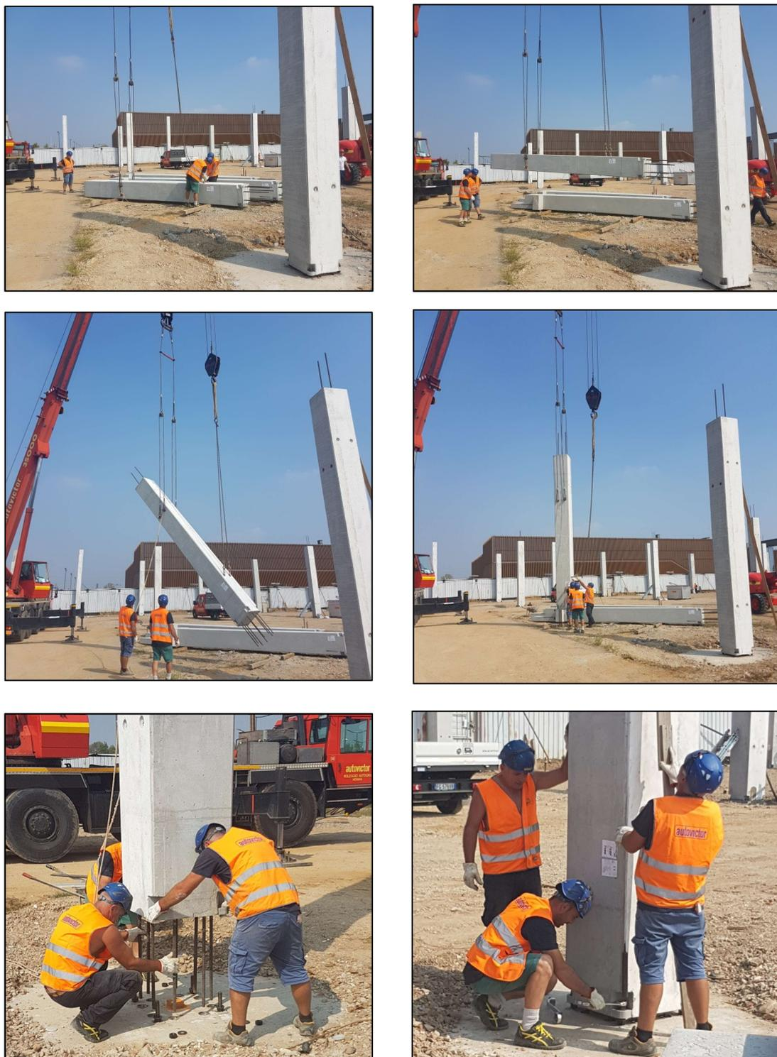
Figure 31-32-33-34-35-36: Sequenza logica di fasi per la posa in opera dei pilastri prefabbricati; cantiere MondoJuve Shopping Center
