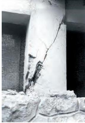
*Figura 7 - Pilastrino tozzo rottura a taglio (Fonte: Manuale AeDES)*
