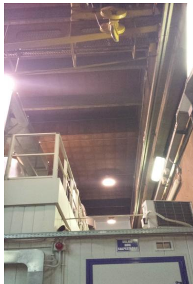
Figura 29: Vista dal basso della controsoffittatura (cono ottico 3 di Figura 27) del laboratorio in esame, in cui si vedono i pannelli costituiti da lana di roccia ricoperta da lana di vetro
