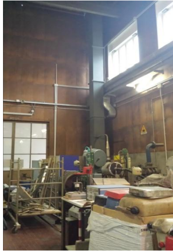
Figura 30: Vista dal cono ottico 3 di Figura 27 dell'interno del laboratorio, con presenza di materiali e macchine. Si noti l'intero rivestimento delle pareti e del soffitto con pannelli
