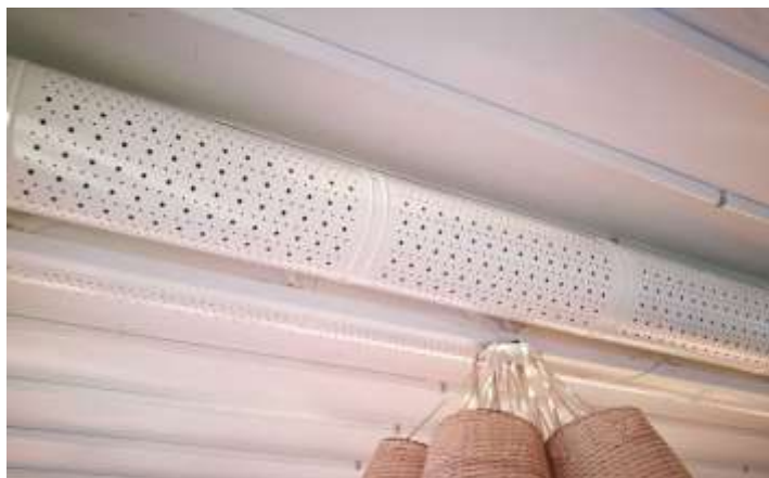
Fig. 4.6 – Tipologia di canale aria microforato (fonte CTG)
