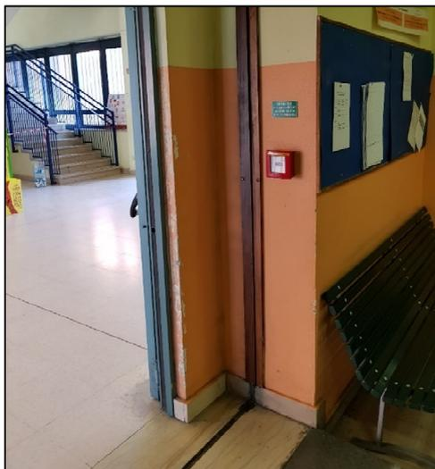
*Figura 19. Giunto sismico dall'interno*
