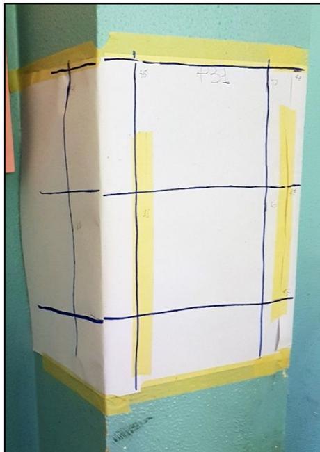
*Figura 75. Rilievo barre*
