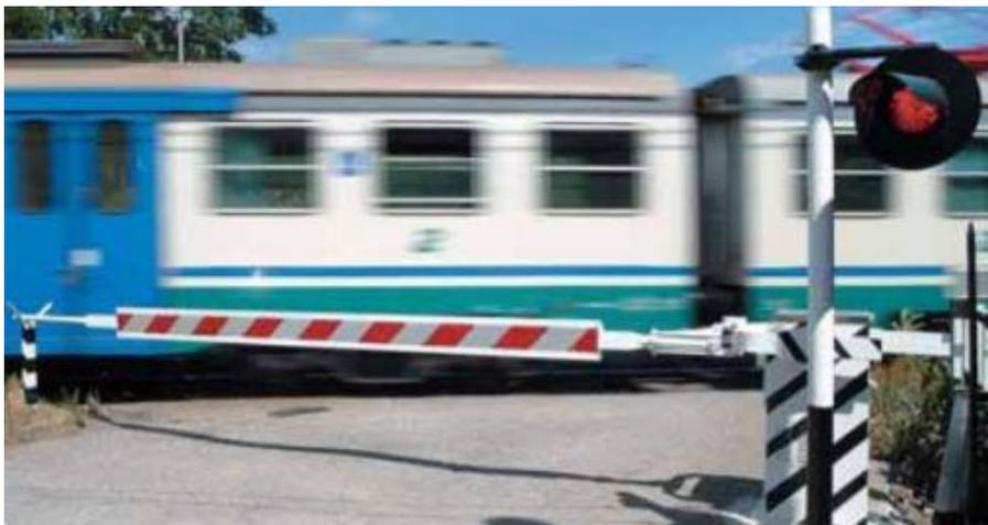
Figura 9.2 PL con barriera TD 96/2 e avvisatore luminoso.
