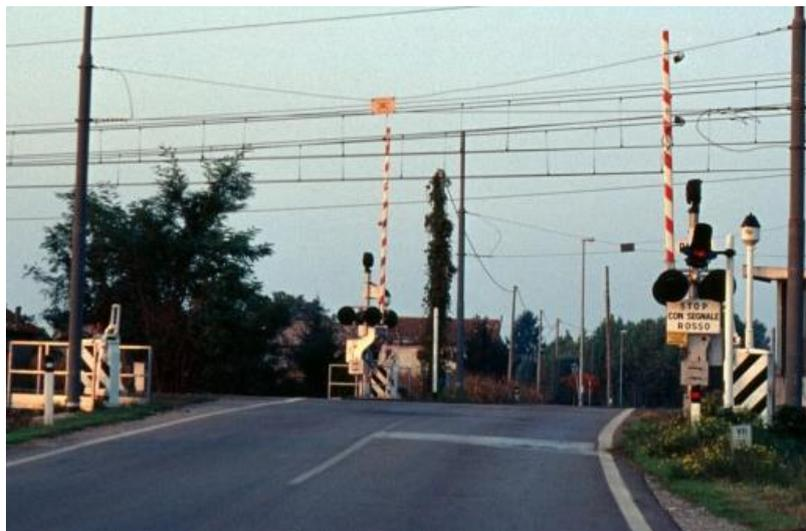
Figura 4.1 Passaggio a livello custodito con barriere. [t]
