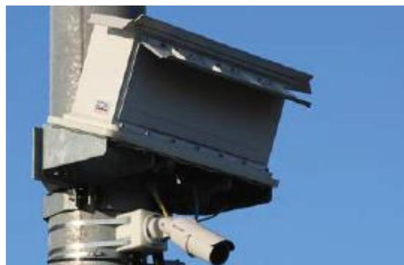
Figura 4.5 Sistema di monitoraggio SIRIO LX. [30]
