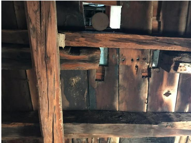
*Figura 3.30. Attacco da insetti nella trave secondaria n. 4 del solaio P1*
