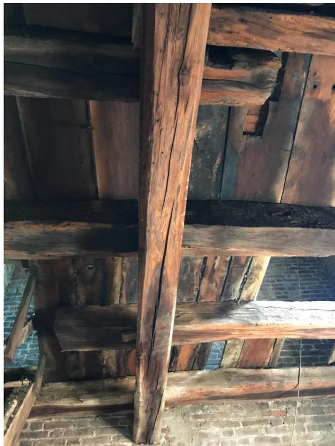
*Figura 3.29. Fessurazione da ritiro sulla trave principale del solaio P1*
