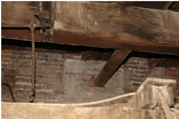
*Figura 3.22. Collegamento tra la trave principale e la muratura*
