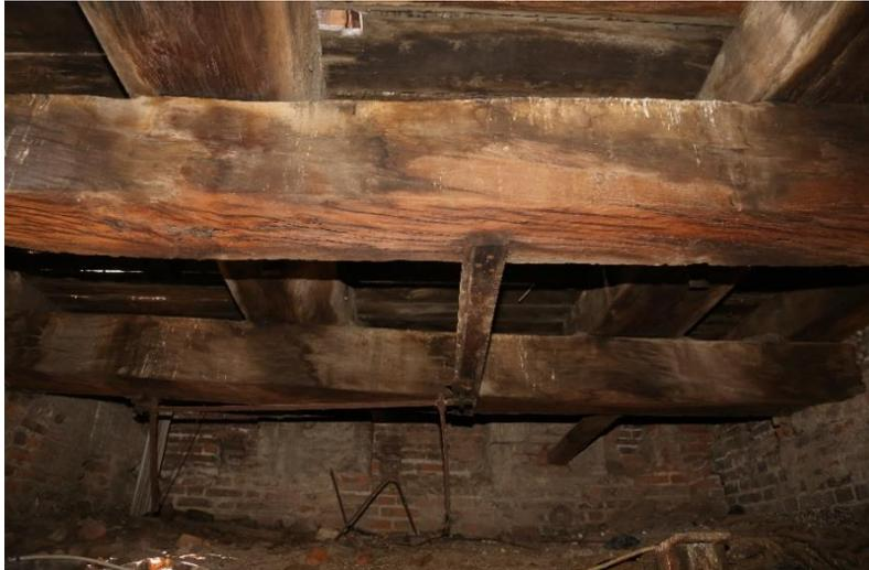
*Figura 3.21. Collegamento tra le travi principali*
