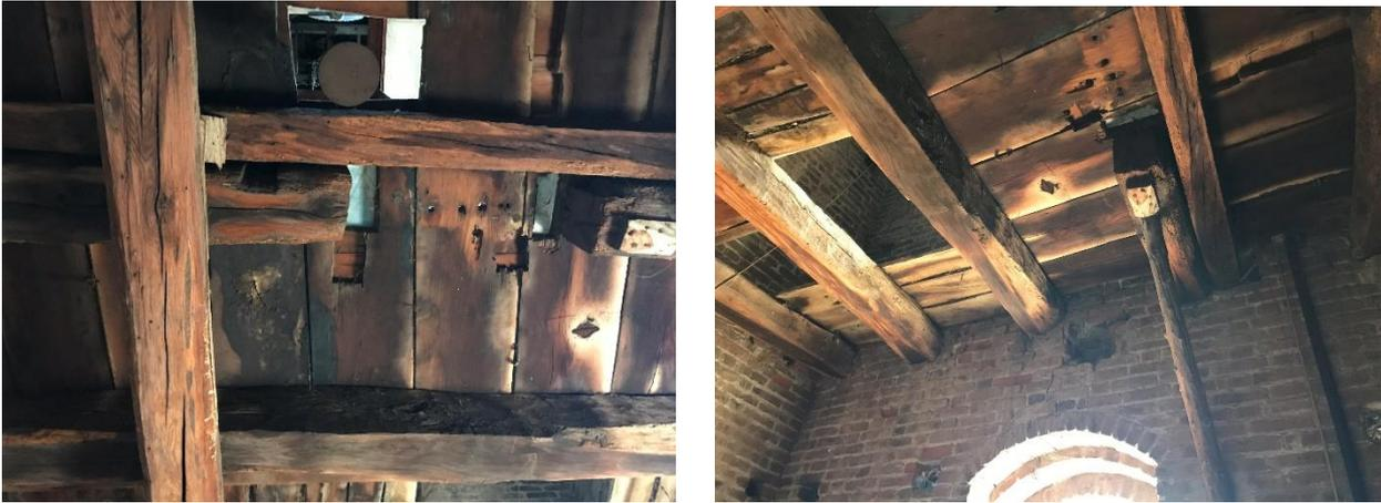
*Figura 3.14. Particolare del solaio P1(sx) e mancanza del tavolato (dx)*
