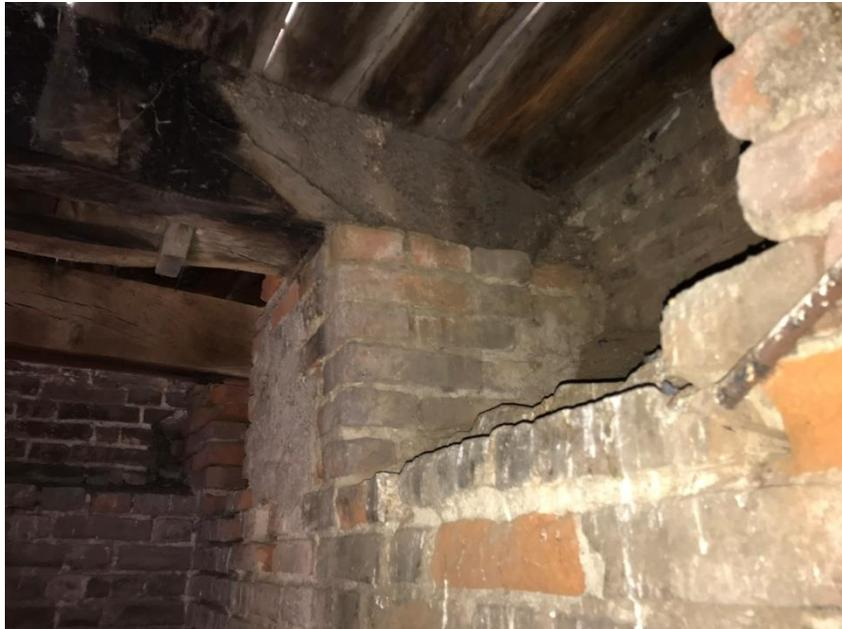
*Figura 3.32. Caria bianca e fessurazione irregolare nella trave secondaria n. 3 del solaio P2*
