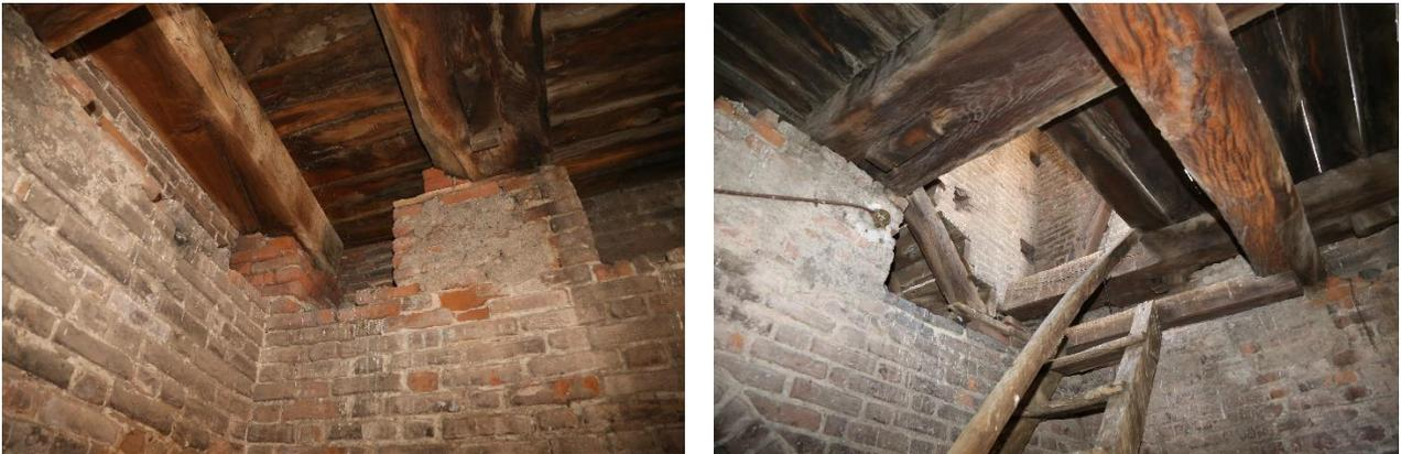
*Figura 3.20. Particolare appoggio della trave secondaria (sx) e scala d'accesso al solaio P2 (dx)*
