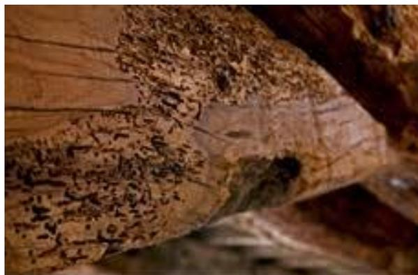
Figura 3.8. Degrado dovuto ad attacco d'insetti
