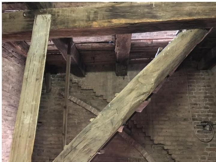
*Figura 3.25. Fessurazione da ritiro nella trave principale del solaio P0*
