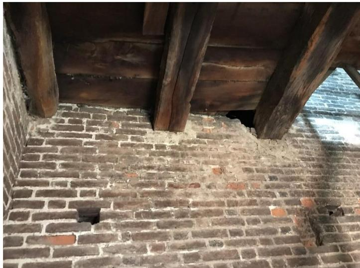
*Figura 3.31. Degrado nelle travi secondarie del solaio P1*
