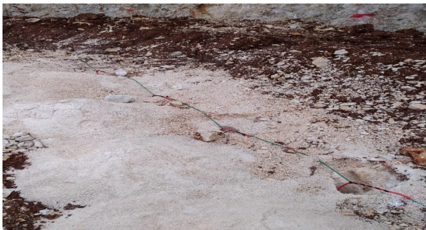
Figura 45 Volata di Presplitting con tecnica tradizionale Fassa
