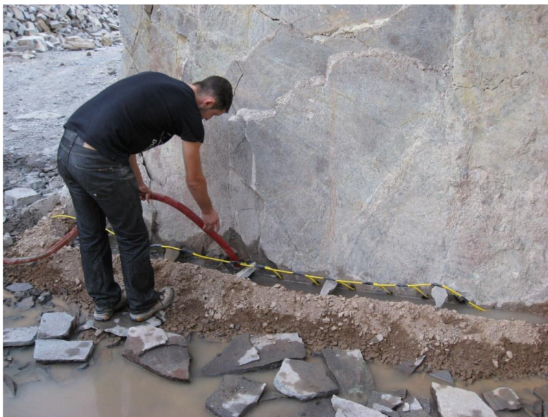
Figura 32- Riempimento dei fori con acqua (Sogeca 2013)
