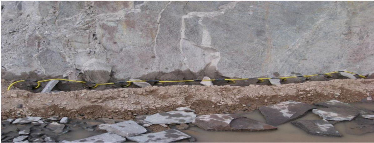
Figura 31 - Taglio di bancata con miccia detonante (Sogeca 2013)
