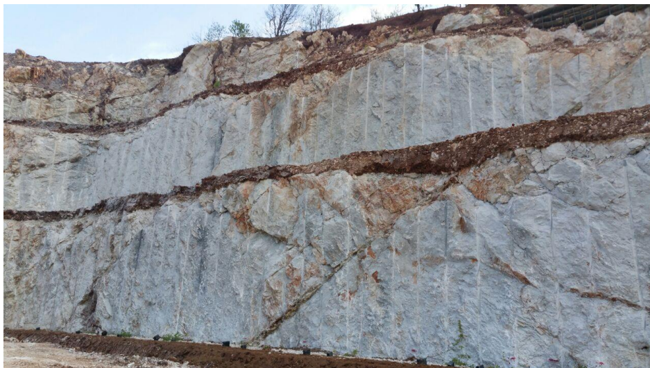
Figura 52 - Profili finali dei gradoni soggetti a recupero (Fassa Bortolo 2017)
