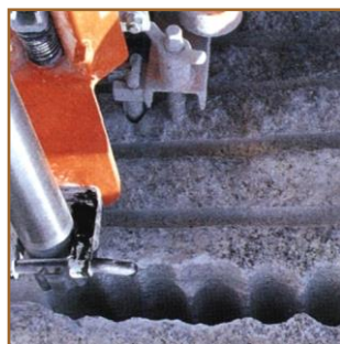
Figura 12 Schema Tipico e procedura di un lavoro di Line Drilling (Matti 1999)
