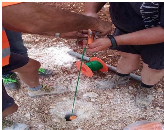
Figura 44 Caricamento fori volata sperimentale
