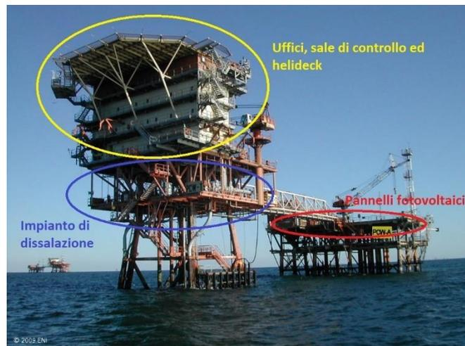
*Figura 7.1 - Complesso di Porto Corsini con collocazione degli impianti [14]*
