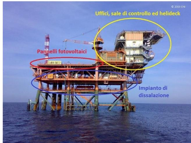
**Figura 7.2** - Piattaforma Clara Ovest con collocazione degli impianti [14]
