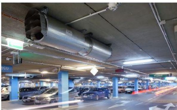
Fig. 5 A sinistra ventilatore a getto mentre destra l'estrattori
