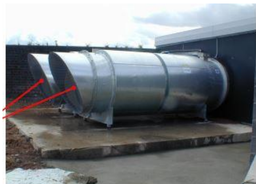
Fig. 5 A sinistra ventilatore a getto mentre destra l'estrattori
