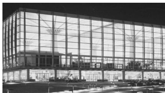
Fig. 3 Palazzo del lavoro, esostruttura in acciaio e facciate con sistema brise
