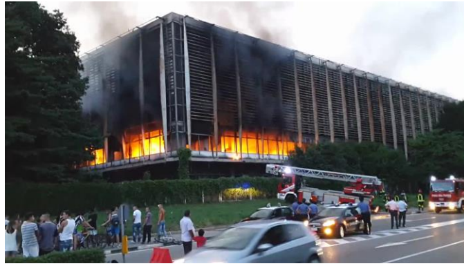
Fig. 4 Palazzo del lavoro, incendio 2015
