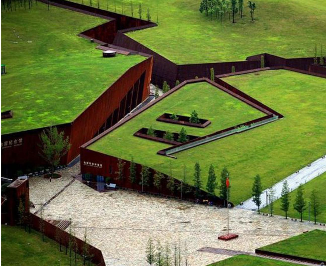
realizzazione di coperture e pareti vegetali può contribuire in misura significativa alla riduzione del fabbisogno energetico dell'edificio e quindi alla riduzione delle emissioni di CO<sub>2</sub>.
