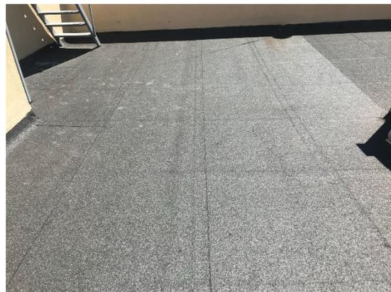
**Fig. 6.3:** Copertura di impermeabilizzazione con bitume - Edificio Hilarión E. 36
