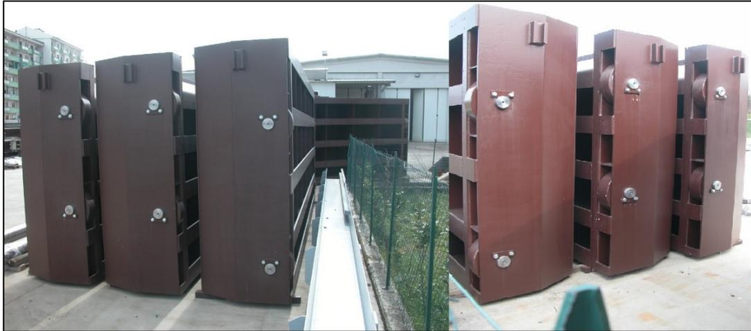
*Figura 25: Paratoie installate nella centrale di Santa Vittoria d'Alba. Fonte: Wet Hydro SRL (2014).*
