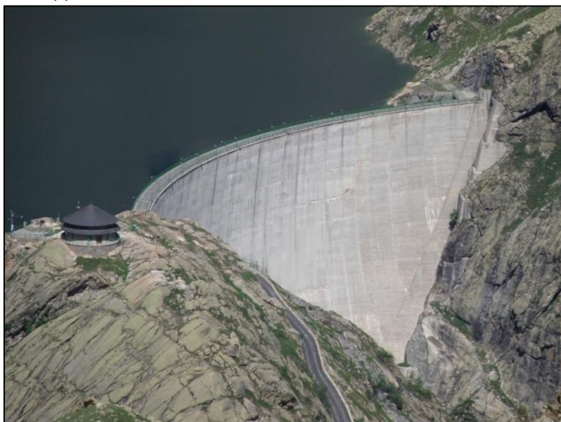
Figura 19: Diga ad arco del Chiottas, centrale idroelettrica L. Einaudi - Entracque (CN). Fonte: A. Rivelli, Parco Nazionale Alpi Marittime.
