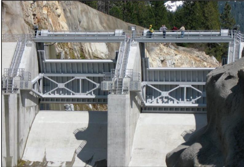
Figura 8: Paratoie a settore installate alla diga L. L. Anderson. Fonte: Rodney Hunt (2012).
