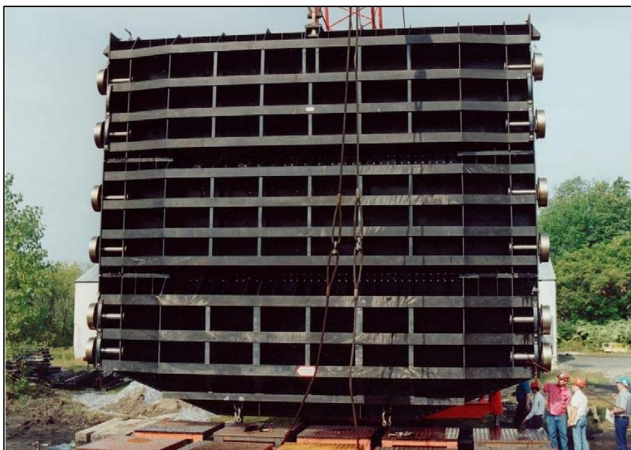
Figura 2: Esempio di paratoia piana installata nell'impianto idroelettrico Idaho Power's Swan Falls. Fonte: Rodney Hunt (1994).
