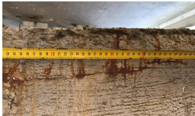
*Figure 50 Longitudinal crack*
