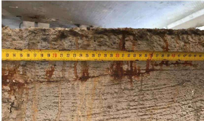
*Figure 50 Longitudinal crack*
