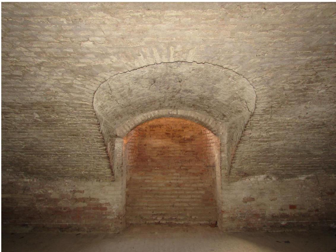
Foto 28. Sotterranei, apertura della bocca di lupo con lunetta con arco d'appoggio che incontra la volta.
