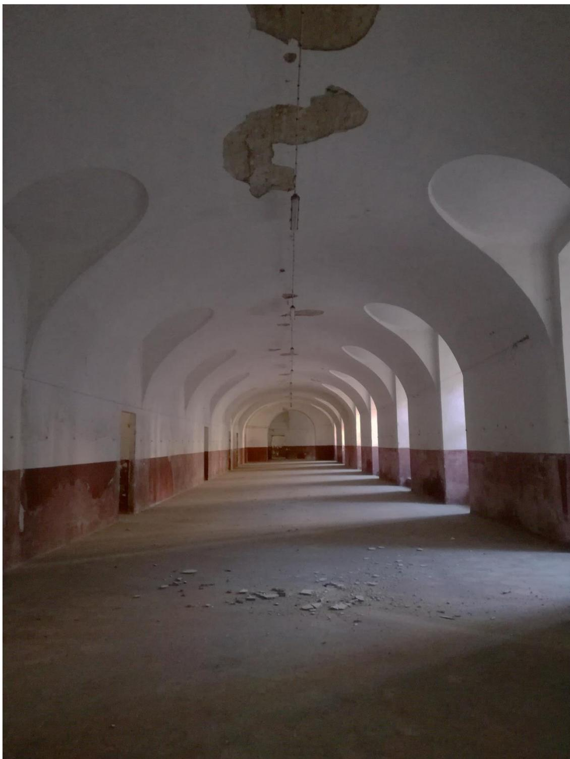
Foto 30. Ambiente voltato con volta ellittica al piano terra della manica Nord-Ovest.
