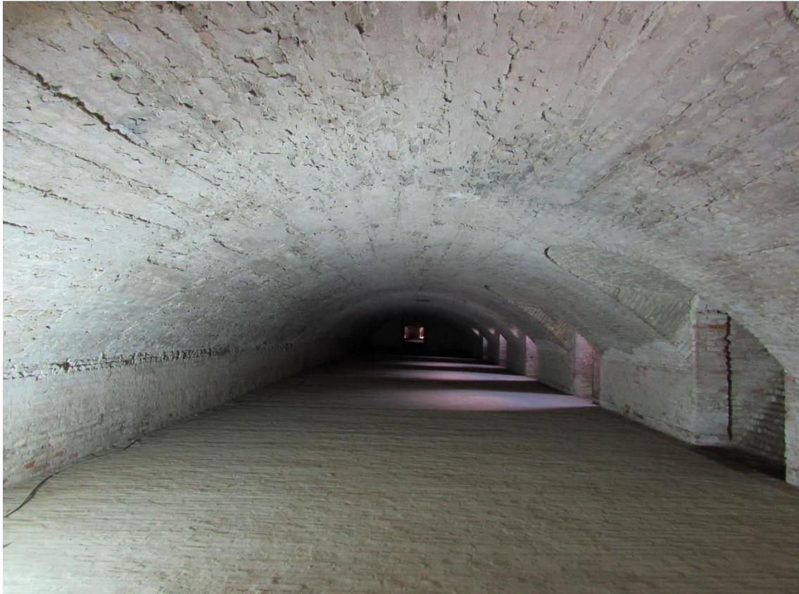
Foto 26. Ambiente voltato con volta botte al piano interrato.
