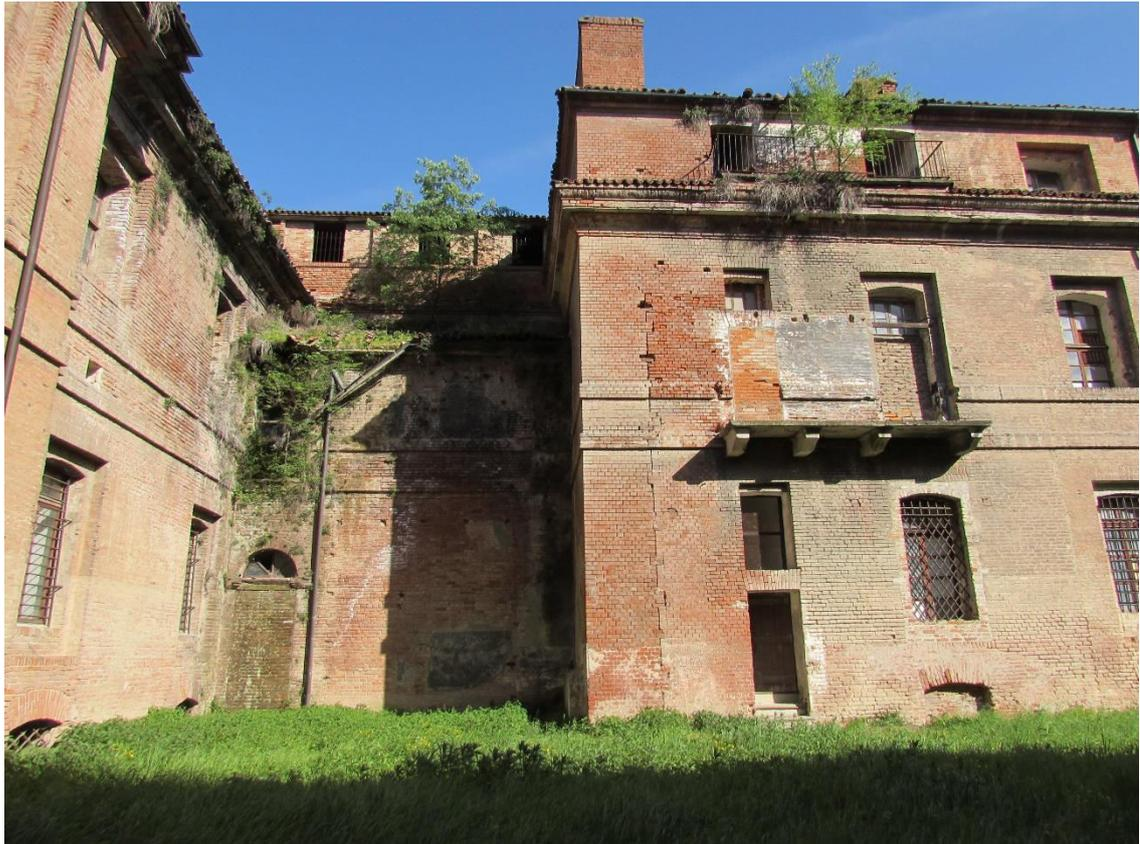
Foto 20. Cortile settentrionale. Vista verso la sopraelevazione della manica perpendicolare alla principale. Si notano, inoltre, le tracce murarie della manica che divideva in due il cortile.
