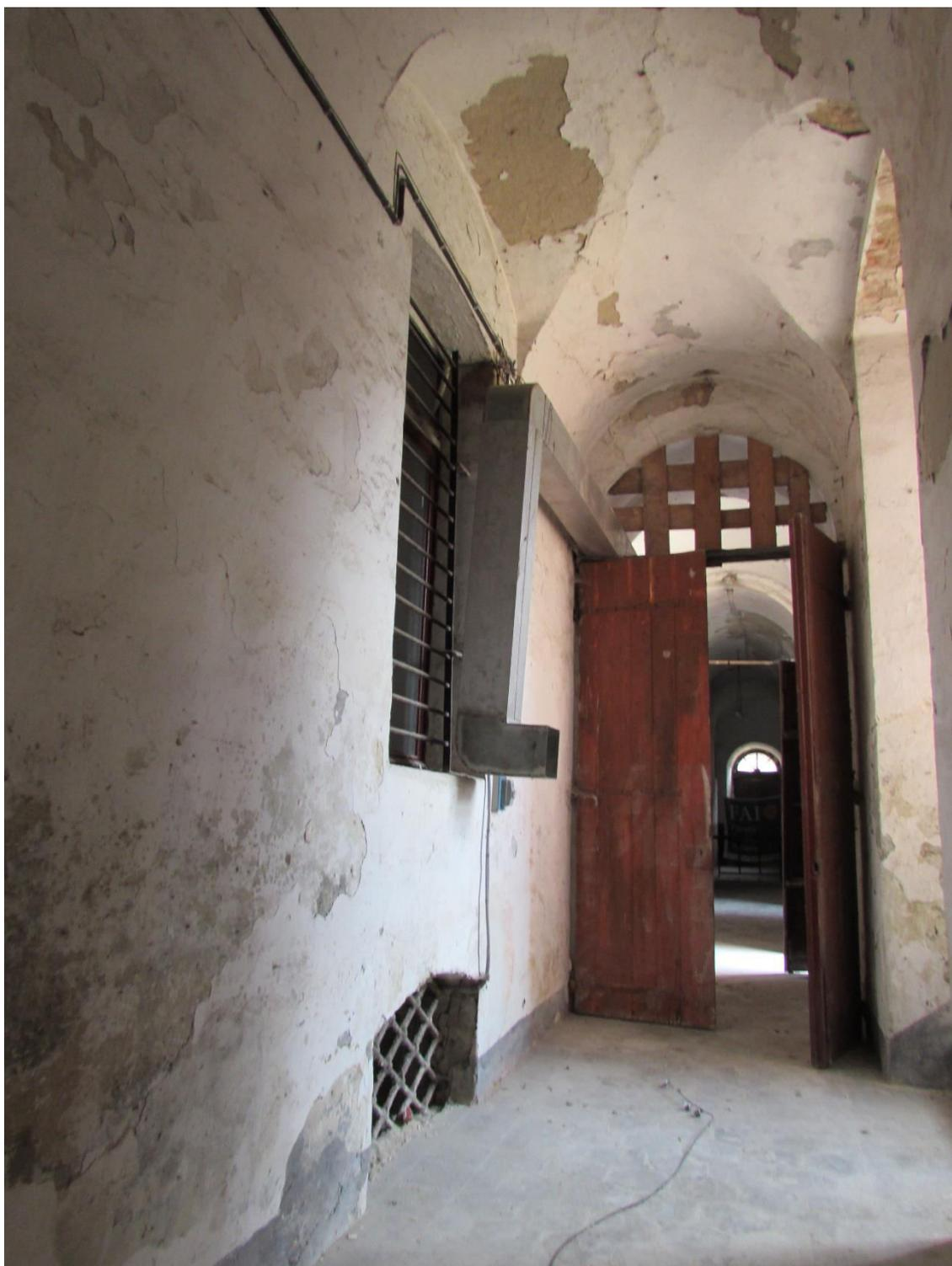
Foto 40. Corridoio adiacente alla Cappella, costruito quando la manica principale era già stata elevata per una porzione: era già stato costruito il piano interrato e il piano terra poiché sono state create le aperture che si affacciano in tale corridoio.
