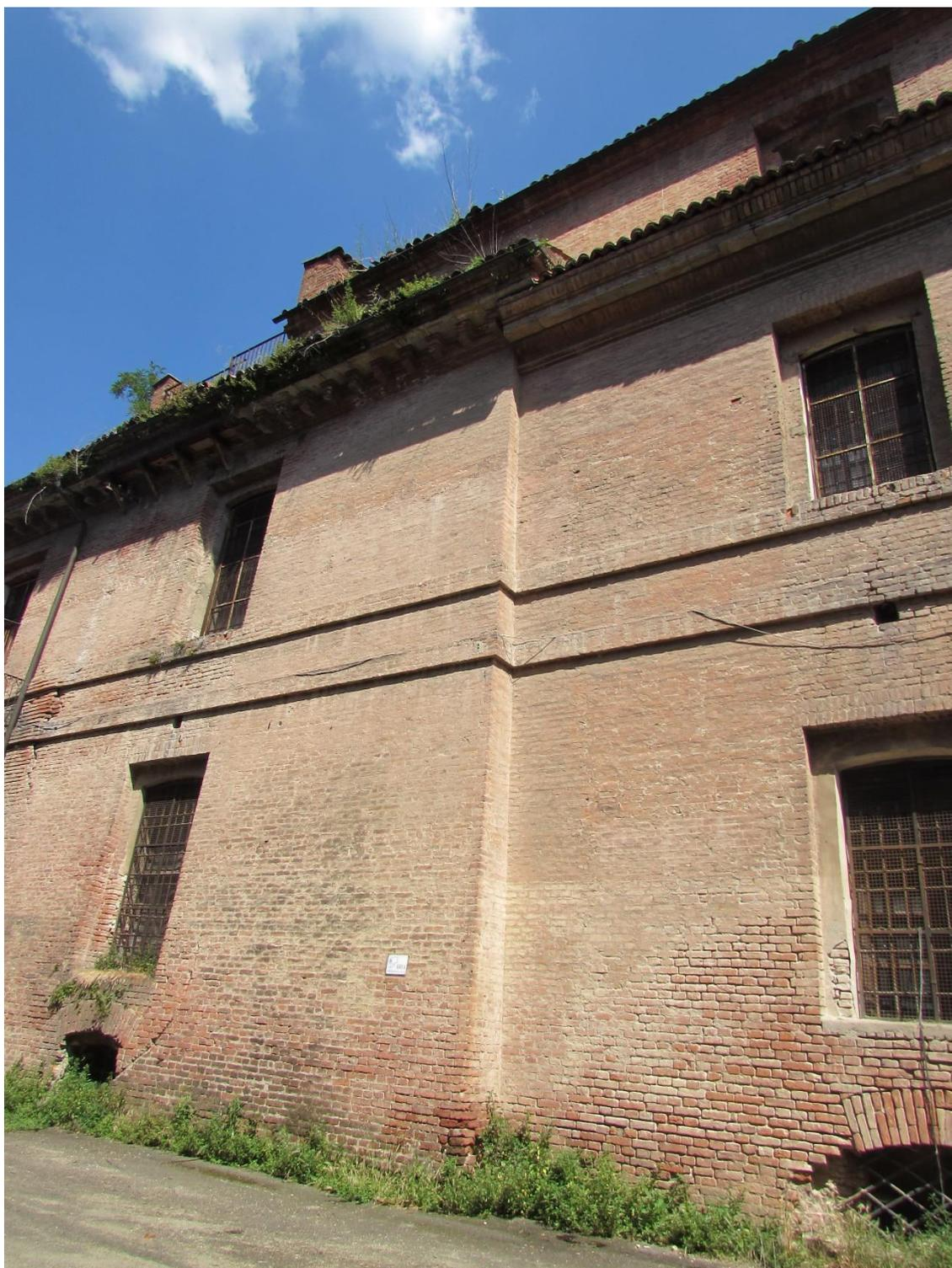
Foto 11. Intersezione del blocco della manica principale con muro a scarpa con quello della manica Nord-Ovest con muro a piombo.
