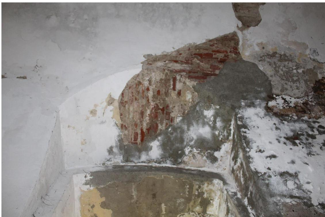
Foto 33. I mattoni della lunetta (senza arco di appoggio) e quelli della volta alla prova si incontrano lungo la linea di spigolo.
