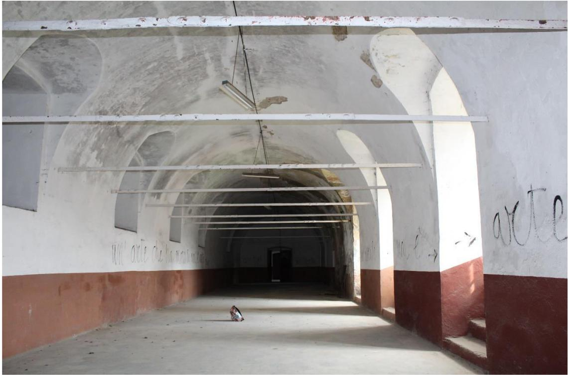
Foto 31. Ambiente voltato con volta ellittica alla prova rinforzata da catene al piano primo della manica principale.
