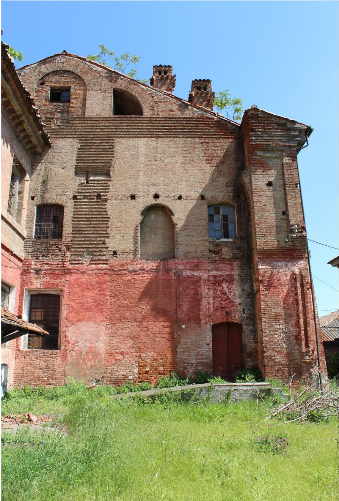
Foto 7. Sezione trasversale della manica Sud-Est. Rappresenta il progetto originale dei detta manica rimasto incompleto.
