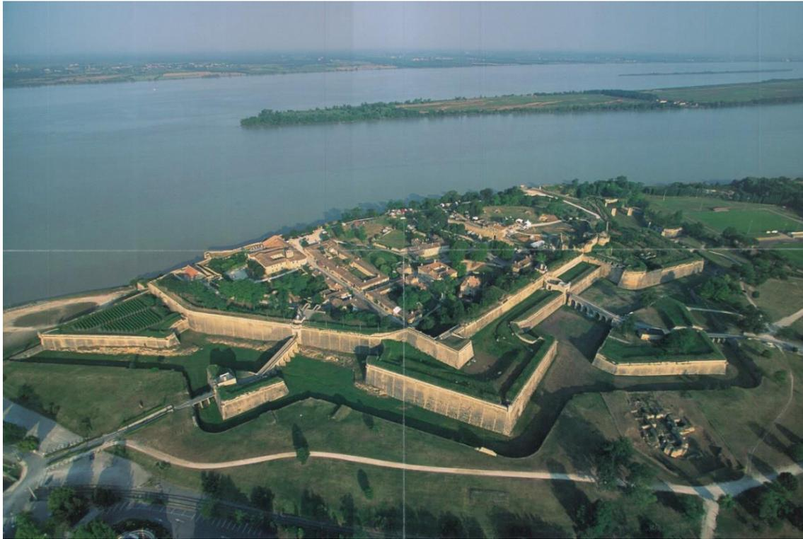
Fig. 19. Blaye, cittadella francese, costruita tra il 1652 e il 1689 con la collaborazione di Vauban. Presenta un tracciato bastionato a mezza stella, con opere avanzate, circondato da un fossato; le murature sono spesse, rivestite in terrapieno. (Foto di F. Lechenet)
