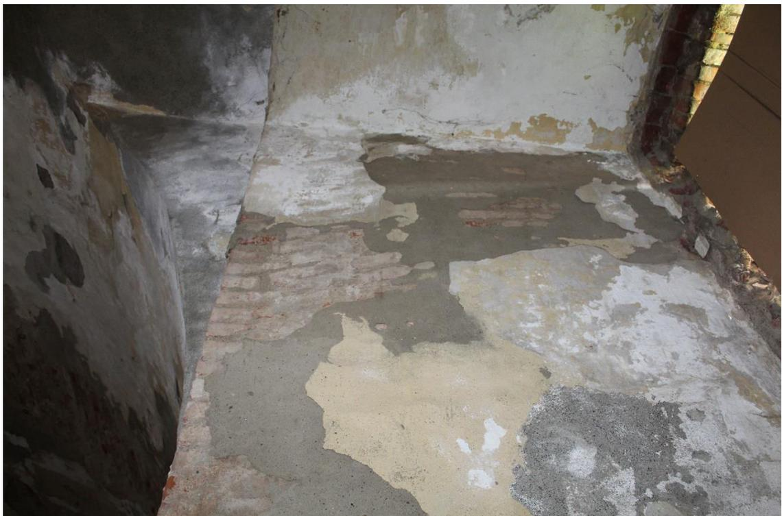
Foto 32. Ghiera della volta alla prova visibile sullo stipite strombato della finestra.
