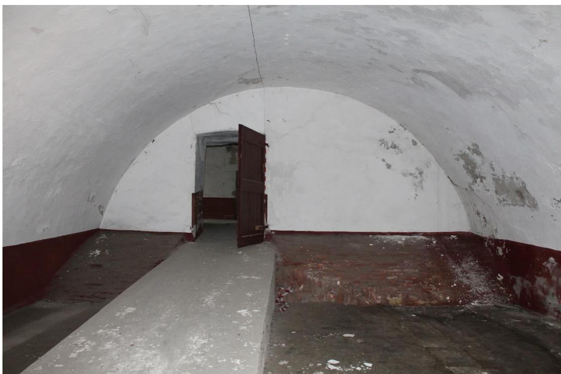
Foto 34. L'estradosso delle volte alla prova del piano primo della manica principale emerge dal pavimento del piano attico.
