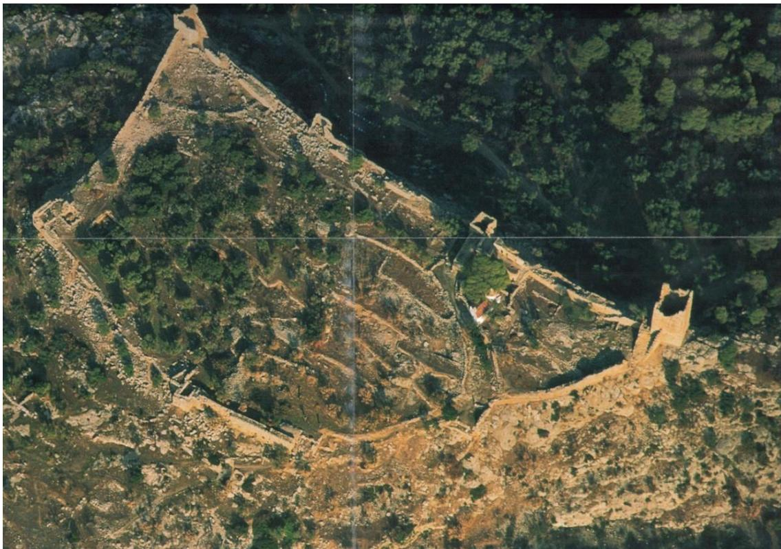
Fig. 8. Egostena, fortezza greca, risalente al V-IV secolo a.C. Opera costruita con grandi blocchi a spigoli vivi e a bugne in strati regolari sulla roccia. (Foto di G. Gerster)
