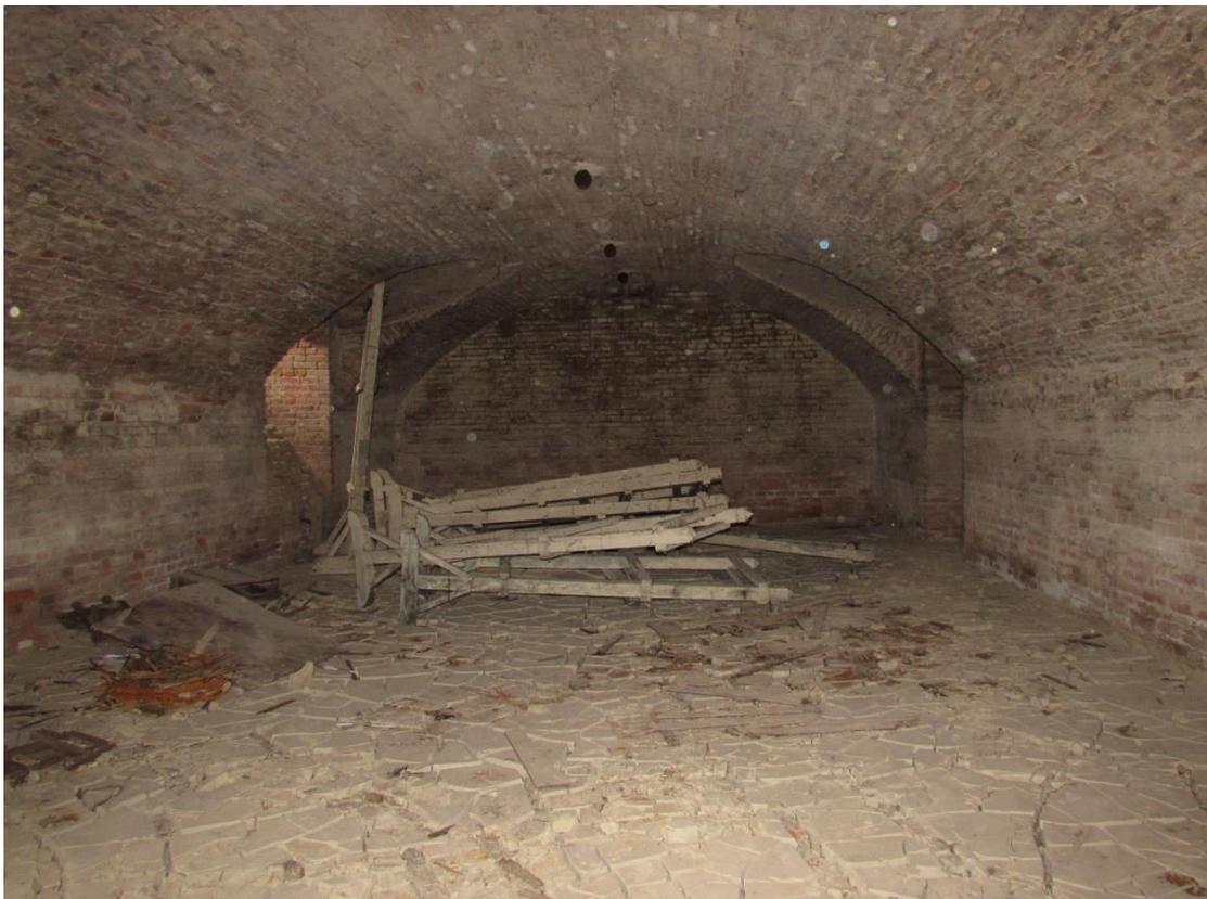
Fig. 68. Strati di fango asciutto nel sotterraneo del quartiere S. Carlo.
