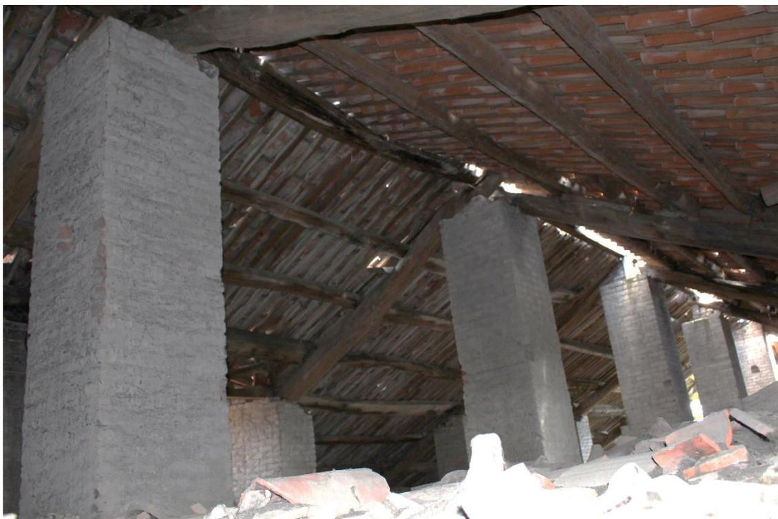
Foto 25. Copertura lignea della manica Sud-Ovest. Si estende questa tipologia di copertura a tutto il complesso edilizio, ad eccezione della manica principale.
