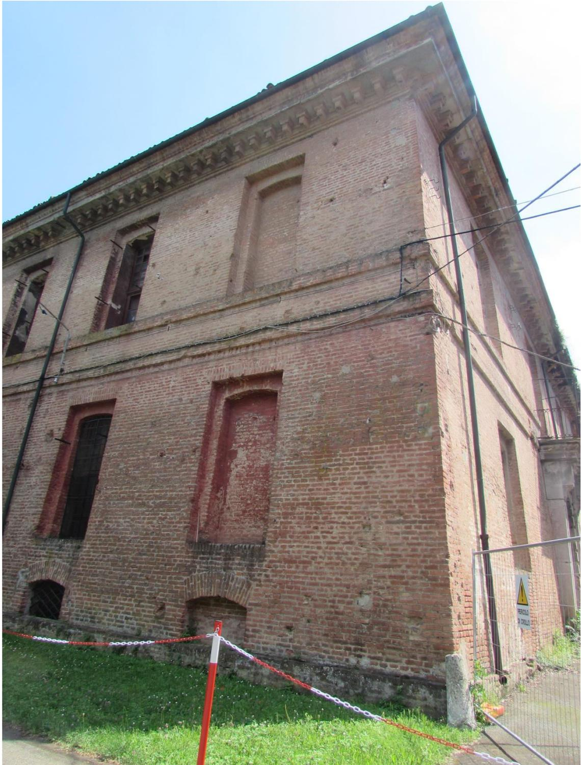
Foto 4. Muro a scarpa della manica principale della caserma.
