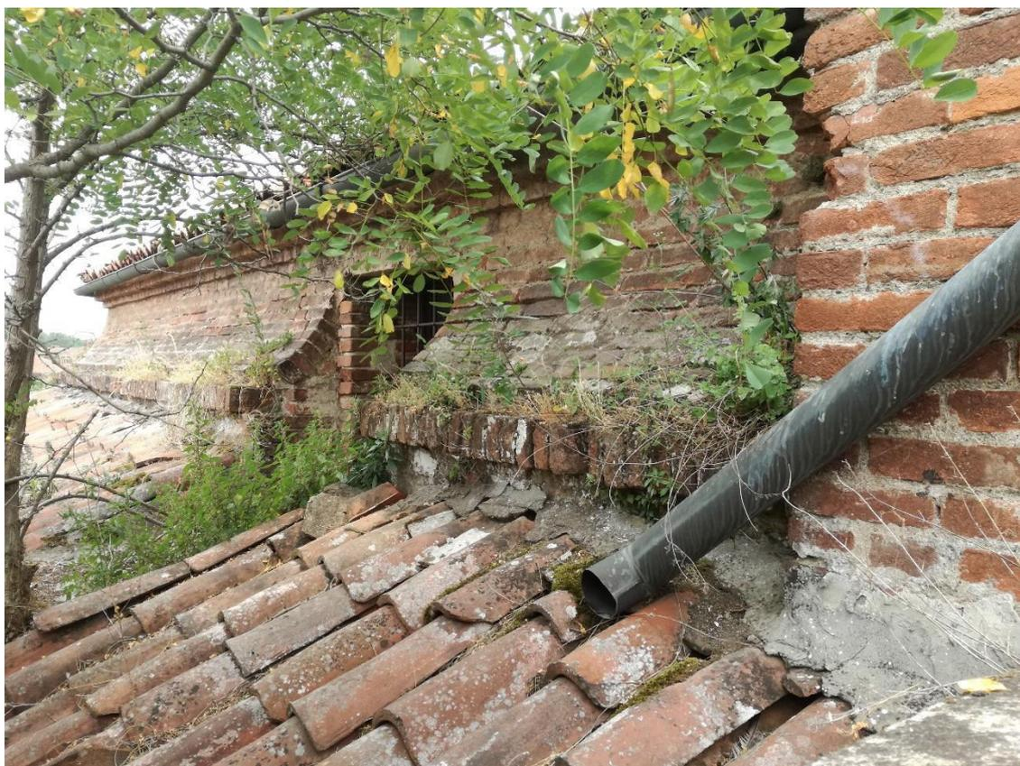
Foto 22. Aperture del piano attico della manica principale ricavate nel tetto a falde a diversi livelli.
