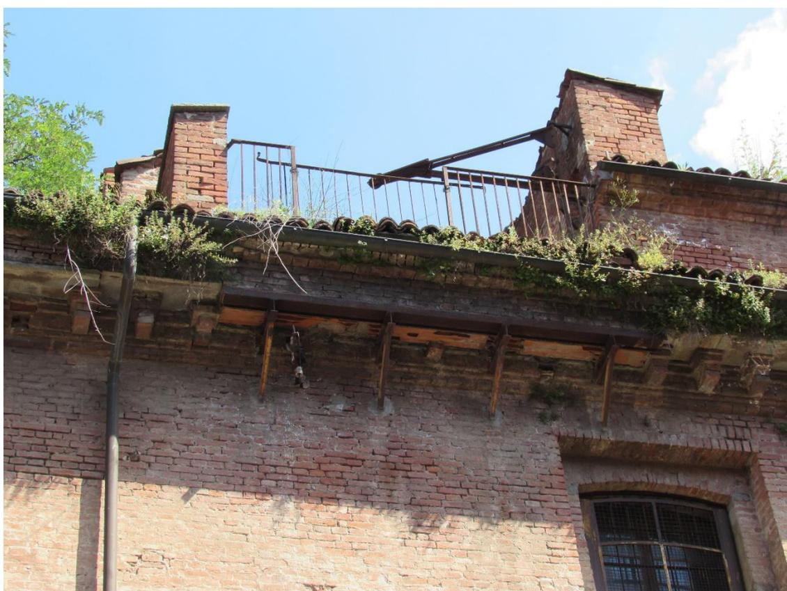
Foto 23. Terrazzino ricavato al piano attico della manica principale (sul lato Nord-Ovest) attraverso il taglio della copertura intermedia.
