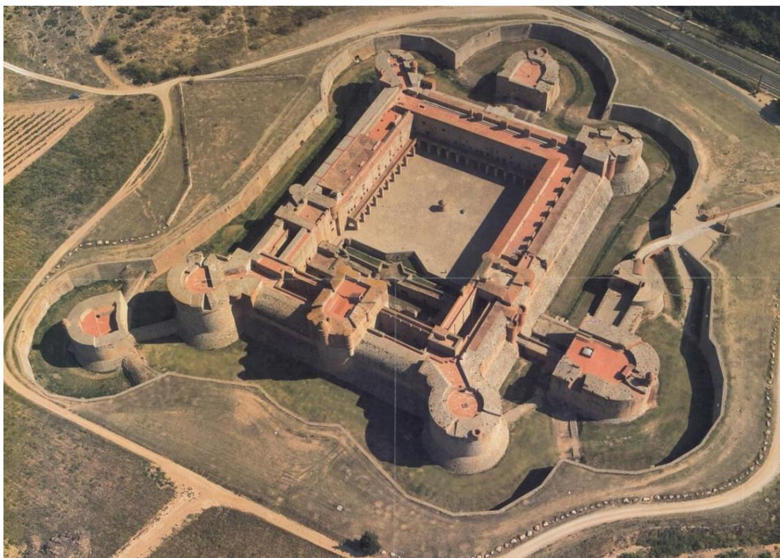
Fig. 16. Salses, forte francese, costruito nel 1497. Opera di transizione tra il castello medievale, con mastio e torri, e la fortificazione moderna geometrica, con muri profondi a scarpa, in muratura e mattoni, e fossato circostante. (Foto di B. Cusa)
