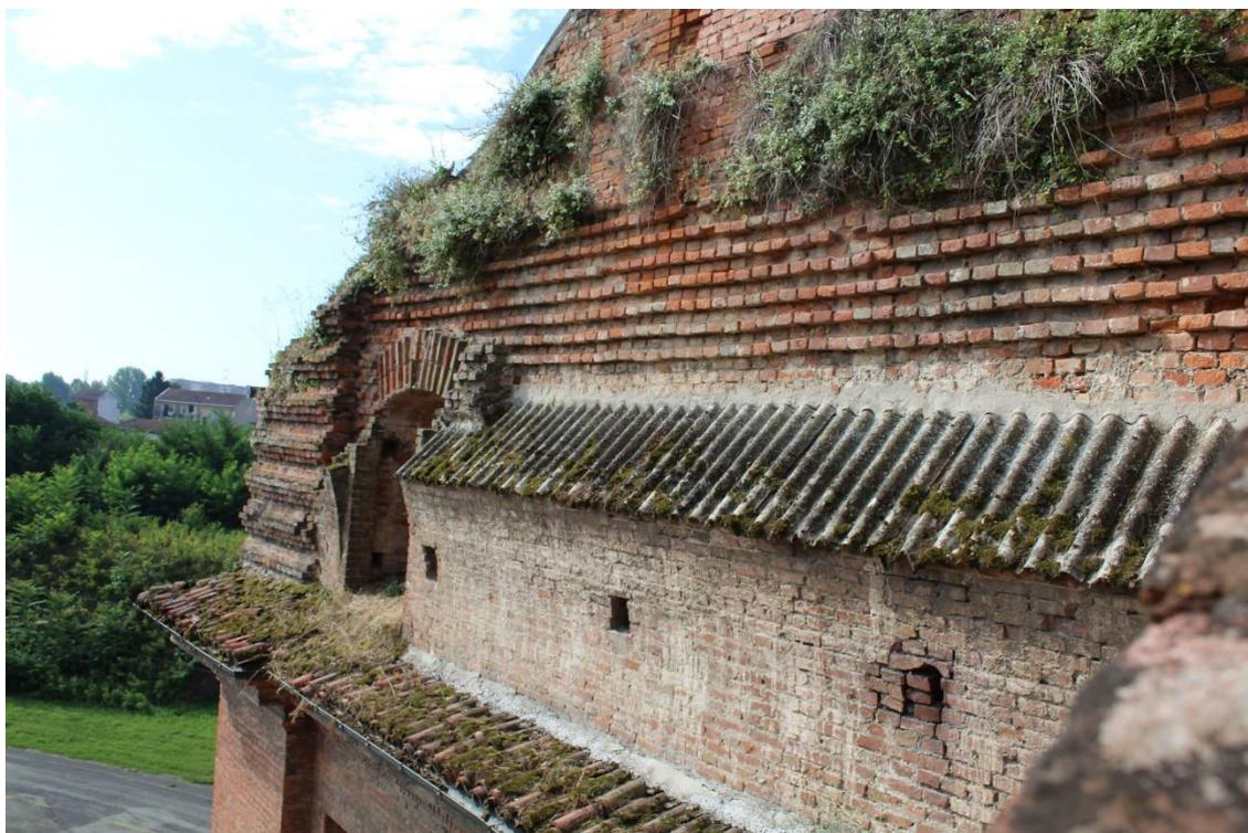
Foto 15. Prospetto interno della manica Sud-Ovest in quella porzione in cui le morse d'attesa attestano che qui vi sarebbe dovuta appoggiare la manica Sud-Est nel suo progetto originario.
