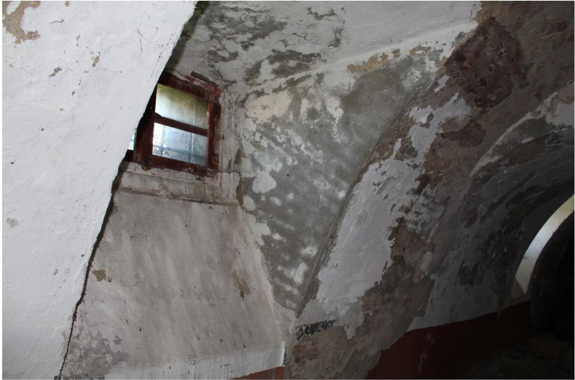
Foto 37. Ghiera della volta alla prova del piano attico visibile sullo stipite dall'apertura della finestra.
