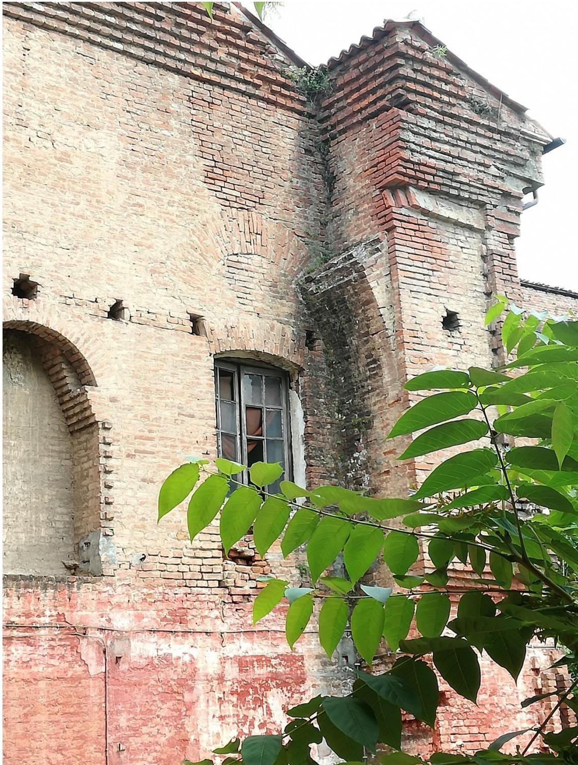
Foto 38. Imposta della volta alla prova incompleta della manica Sud-Est.
