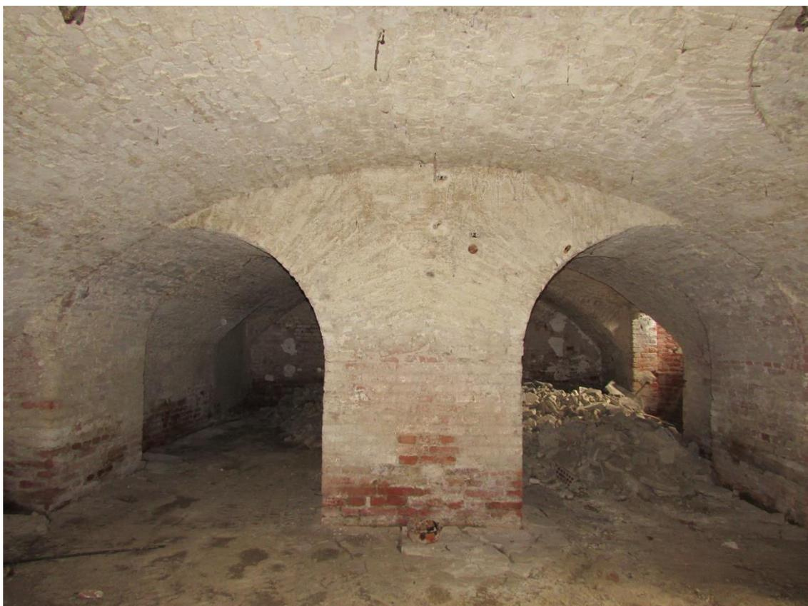
Foto 29. Archi del piano interrato che sorreggono i muri di tramezza del piano terra della manica principale sul lato Piazza.
