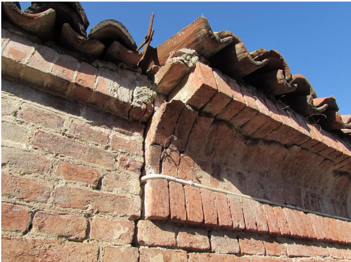
Fig. 52. Cornicione della Polveriera S. Michele.
