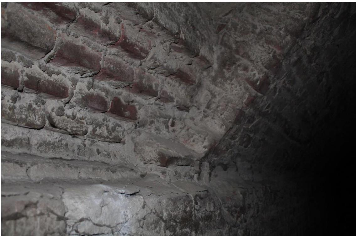
Foto 27. Dettaglio delle sedi d'attesa su cui si impostano le volte a due teste dei sotterranei del quartiere S. Carlo; si pensa di poter estendere lo stesso sistema anche ai sotterranei e a tutte le altre volte a due teste del quartiere S. Michele.
