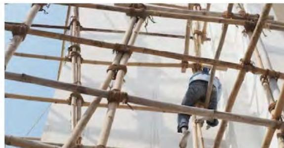
Figura 404. A destra. Ponteggi in bambù legato con legatura diagonale, <https://www.shutterstock.com/search/bamboo+scaffolding>.
