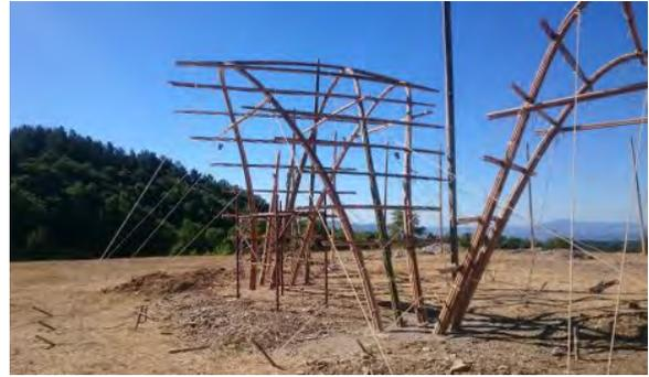
Figura 281. A sinistra. Fascio composto da due canne di bambù collocato in chiave.
