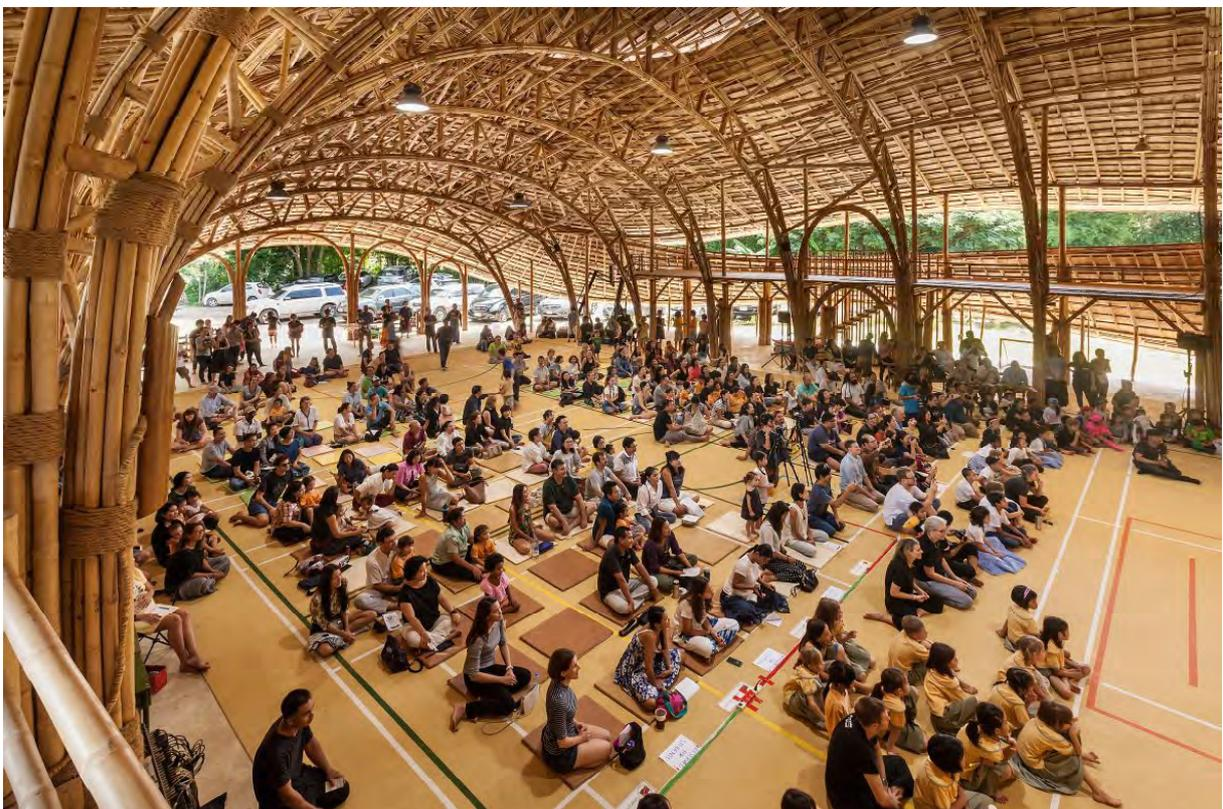
Figura 70. Alberto Cusi, La sala è coperta da un intricato traliccio strutturale in bambù lasciato a vista, <http://www.ingegneri.info/news/strutture/strutture-in-bambu-il-prefabbricato-per-lo-sport-di-una-scuola-buddista-in-thailandia/>
