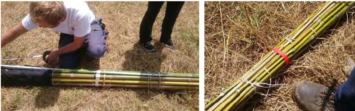
Figura 232. A sinistra. Misura della lunghezza totale dell'arco con un metro a nastro.
