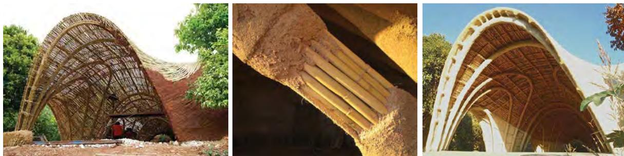
Figura 255. A sinistra. Casa de Laila. Primo strato di rivestimento della struttura con terra cruda, <http://canyaviva.com/proyectos-permanentes.html>, consultato il 10/04/2018.
