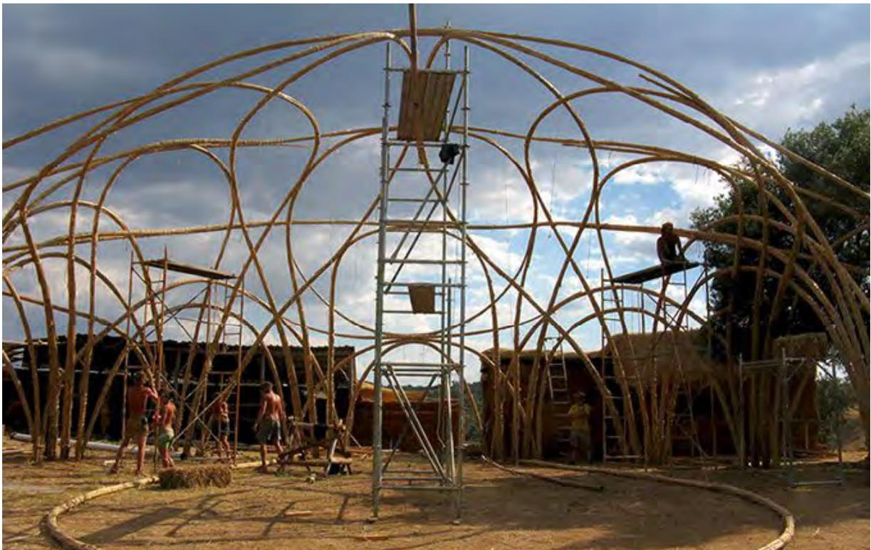
Figura 181. CANYAVIVA, Struttura in canna per il palco del Boom Festival a Idanha Nova, 2008, <http://canyaviva.com/proyectos-efimeras.html>, consultato il 10/04/2018.
