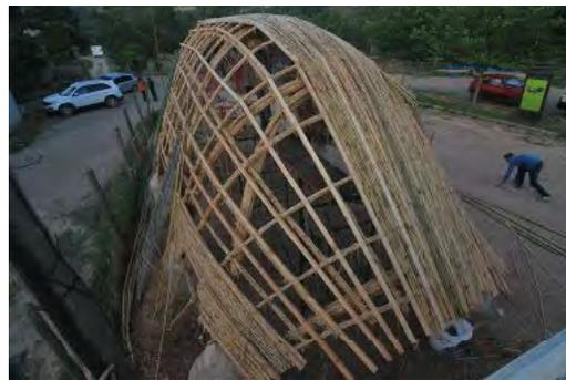
Figura 292. Strisce di bambù splittato sopra la maglia ortogonale, <http://canyaviva.com/proyectos-permanentes.html>
