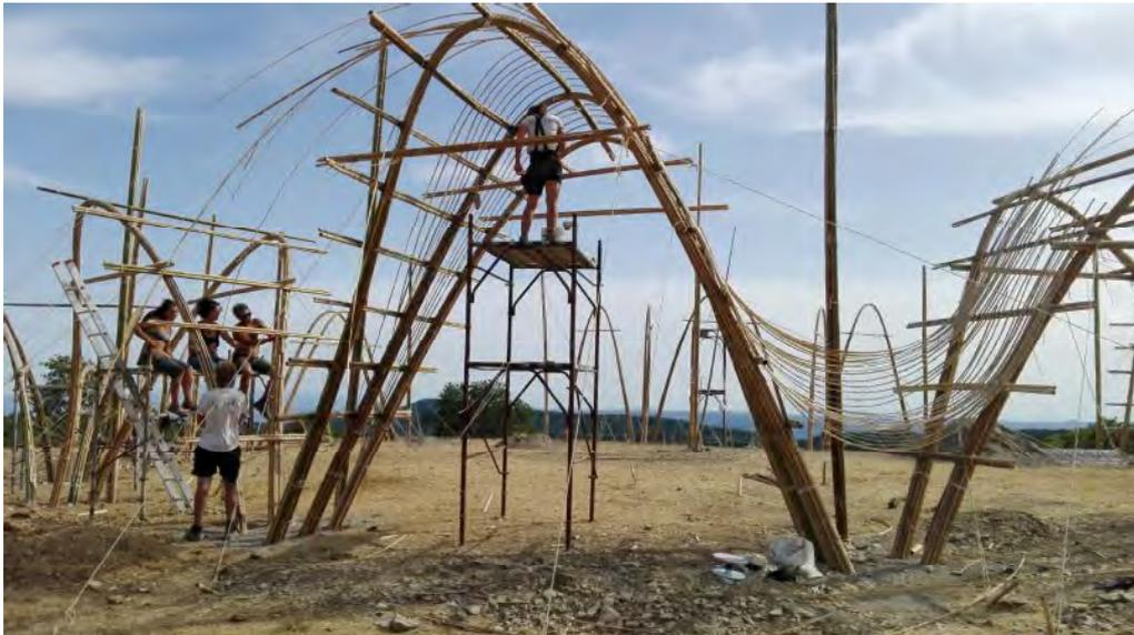
Figura 288. Tre persone lavorano alla legatura dei fasci su un arco e una persona sulla legatura delle strisce sull'arco successivo.
