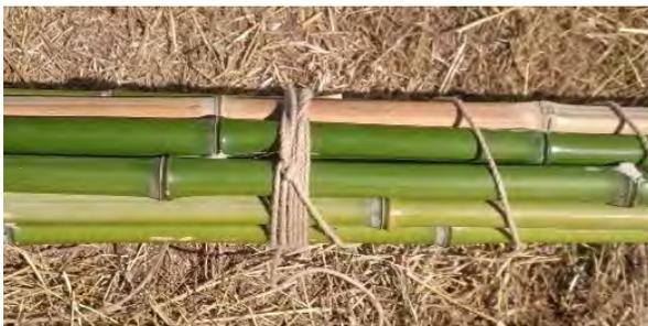
Figura 314. Nodo parlato triplo eseguito sui punti V di un arco.
