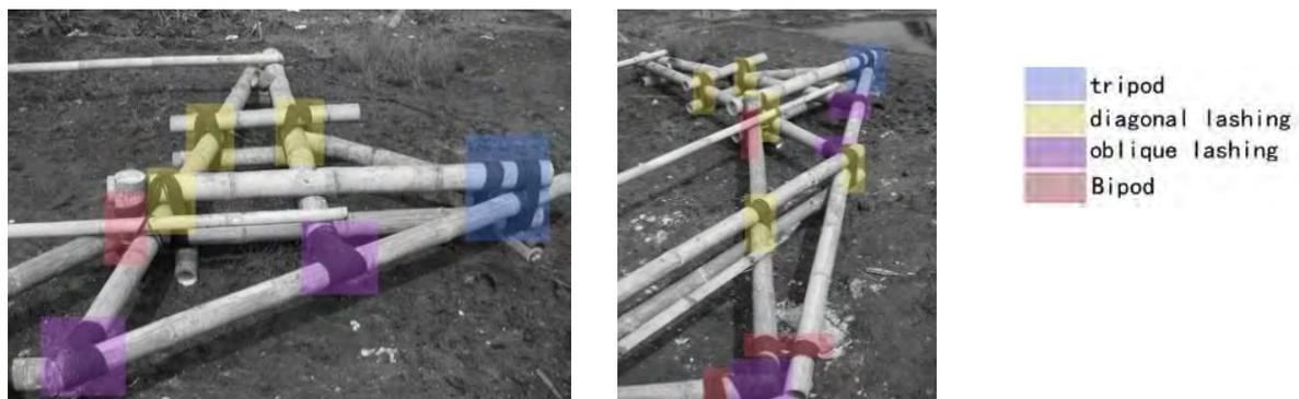
Figura 172. Tipologie di legature impiegate evidenziate per colore: in viola la legatura obliqua; in blu la legatura treppiede; in giallo la legatura diagonale; in rosso la legatura bipiede, in OSCAR HIDALGO LOPEZ, Bamboo: The gift of the Gods, Bogota, 2003.
