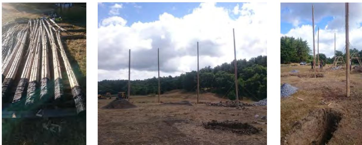
Figura 252. A sinistra. Si notino le basi dei fasci impermeabilizzate.
