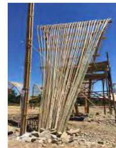
Figura 285, 286. A sinistra, al centro. Orditura con fasci di doppie canne e strisce di bambù splittato.
