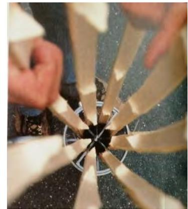
Figura 278. A sinistra. Bambù splittato, pronto per essere impiegato sopra i fasci della copertura.
