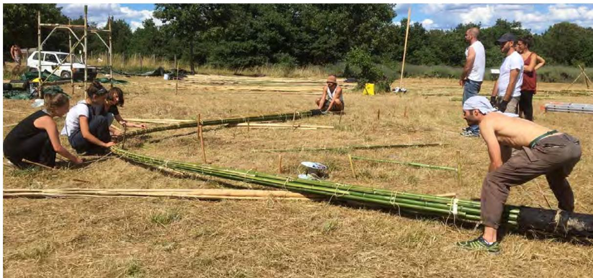
Figura 240. Incurvatura dell'arco. Si notino una persona in chiave che guida il movimento (le altre due persone sono apprendisti), due persone che sollevano le basi incatramate dell'arco, e due persone che tirano le basi tramite una corda.
