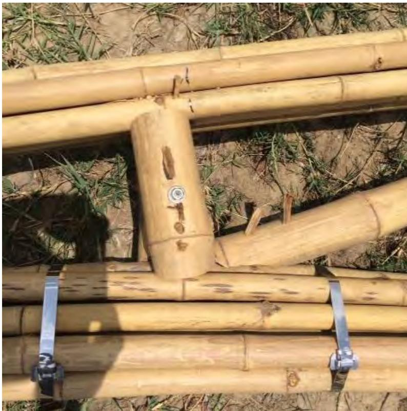
Figura 89. Connessione. Fascette metalliche che connettono le canne di un fascio, e filetti inbullonati che connettono il montante. Si notano inoltre i bastoncini di bambù che connettono le canne del fascio.
