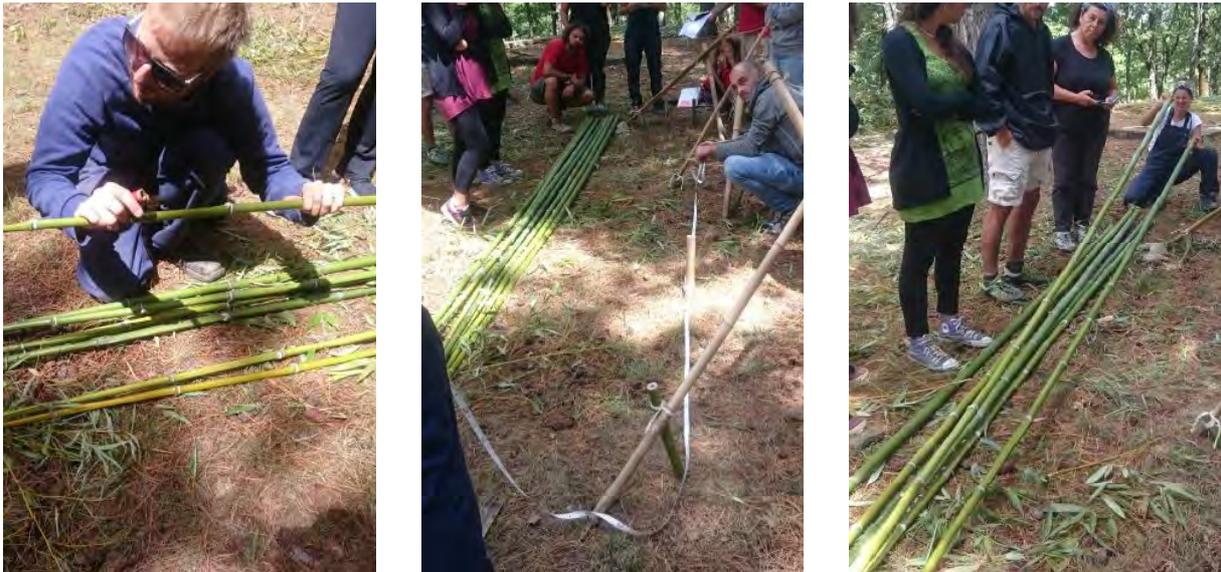
Figura 202. A sinistra. 7 canne della stessa lunghezza e stesso senso di torsione. Scelta delle 5 canne dal diametro maggiore (in figura sono quelle prossime al soggetto) e le due canne dal diametro minore.
