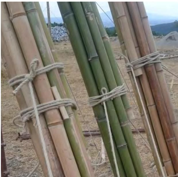
Figura 315. Si notano il nodo parlato triplo fatto durante la costruzione dei fasci, e le corde di ancoraggio legate provvisoriamente sugli archi con nodi occhielli.
