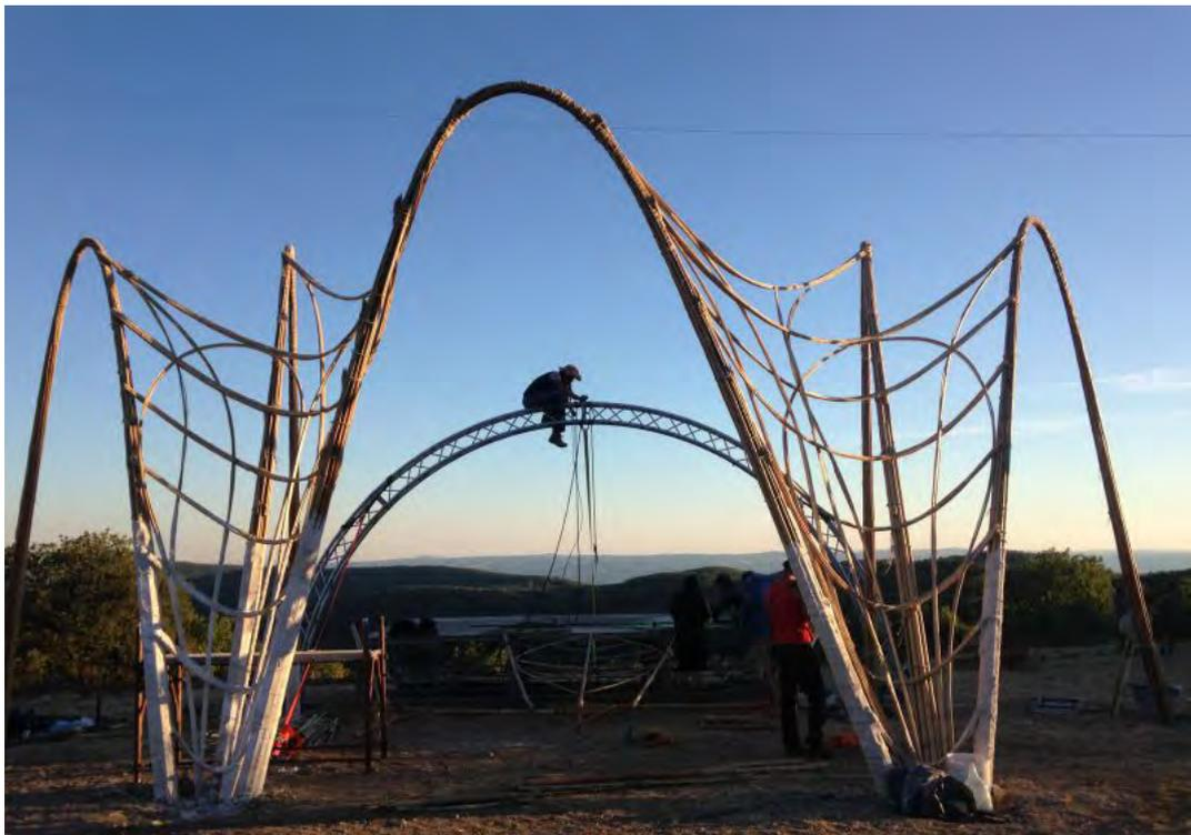
Figura 311. Struttura in Arundo donax per la copertura del palco. La parte bassa degli archi è rivestita in gesso
