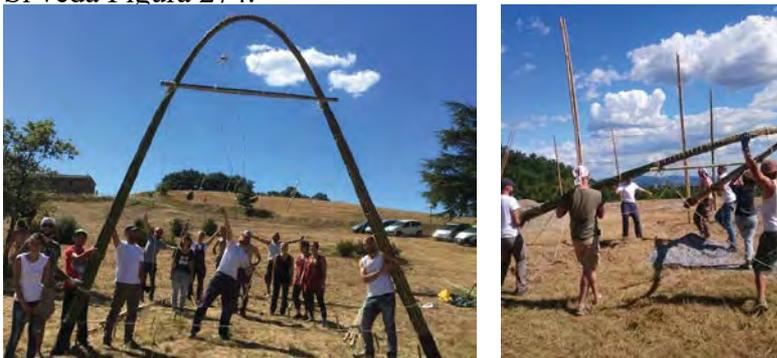
Figura 269. L'arco incurvato viene innalzato. L'incurvatura viene mantenuta dalla catena e dalla corda fissata tra le basi.
