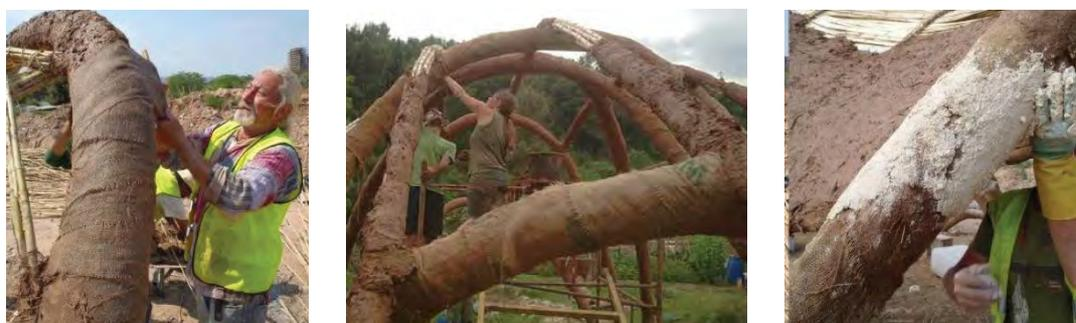
Figura 258. A sinistra. Rivestimenti impermeabilizzanti per aumentare la durabilità delle canne: terra cruda e fibra di canapa, <https://investigaciocanyera.wordpress.com/>, consultato il 5/01/2018.
