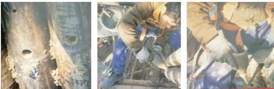
Figura 124, 125, 126. A sinistra, in centro, a destra. Zeri Foundation, Sistema di giunto di bambù sviluppato da Simón Vélez, l'estremità delle canne sono riempite di cemento e connesse con elementi metallici, in J. DETHIER *et al.*, *op. cit.*, p. 115.
