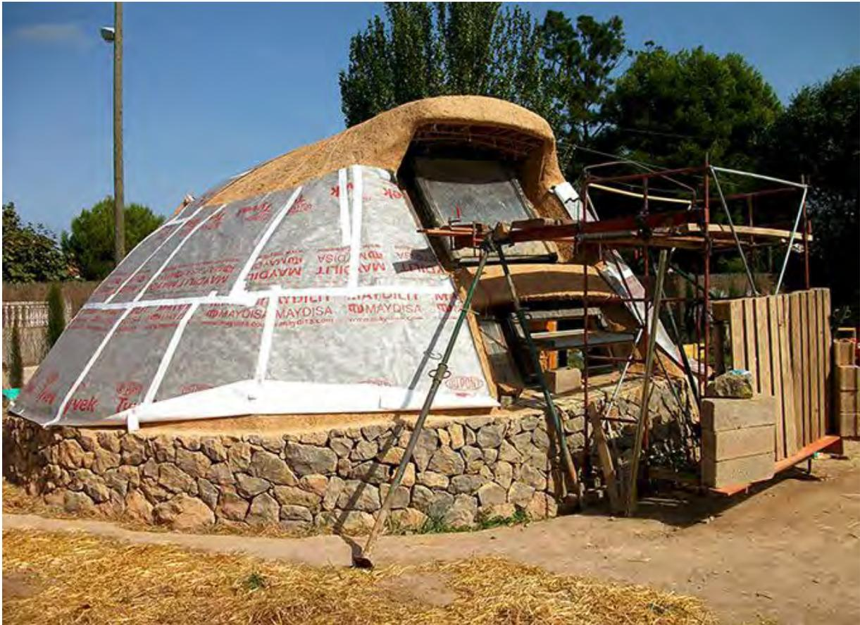
Figura 184. CANYA VIVA, Domo Burriana, Castellón de la Plana, 2009. Struttura in canna, paglia come materiale isolante, e membrana impermeabilizzante. Rivestimento esterno in sughero naturale. Rivestimento interno con intonaco, <http://canyaviva.com/proyectos-domos.html>, consultato il 10/04/2018.
