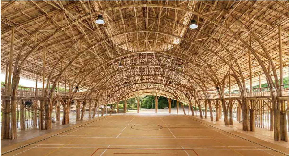
Figura 69. Alberto Cusi, L'arena per lo sport, spettacoli e assemblee coperta da un intricato traliccio strutturale in bambù, <http://www.ingegneri.info/news/strutture/strutture-in-bambu-il-prefabbricato-per-lo-sport-di-una-scuola-buddista-in-thailandia/>, consultato il 28/07/2018.
