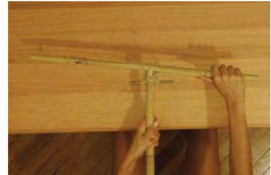
Figura 423. A sinistra. La legatura viene completata con un doppio giro orizzontale per “strozzare” le legature verticali, eseguito nello spazio tra lo spinotto e il nodo della canna verticale.
