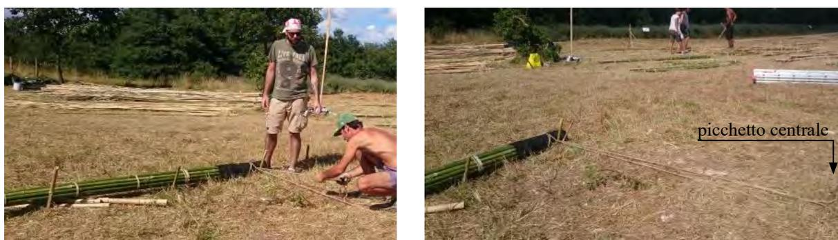
Figura 241. A sinistra. I soggetti in figura stanno fissando la corda dell'estremità dell'arco con un nodo piatto
