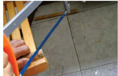
Figura 413. A sinistra. Taglio lungo il tracciato orizzontale.
