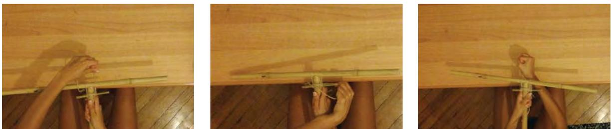
Figura 420 A sinistra. Il corrente, partendo dal lato destro del nodo, fa un giro attorno allo spinotto e un giro attorno alla canna orizzontale. Successivamente fa un secondo giro attorno allo spinotto per poi dirigersi in orizzontale verso il lato sinistro del nodo in cui vengono compiuti gli stessi movimenti. Una volta completato un giro, se ne fanno altri tre.
