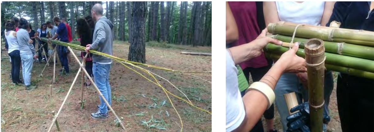
Figura 205. A sinistra. Il nucleo centrale viene appoggiato sopra i tre treppiedi. Sono necessarie almeno tre persone.
