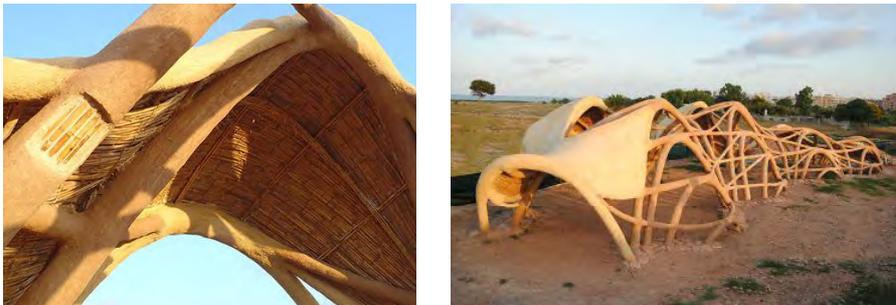
Figura 296. Orditura composta da fasci di due canne e strisce di bambù splittato, ibid.
