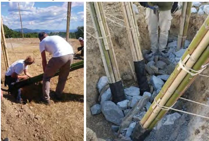
Figura 271. Posizionamento dell'arco nello scavo di fondazione.
