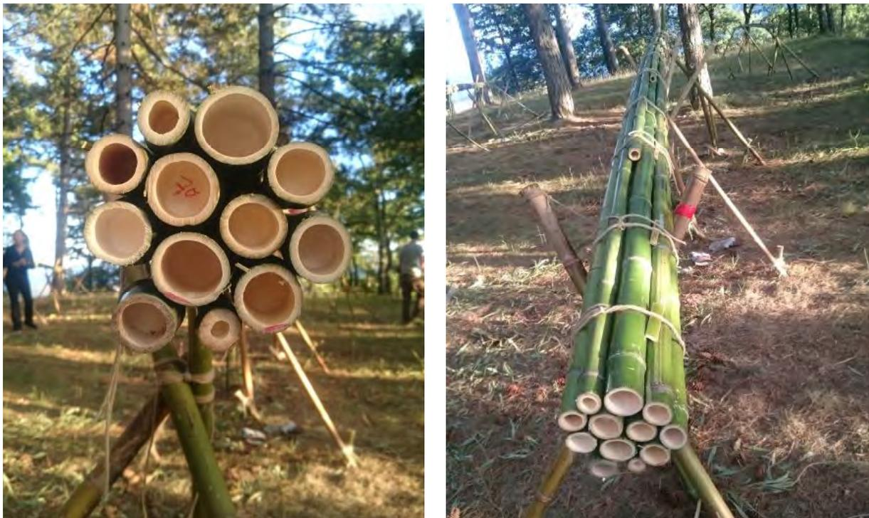
Figura 216. A sinistra. Base di un fascio di 7+5 canne con torsione oraria e lunghezza pari a 7 m. Si noti evidenziato in rosso l'intradosso del modulo e 5 canne aggiunte alla base in senso orario per rafforzare l'intradosso del fascio. Con questo fascio si ottiene un arco di 11 m di lunghezza ( $7\text{ m} + 7\text{ m} - 3\text{ m}$ ).
