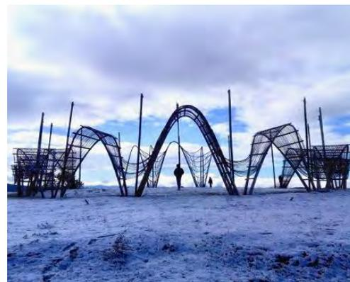
Figura 319. A sinistra. Struttura completata composta da 23 archi di bambù.
