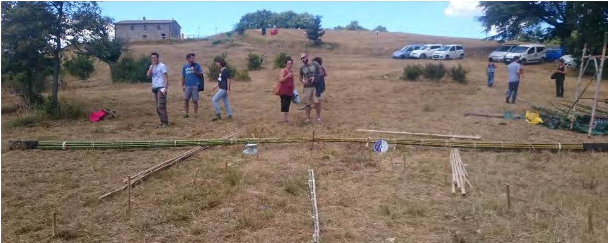
Figura 237. Da questa posizione, avendo collocato la chiave dell'arco nel picchetto centrale, si può procedere alla incurvatura dell'arco.
