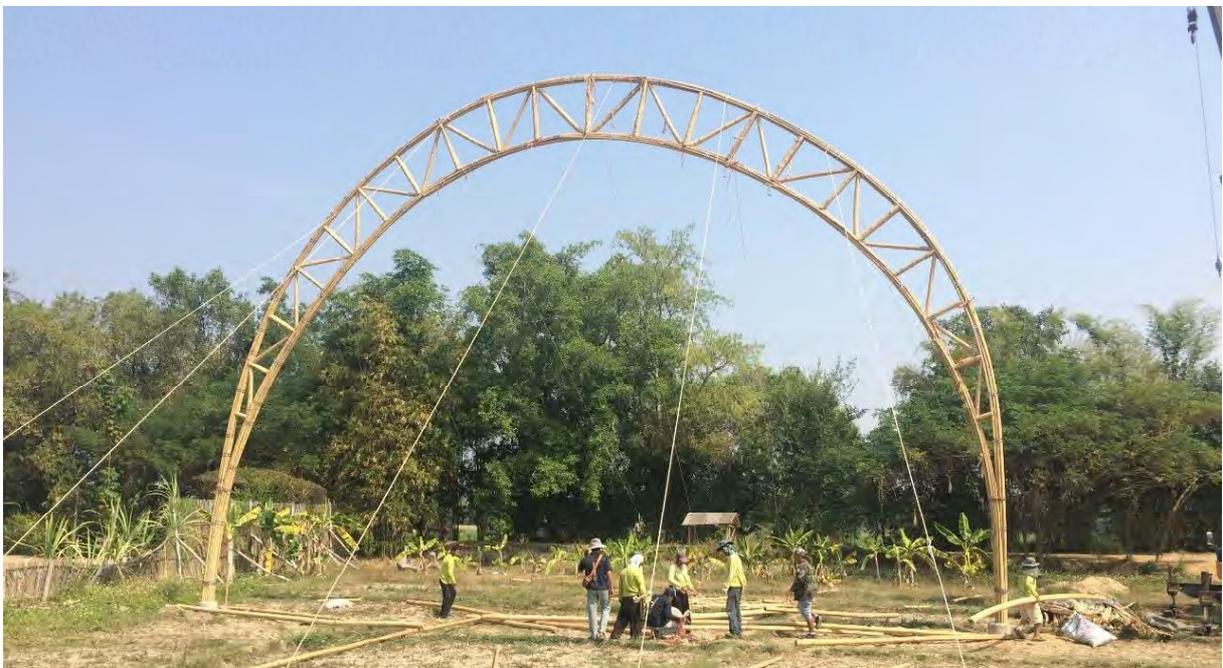
Figura 79. Arco con struttura reticolare costituito da fasci di canne di bambù.
