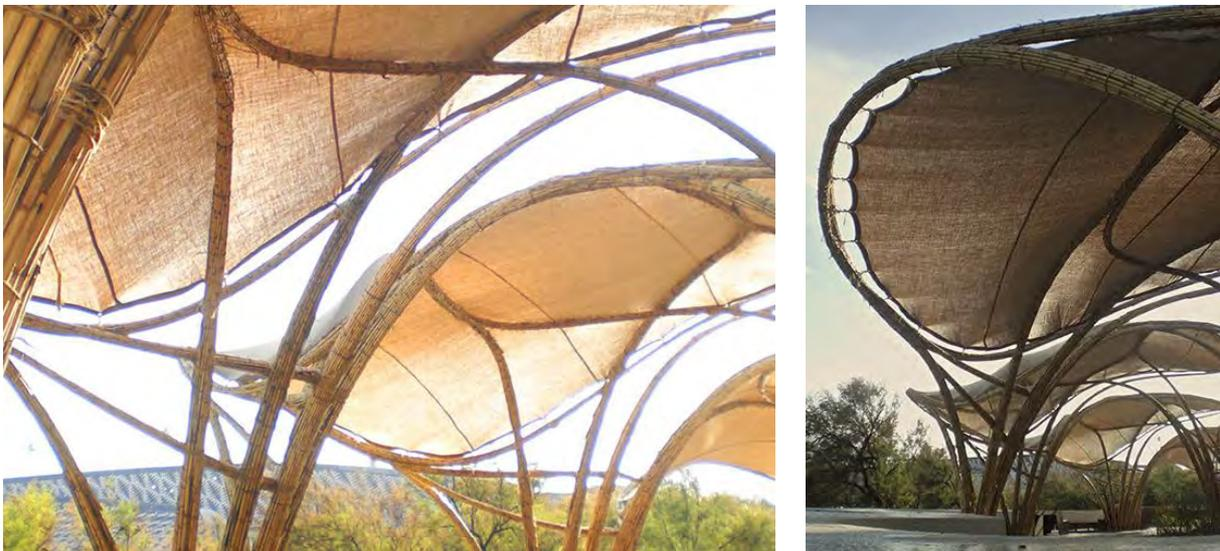
Figura 298, 299. A sinistra, a destra. Struttura in canna *Arundo donax* e manto di copertura in tela di iuta, <http://canyaviva.com/proyectos-efimeras.html>.
