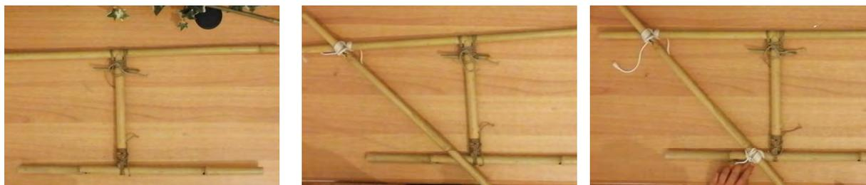
Figura 445. A sinistra. Elemento verticale legato alle canne orizzontali mediante due metodi diversi.
