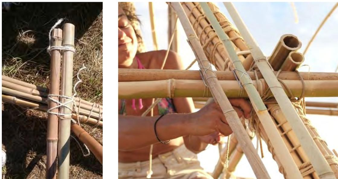
Figura 316. A sinistra. Catena connessa al punto V per mezzo di una legatura diagonale chiusa con nodo parlato ma non bloccata con nodo piano.
