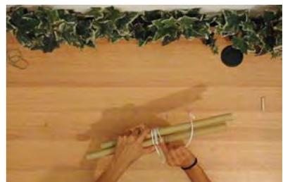
Figura 356. A sinistra. Step 1: il dormiente (capo rappresentato dal pallino pieno) passa sotto le canne e il corrente sopra (quadrato pieno).
