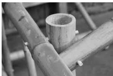
Figura 178. Dettaglio di una connessione realizzata con spinotti in bambù, in CAI LUYANG, op. cit.
