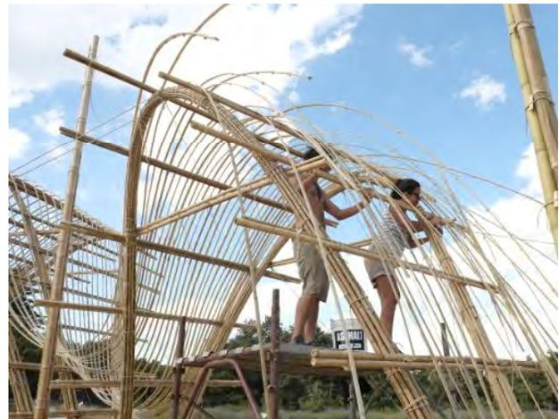
Figura 283. A sinistra. Legatura dei fasci per la copertura con interasse di 1 metro.
