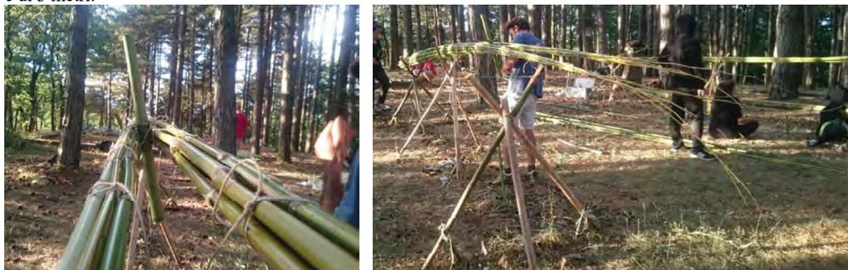
Figura 219, 220. A sinistra, a destra. Diramazione orizzontale del fascio sul punto V in due gruppi.
