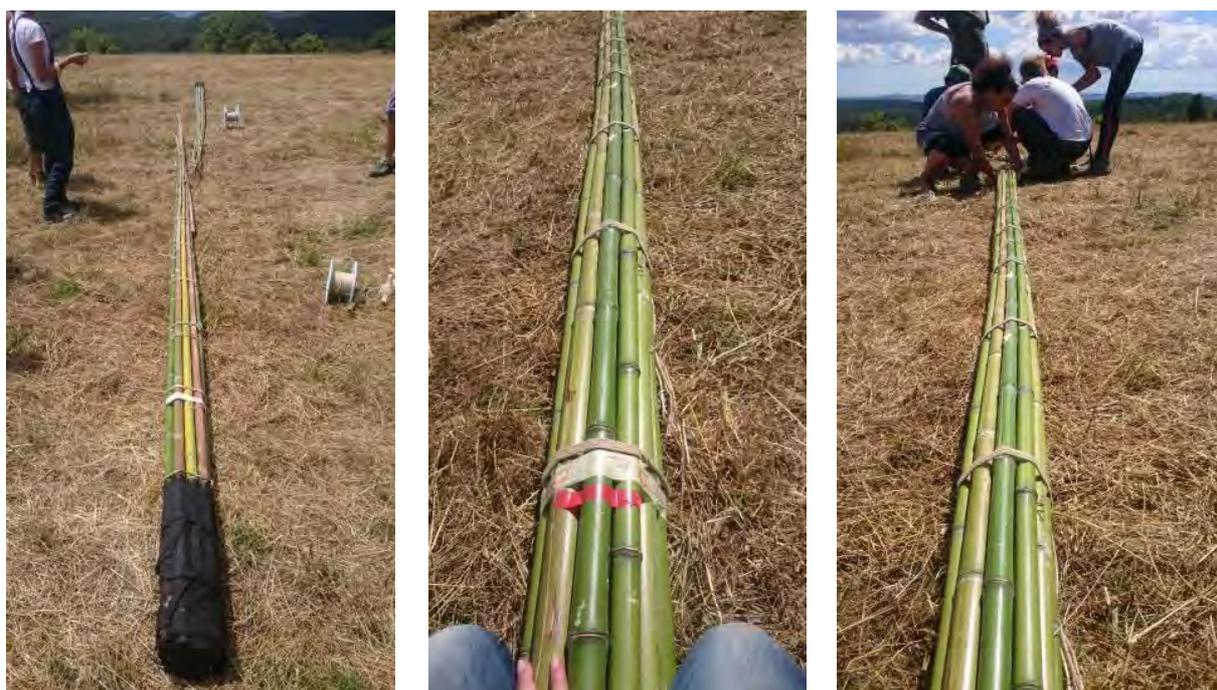
Figura 226. A sinistra. I due fasci che comporranno l'arco: il fascio orario e il fascio antiorario.
