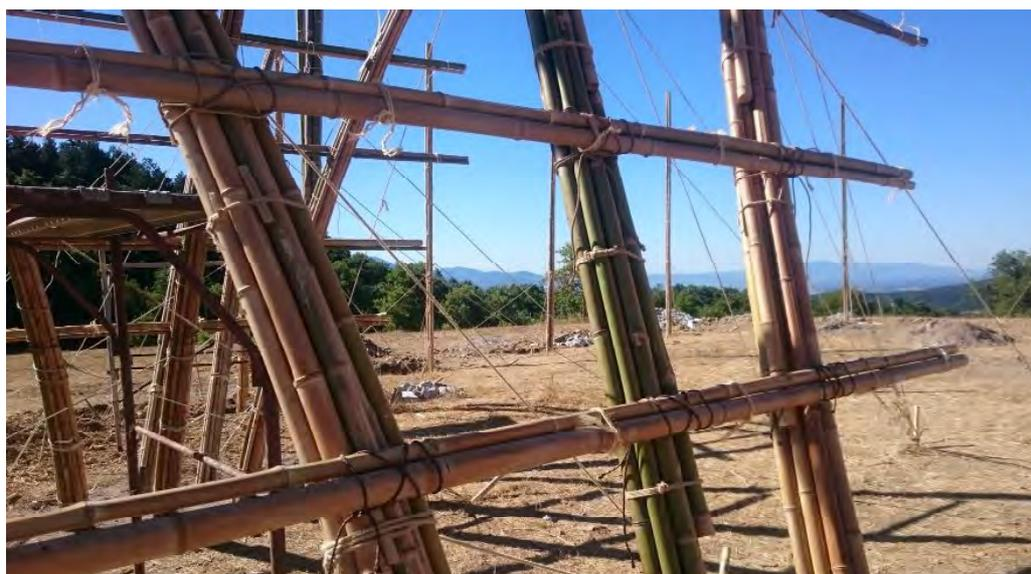
Figura 318. Legatura diagonale chiusa con nodo parlato e bloccata con nodo piano tra gli archi e i fasci per le coperture costituiti da due canne, legate a loro volta con nodo parlato bloccato da nodo piano.
