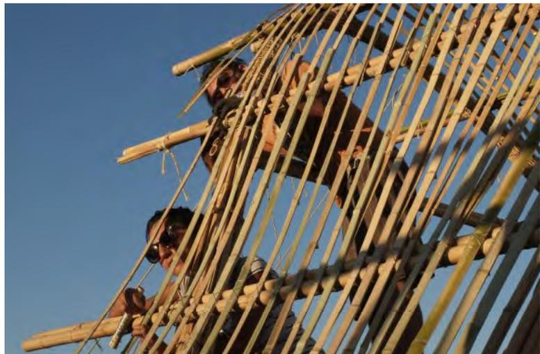
Figura 290. A destra. Legatura diagonale delle strisce sui fasci dell'orditura secondaria.
