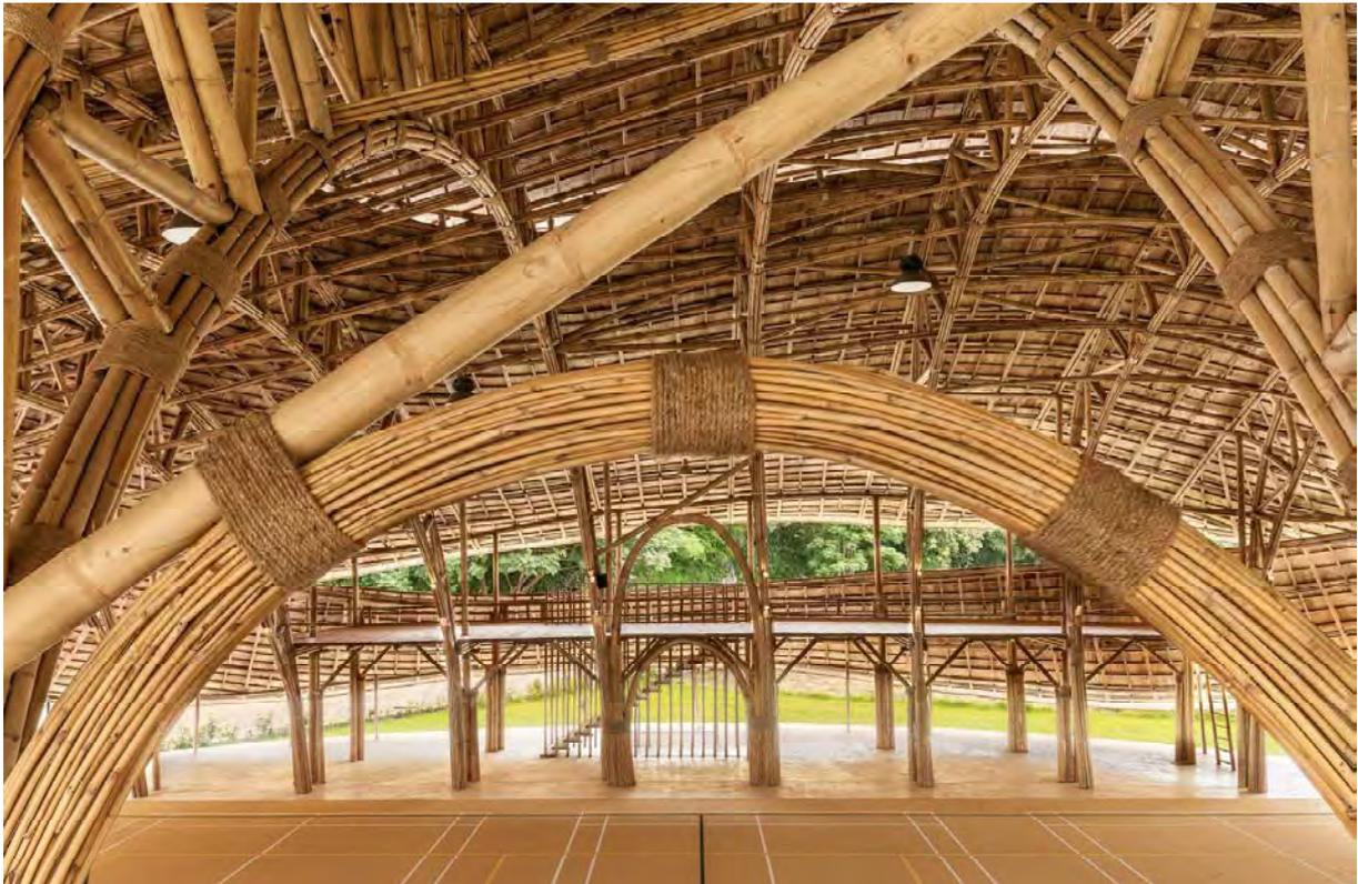
Figura 71. Dettaglio delle legature, <http://www.ingegneri.info/news/strutture/strutture-in-bambu-il-prefabbricato-per-lo-sport-di-una-scuola-buddista-in-thailandia/>
