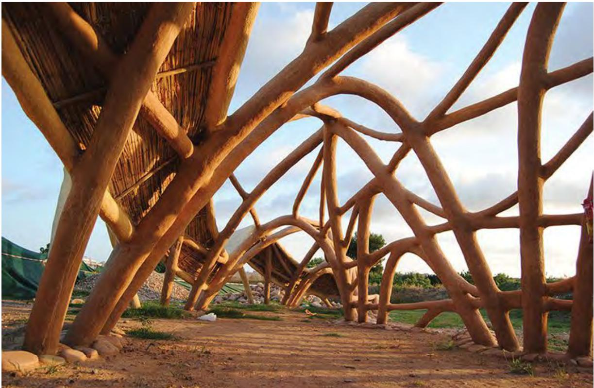
Figura 183. CANYA VIVA, Mirador Sagunto: spazio multiuso per il Parco naturale del Delta, València, 2011. Struttura in canna e finiture in adobe, fibra di canapa, calce e aggregati, <http://canyaviva.com/proyectos-permanentes.html>, consultato il 10/04/2018.
