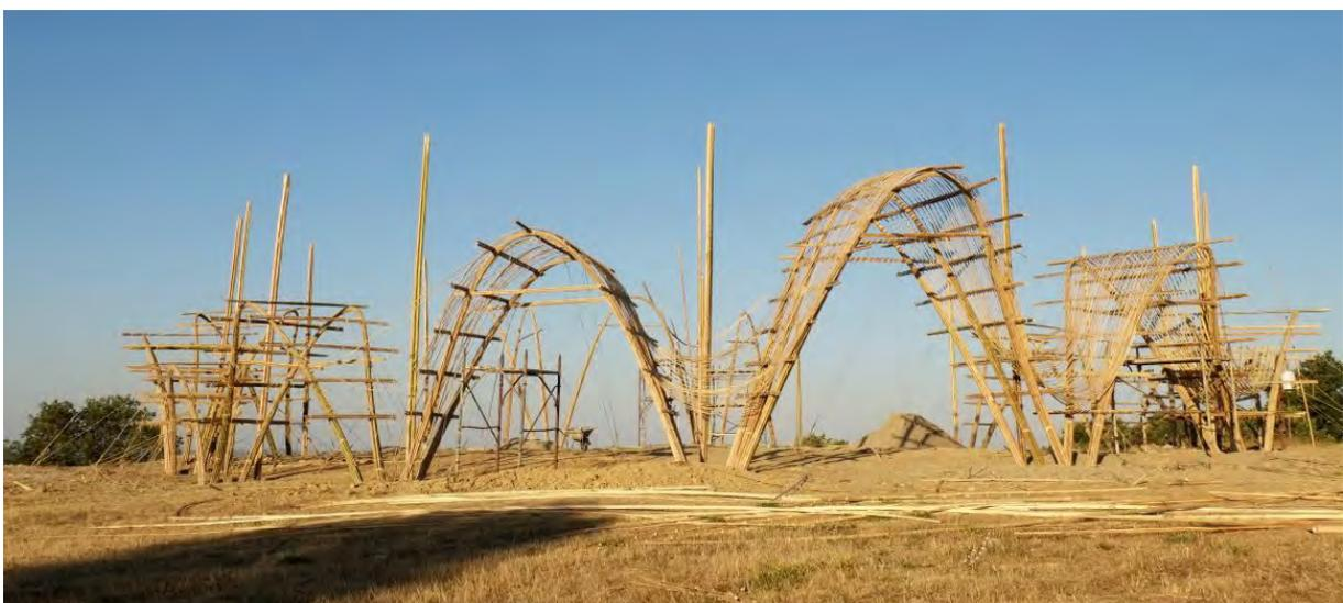
Figura 291. Gruppi di archi di diversa altezza, collegati tramite strisce di bambù.
