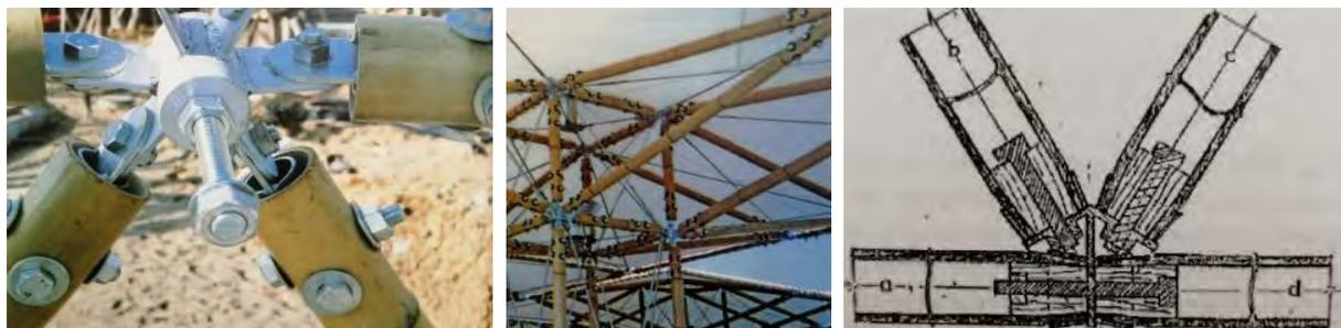
Figure 114, 115. A sinistra, in centro. SHOEI YOH, Nodo multiplo. Diversi culmi confluiscono nel giunto fatto da tubi in acciaio inseriti nel bambù e ad essi connessi mediante bulloni, in M. C. LAVERDE, *Il bambù come materiale da costruzione: caratteristiche fisiche e meccaniche, tecnologie costruttive*, Napoli, Sistemi editoriali, 2008, p. 80.
