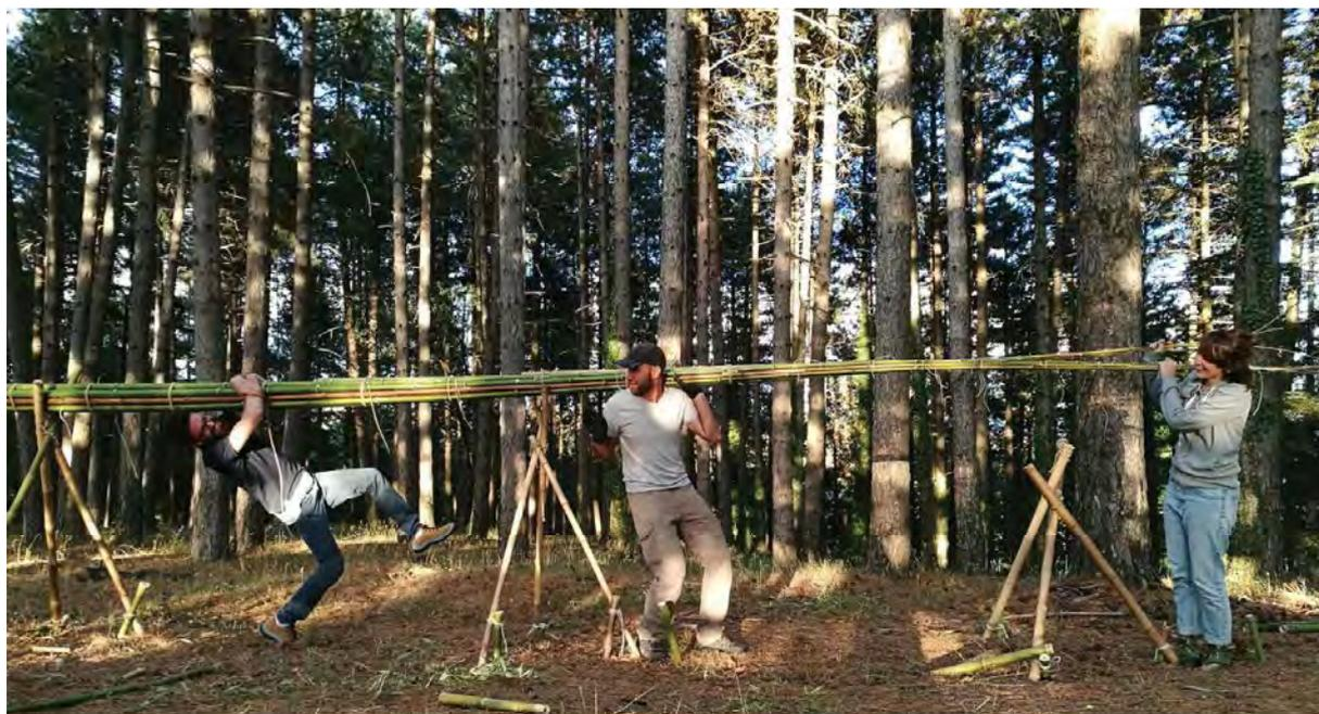
Figura 221. Fascio orario aperto orizzontalmente sul piano xz, pronto per essere trasportato (in cantiere) e connesso all'altro fascio per comporre l'arco.
