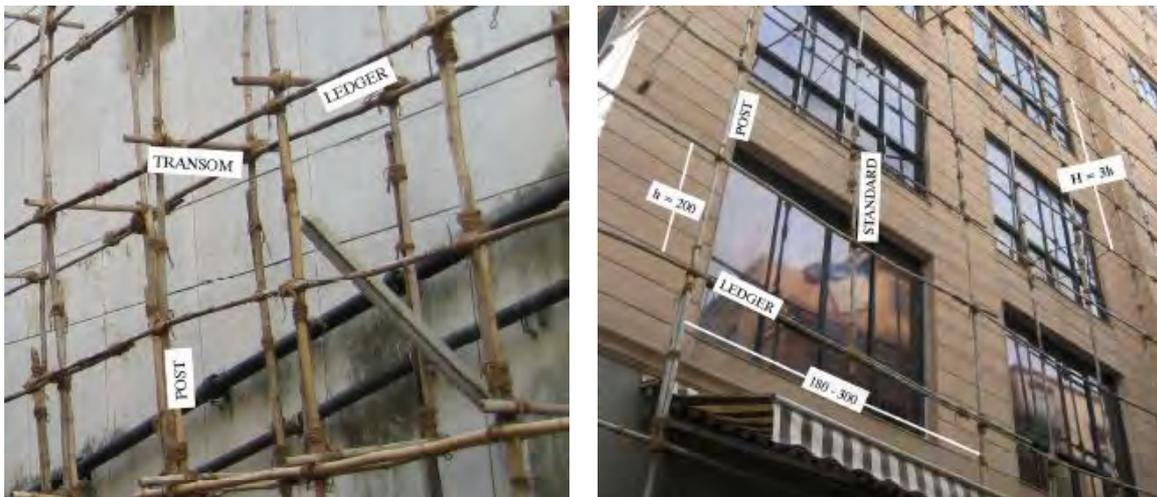
Figura 27, 28. A sinistra, a destra. Elementi che compongono il ponteggio, file:///C:/Users/jessi/Google%20Drive/TESI/081\_Bamboo%20Scaffolds%20in%20India.pdf, consultato il 31/08/2018.
