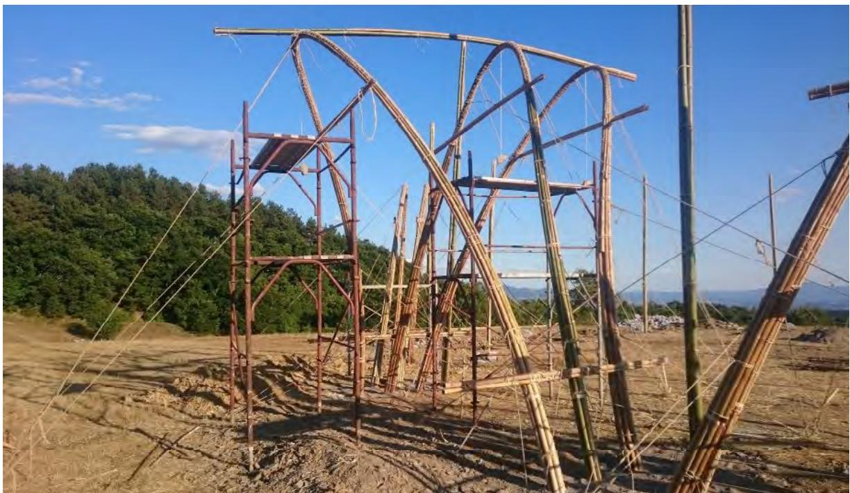
Figura 275. Arco inclinato e fissato con corde di ancoraggio e un fascio di canne in chiave.
