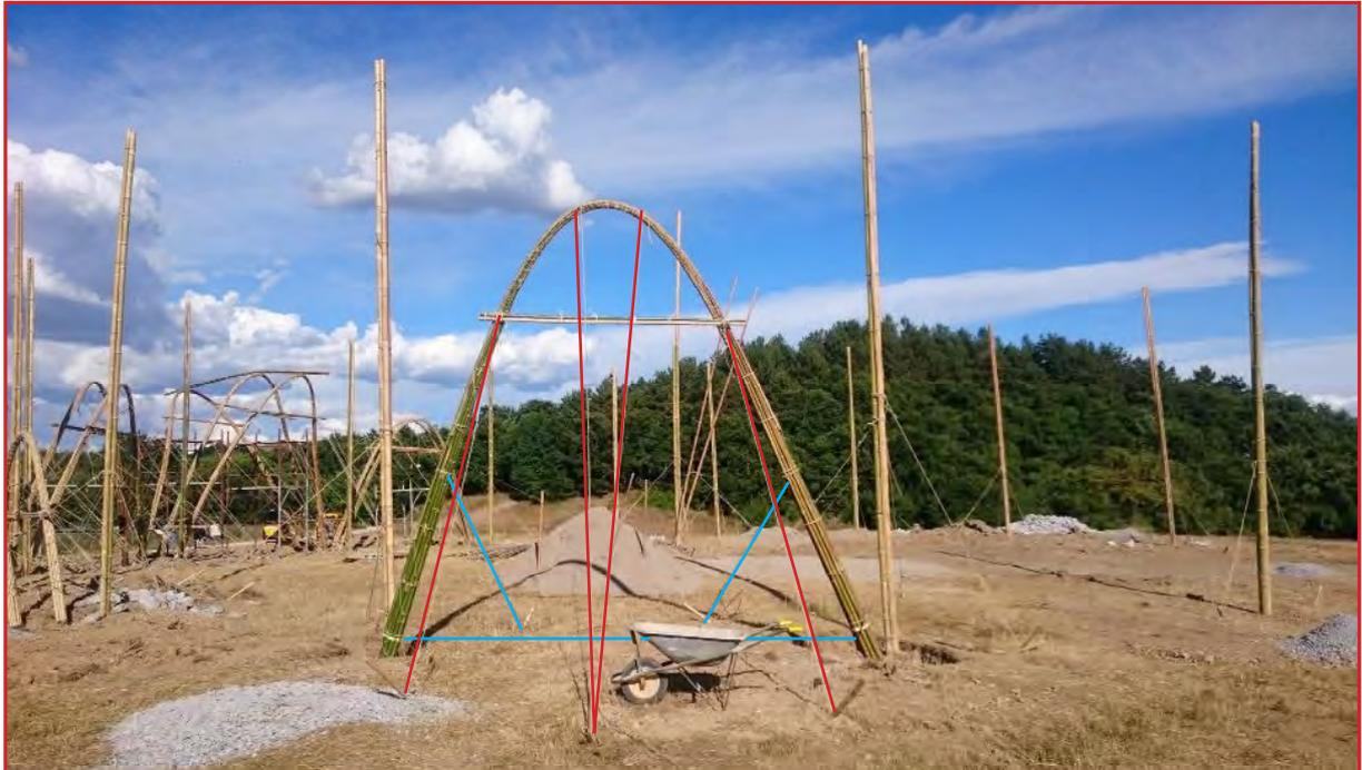
Figura 274. Arco innalzato e tenuto in tensione con 7 corde di ancoraggio (4 evidenziate in rosso e 3 in blu).
