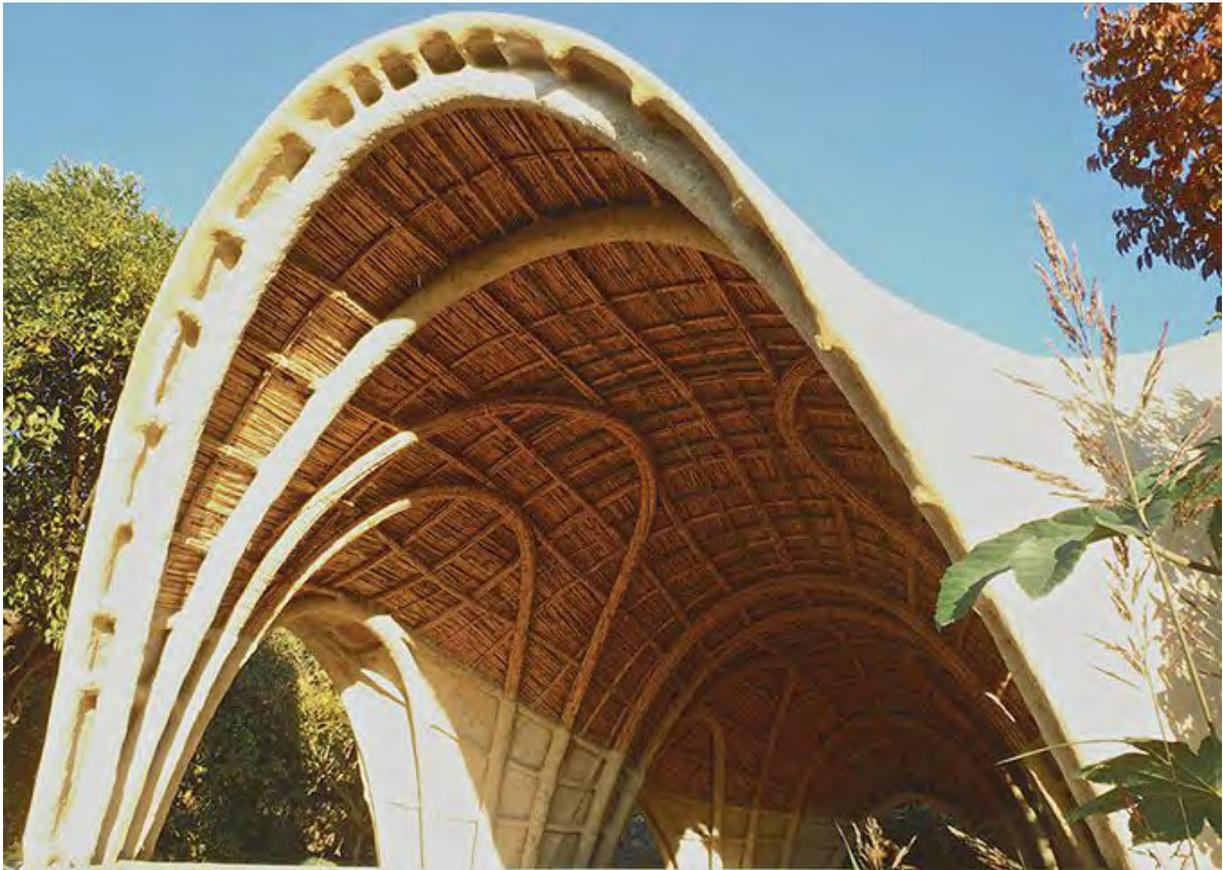
Figura 182. CANYA VIVA, Casa de Laila: spazio aperto multifunzionale realizzato a Málaga, 2013. Struttura in canna e finiture in terra cruda, calce-canapa, malta marmorino, <http://canyaviva.com/proyectos-permanentes.html>, consultato il 10/04/2018.
