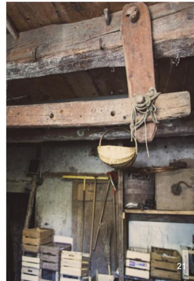
fig. 17 | Le tavole della pavimentazione poggiano sulla trave a forma di T rovesciato alla quale sono fissate con chiodi di legno.
