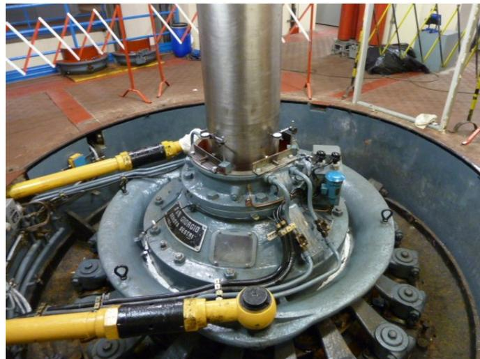
*Figura 3.5 Anello di Fink, che regola l'apertura di tutte le pale direttrici, fotografia dell'impianto di Saint-Clair*
