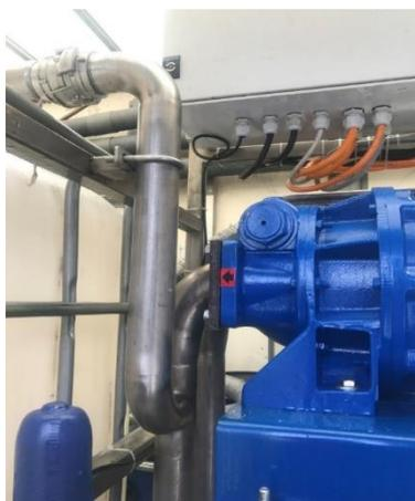
*Figura 89 : photo entré et sortie pompe volumétrique à piston excentré*
