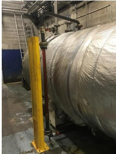
*Figura 18 : Photo colonne séparation statique biodiesel-glycérine*
