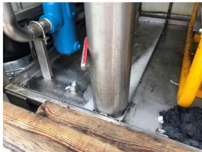
*Figura 91 : support tuyau pour éviter que l'huile coule partout sur le skid*
