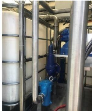
*Figura 87 : Photo de la tuyauterie, filtre et soupape*
