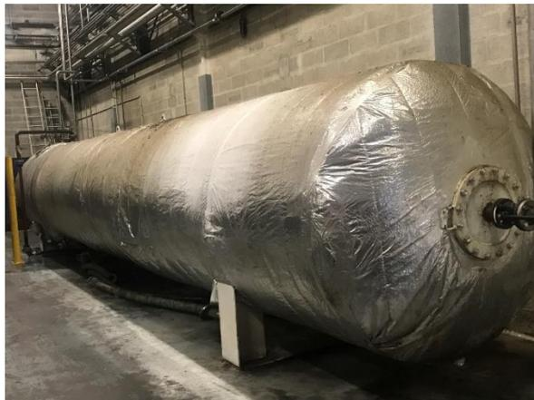
*Figura 19 : Photo coalesceur séparation statique biodiesel et glycérine*
