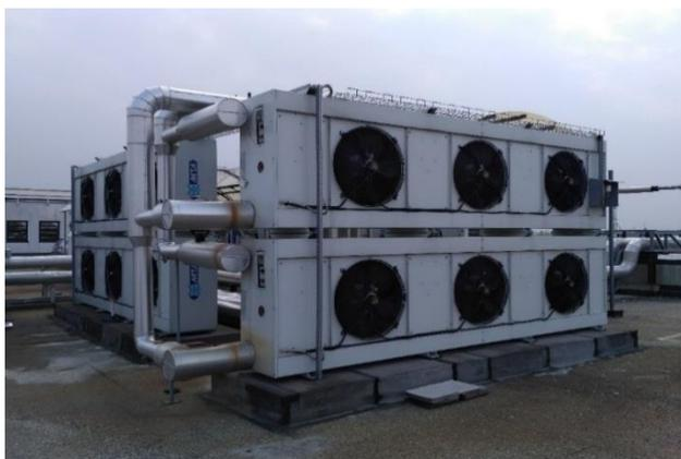
Figura 3.14 Impianto free cooling MTA RWD 150
