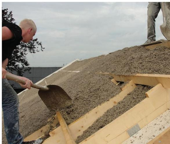
*Posa in opera a mano del composto in calce e canapa per l'isolamento di una copertura.*
