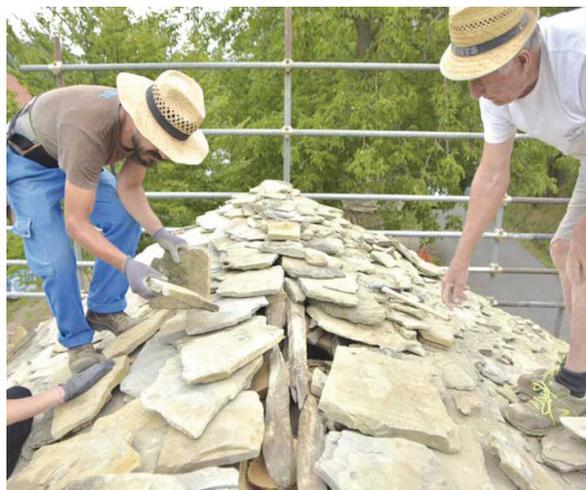
*Pose in opera del manto di copertura in "ciapèle".
