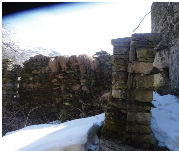
*Tipica muratura degli edifici di Cantoncello. In questo caso il muro è stato realizzato mediante l'apposizione di materiale lapideo "a secco". Fonte: archivio personale.*
