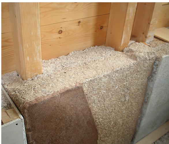
Muratura costituita da telaio in legno e coibentata con calce e canapa
