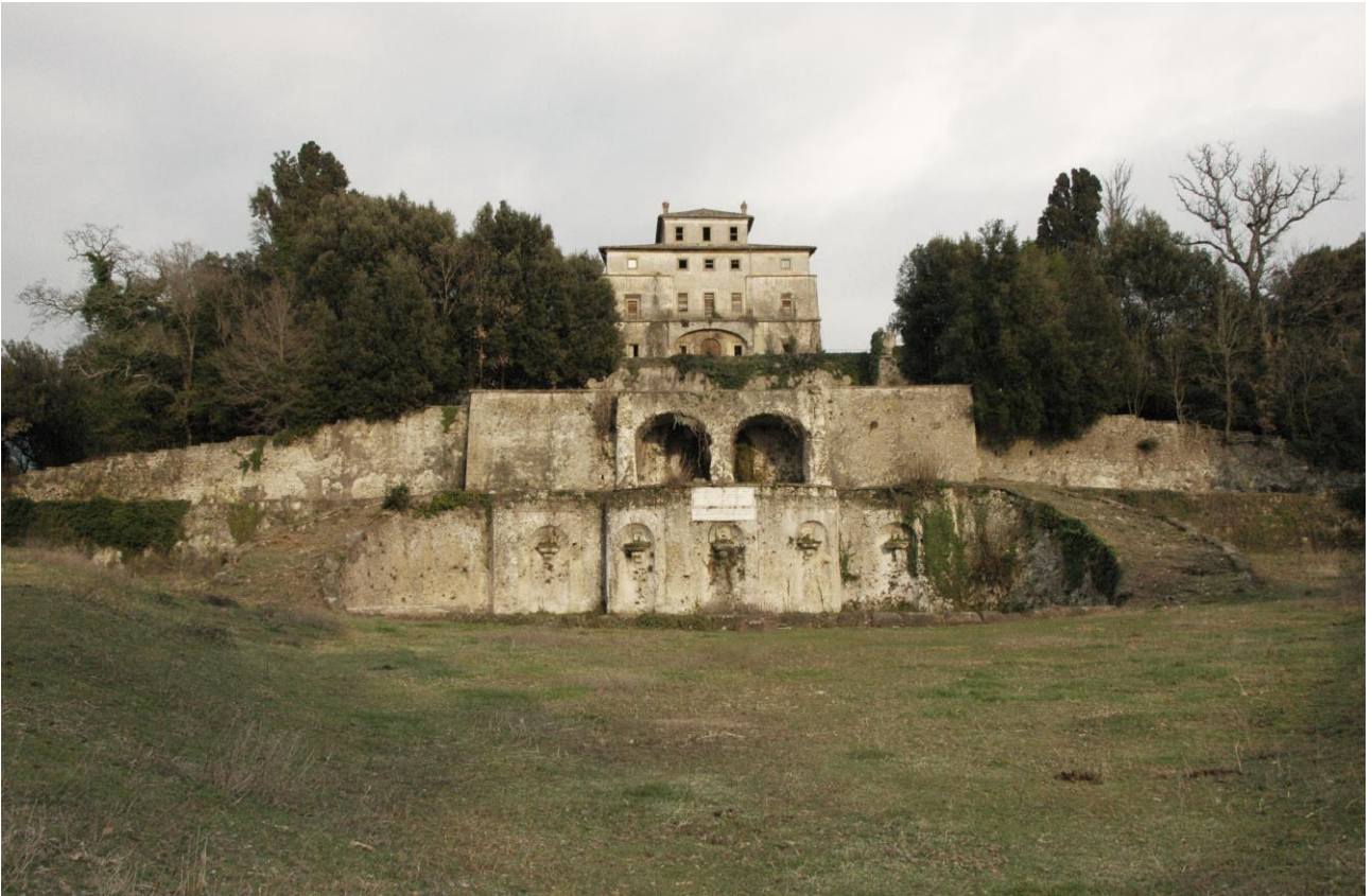
Foto 1. Prospetto ovest Villa Catena De Laurentiis e la fontana delle Cinque Bocche.
