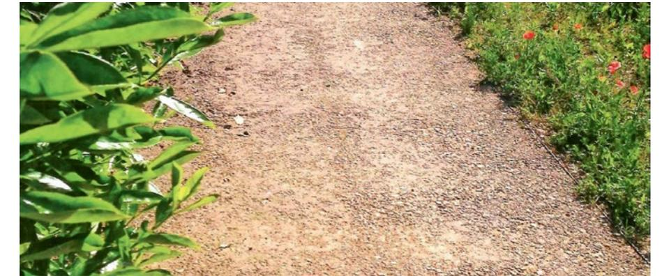
Dettaglio strata realizzata tramite compattazione del terreno e pavimentazione drenante in terra stabilizzata
