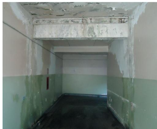
*Fig.97 Corridoio di passaggio, infiltrazioni*
