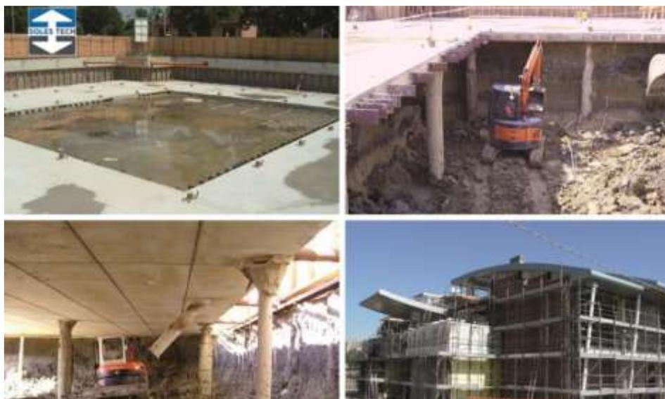
**Figura 128** Inserimento di un nuovo piano seminterrato negli edifici esistenti in cemento armato<sup>35</sup>
