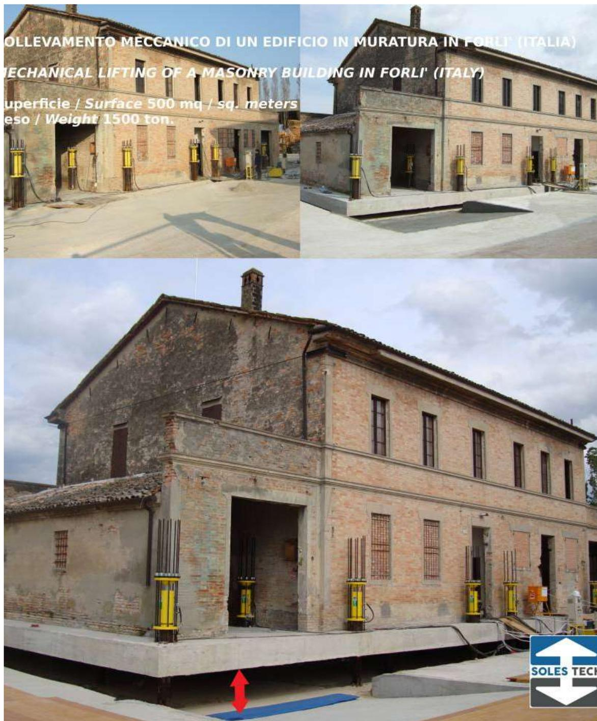
**Figura 127** Sollevamento edifici con tecnica brevettata SOLESTECH<sup>34</sup>
