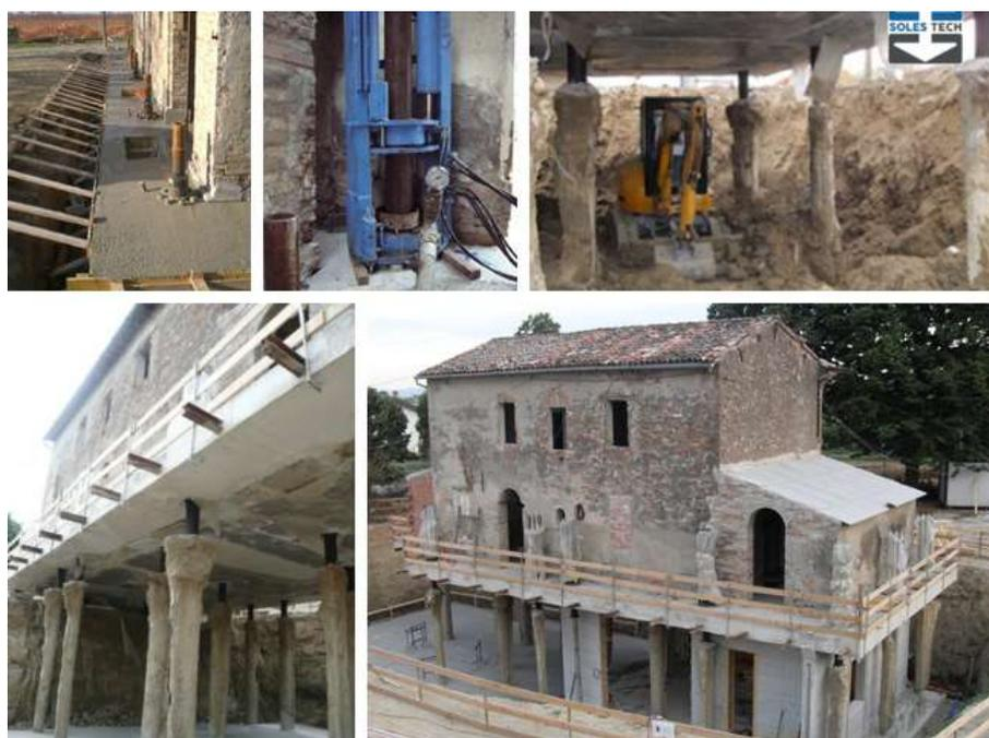
**Figura 129** Inserimento di un nuovo piano seminterrato negli edifici esistenti in muratura<sup>36</sup>
