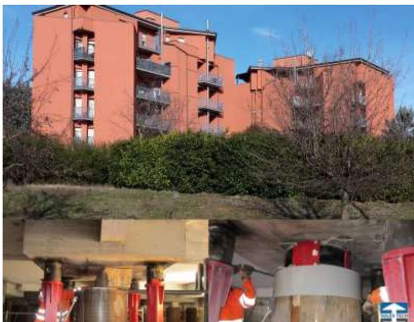
**Figura 131** Inserimento degli isolatori in un nuovo piano seminterrato in edificio esistente in cemento armato.<sup>38</sup>
