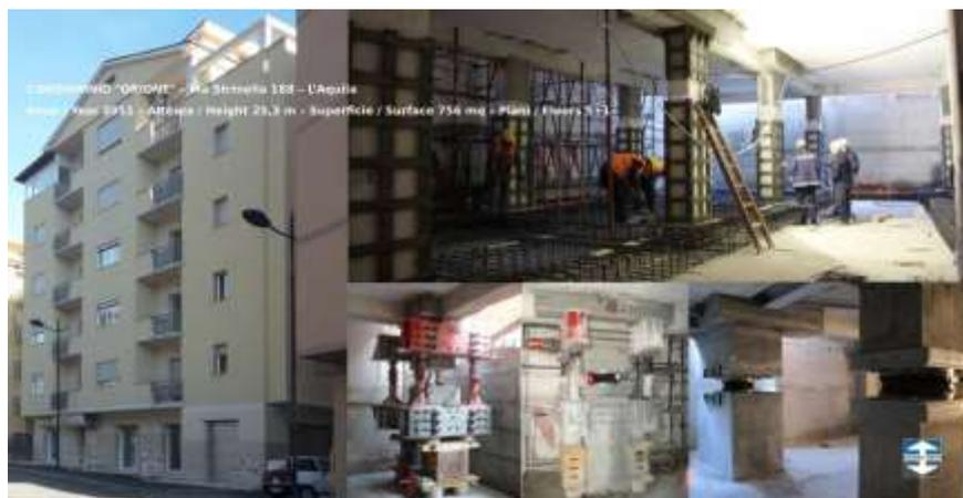
**Figura 130** Inserimento di un nuovo piano seminterrato negli edifici esistenti in cemento armato con rinforzi ai piani superiori. L'isolamento è stato posto nella parte media dei pilastri di fondazione.
