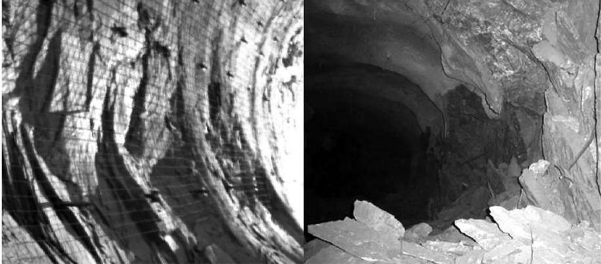
**Figura 3. 4** – Confronto tra spalling (a sx) e rockburst (a dx) [15].
