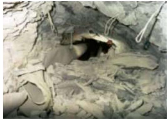
**Figura 2. 7** – TBM monoscudo intrappolata in ammasso soggetto a squeezing (Uluabat Tunnel; Cortesia di Werner Burger, Herrenknecht AG) [21].
