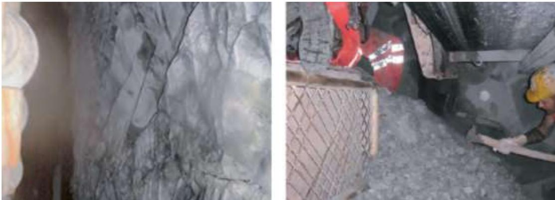
**Figura 2. 12** – A sinistra: creazione di blocchi al fronte a causa dell'elevato stato tensionale (Tunnel di base Lötschberg). A destra: TBM bloccata a causa dell'instabilità del fronte (Tunnel di base del Gottardo) [21].
