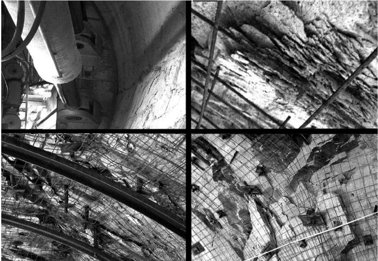
**Figura 3. 3** – Danno da spalling. Livelli crescenti in senso orario, a partire dall'alto a sinistra [16].
