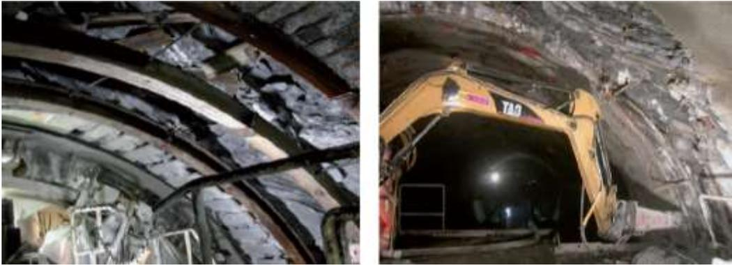
**Figura 2.5** – Conseguenze del buckling sui supporti in centine e shotcrete (Tunnel di base Lötschberg). A destra: riprofilatura prima dell'installazione del rivestimento finale [21].
