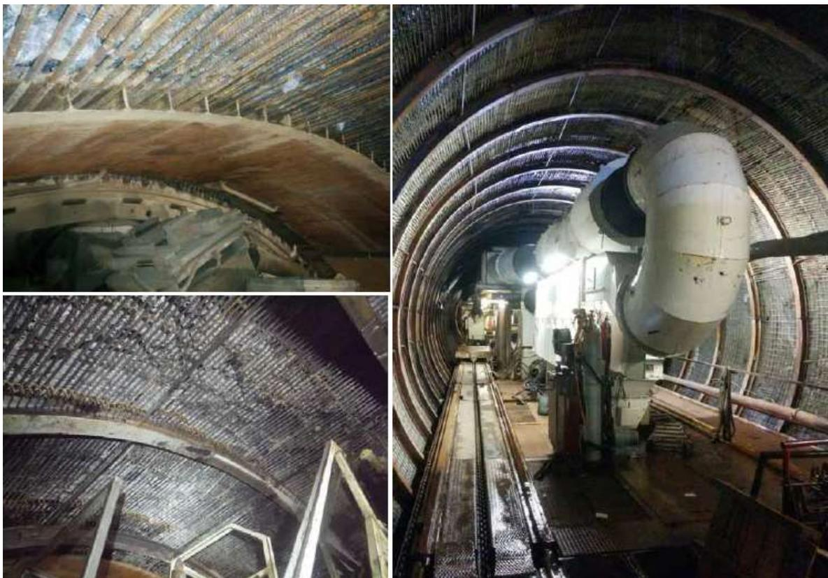
**Figura 4.10** – Sistema di sostegno McNally®. A sinistra, in alto gli scatolari saldati sotto lo scudino per l'installazione delle barre in acciaio; in basso le barre in acciaio poggianti su due centine consecutive. A destra, una vista globale del sistema di sostegno ad installazione avvenuta [32].
