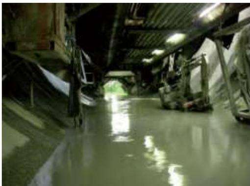
**Figura 2. 13** – Ingresso di acqua ad elevate temperatura (43°C) nel “Tunnel di base del Gottardo” [21].
