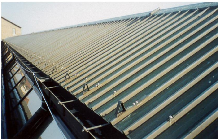
Fig. 8.2.6 Estradosso della copertura
