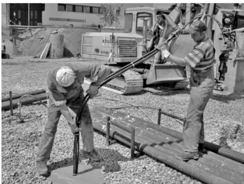
Figura 1.35: tubi scambiatori in pali di acciaio riempiti con calcestruzzo (Brandl H. 2006)
