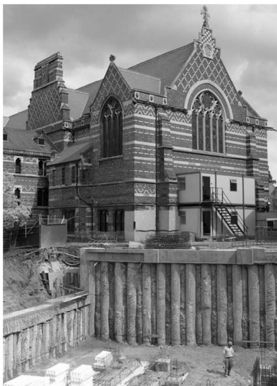
Figura 1.39: particolare del muro di contenimento e dello scavo (Suckling T. P. et al. 2002)
