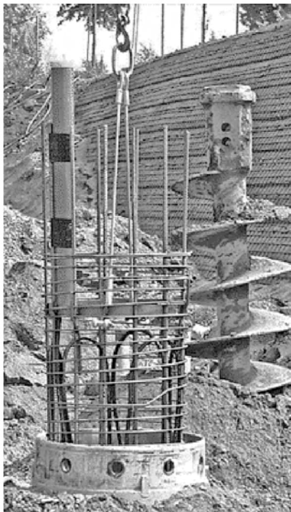
Figura 1.34: armatura di un palo energetico con impianto termoscambiatore prima del getto di calcestruzzo (Brandl H. 2006)
