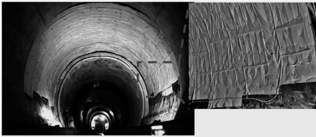
Figura 1.55: dettaglio del geotessile energetico installato nel rivestimento del tratto LT22, Lainzer Tunnel (Adam D. et al. 2009)
