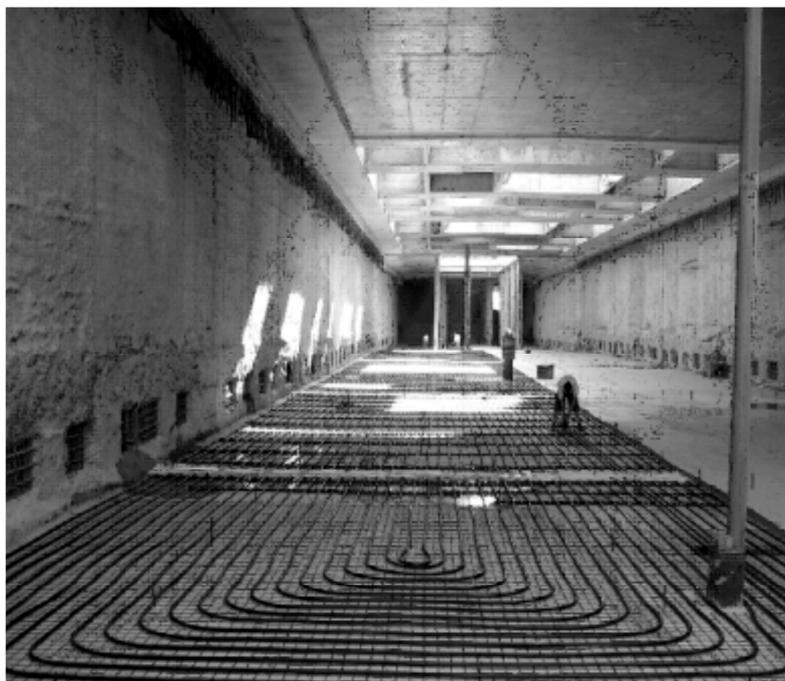
Figura 1.46: trave di fondazione della stazione U2/4 Meße strumentata con i tubi scambiatori (Adam D. et al. 2009)
