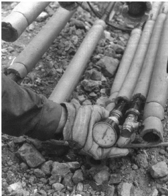
Figura 1.31: valvola e manometro per i tubi scambiatori dei pali energetici (Suckling T. P. et al. 2004)
