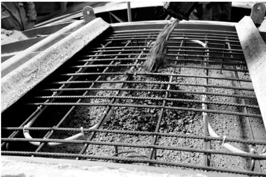
Figura 1.60: preparazione del concio energetico “Energietübbing” (Pralle N. et al. 2011)
