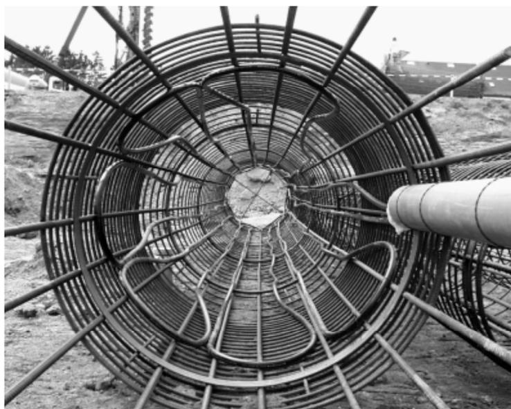
Figura 1.30: esempio di circuito a spirale in un palo energetico (Brandl H. 2006)
