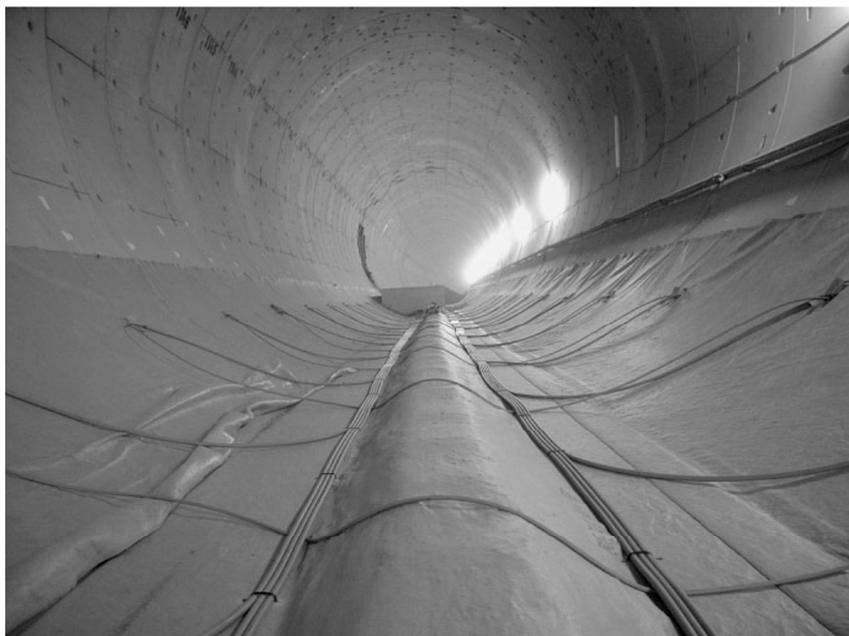
Figura 1.65: particolare dei collettori termici prima dell'installazione della trave di base (Frodl S. et al. 2010)
