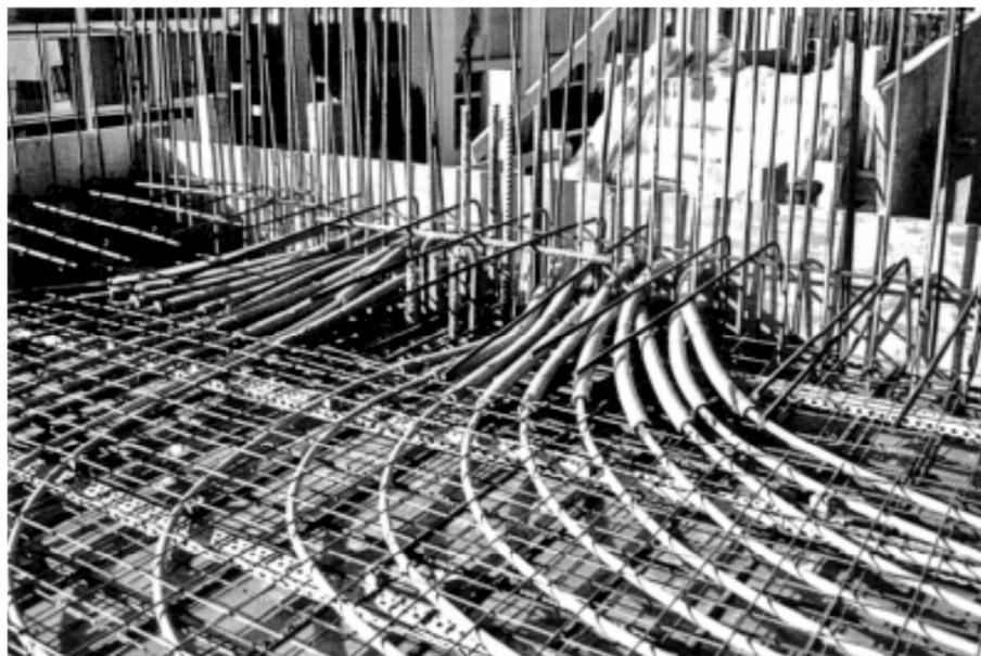
Figura 1.33: particolare del raccordo in una fondazione energetica (Brandl H. 2006)
