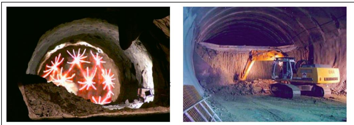
Figura 14. Esempio di Drill and Blast e scavo con escavatore (rispettivamente a sinistra e a destra) (Working Group 19, aprile 2009)
