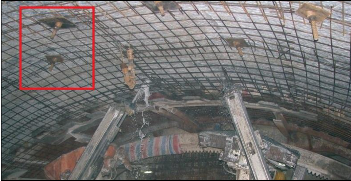
Figura 25. Sistema di reti sostenute da chiodature (West Qinling Tunnel, Cina)
