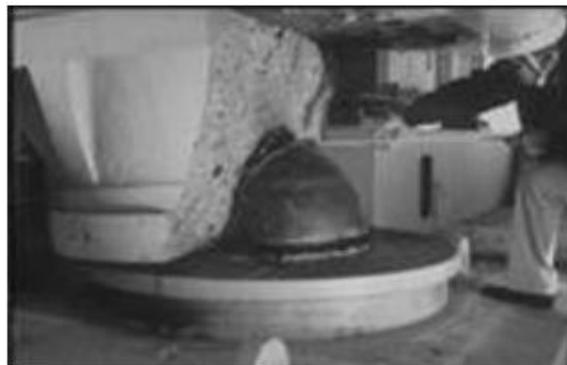
*Fig.6.3: Rottura dell'appoggio: ponte Higashi-Kobe, Giappone, Kobe 1995*
