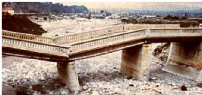
*Figura 1.4: esempio di crollo parziale di un manufatto di attraversamento dovuto ad un fenomeno di erosione localizzata alla base di una pila*
