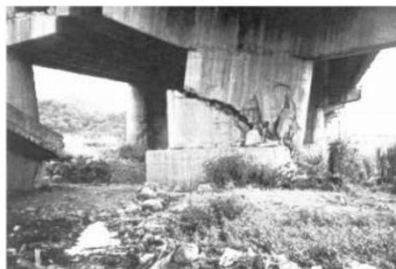
**Fig.6.6:** *Collasso per taglio di una pila: viadotto Wushi (terremoto di Chi Chi, Taiwan, 1999).*
