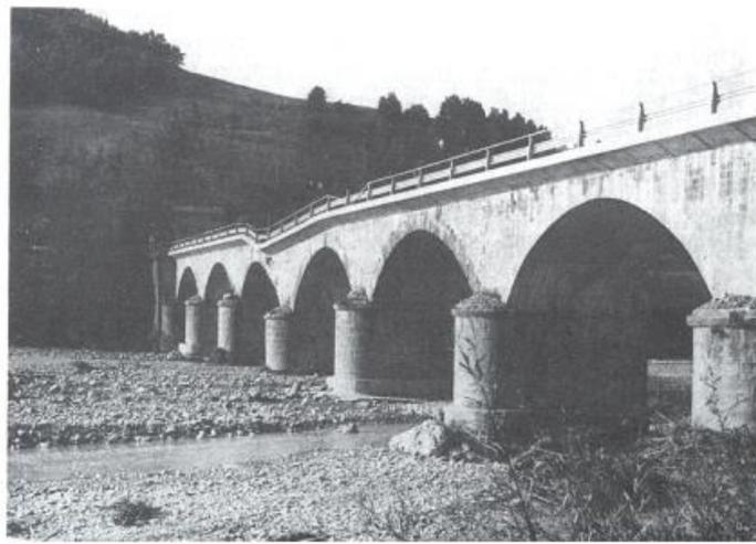
**Figura 1.6:** Cedimento di una pila del ponte sul Fiume Secchia in località Gatta (Emilia-Romagna) dovuta ad erosione localizzata (piena settembre 1992)
