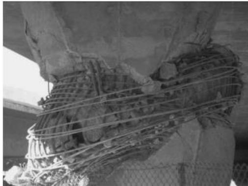
**Fig.6.5:** *Collasso per flessione e taglio, Viadotto Gothic Avenue (terremoto di Northridge, California, 1994).*
