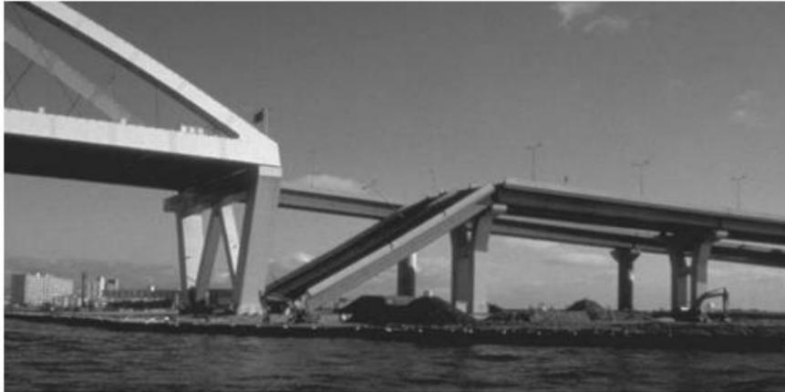
*Fig.6.2: Perdita di appoggio: ponte Nishinomiya-ko, Giappone, Kobe 1995. In questo caso erano presenti ritegni sismici assolutamente inadeguati costituiti da bulloni colleganti le lamiere terminali dell'arco e del traverso della campata crollata.*
