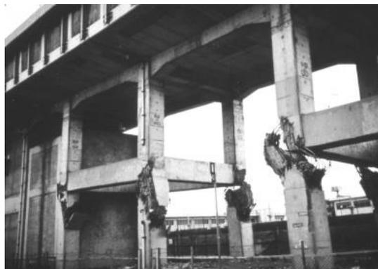
*Fig. 6.8: Terremoto di Kobe, Giappone (1995): danni su una pila a telaio, viadotto Shinkansen a Kobe.*
