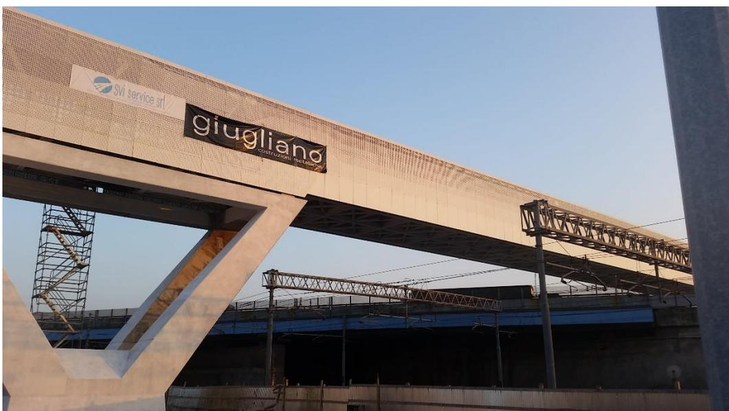
La passerella presenta una struttura reticolare rettilinea, avente larghezza di 6 metri, che permette un flusso massimo di 2.500 persone l'ora, garantendo comunque nelle situazioni di emergenza la sicurezza degli afflussi. Rientra infatti all'interno della classe di comfort CL1, ossia il livello massimo secondo il documento "Hivoss (2008) – Human induced Vibrations of Steel Structures – Design of Footbridges".
