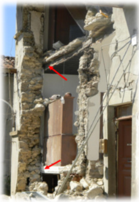
Fig. 6 Esempio di edificio senza connessioni tra impalcati e murature (fonte: https://www.ingegneriasismicaitaliana.com )
