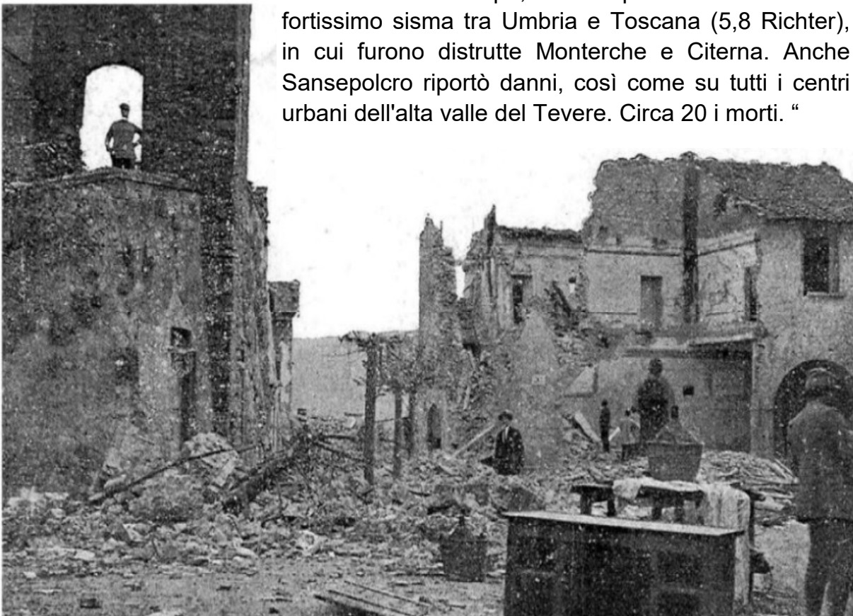
Fig. 11 Immagine della piazza principale di Monterchi, dopo il sisma del 1917 (fonte https://ingvterremoti.wordpress.com ).
