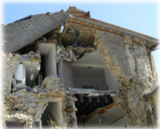
Fig. 6 Esempio di edificio senza connessioni tra impalcati e murature (fonte: https://www.ingegneriasismicaitaliana.com )
