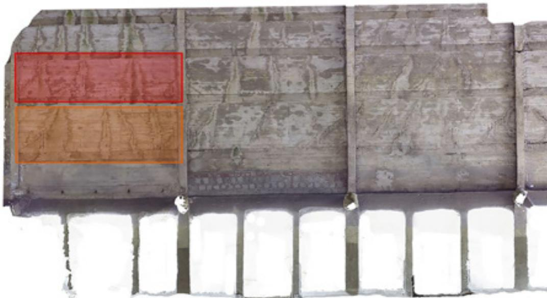
Selezione delle due parti approfondite nell'analisi del degrado del c.a. In rosso l'area analizzata con riconoscimento RGB automatico con QGIS, in arancione l'area analizzata con disegno al tratto in AutoCAD. Fonte: Foto dell'Autore.
