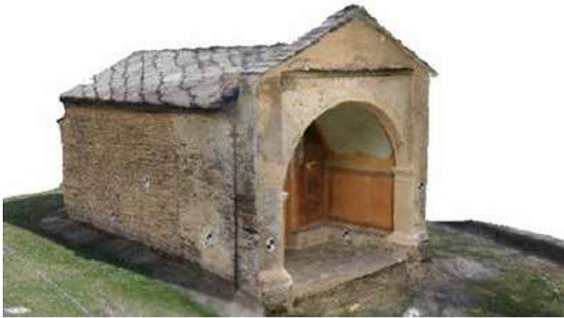
FIG 11: Esempio di modello 3D ottenuto dal metodo fotogrammetrico
