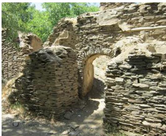
Figura 102 - Utilizzo della pietra per la realizzazione di murature con aperture
