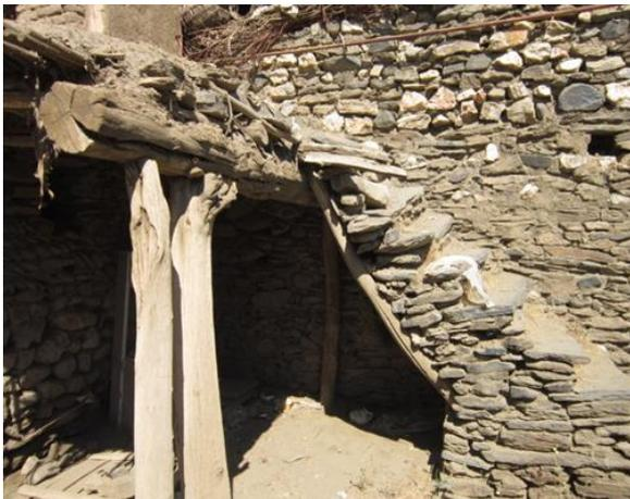
Figura 101: particolare del nodo pilastro-trave
