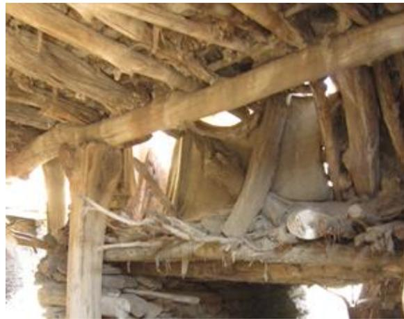
Figura 100: struttura aggettante in legno
