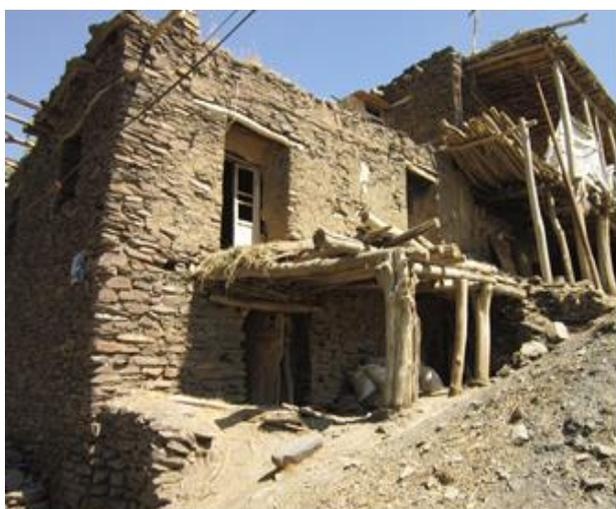
Figura 117: Uso della colonna in legno come un elemento strutturale
