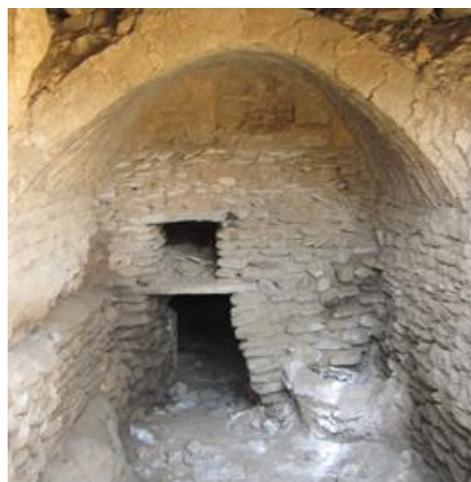
Figura 115: Esempio di copertura a volta
