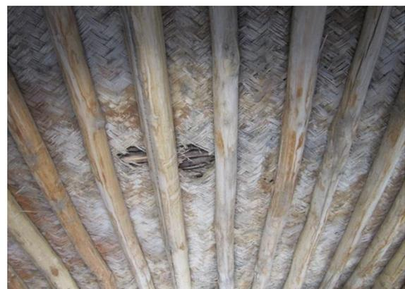
Figura 110: tipologia di copertura con orditura semplice
