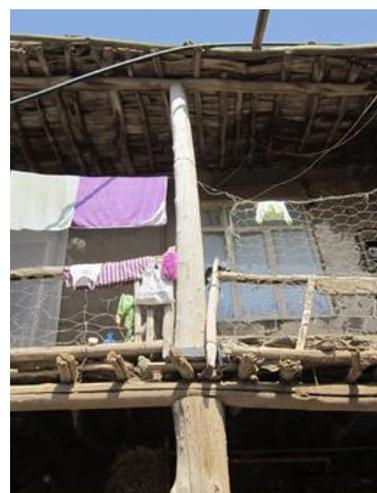
Figura 116: Uso delle colonne in legno come elemento portante
