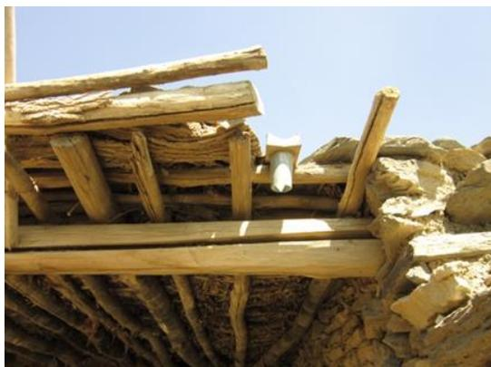
Figura 109: Particolare incastro tra travi principali e travetti secondari
