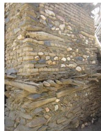
Figura 107: Esempi di costruzioni in muratura mista
