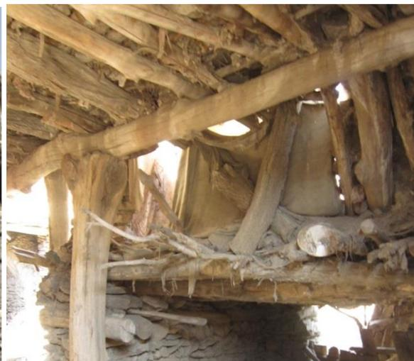
Figura 118: la colonna sostiene la nervatura del tetto
