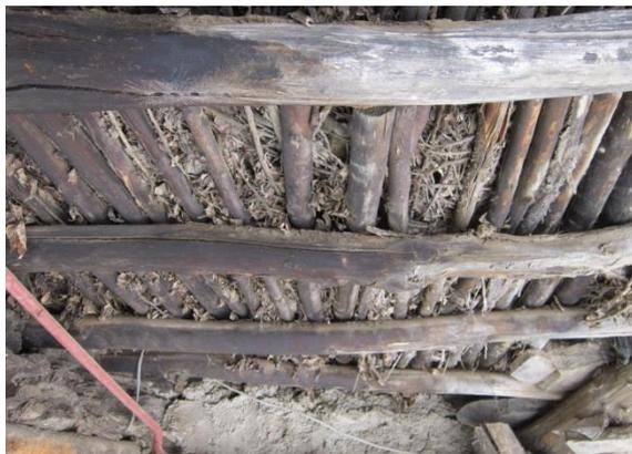
Figura 111: tipologia di copertura con orditura incrociata
