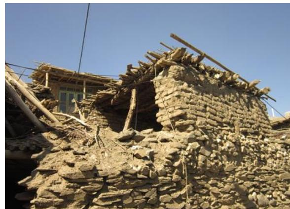
Figura 113 e Figura 114: Le differenti coperture piatte usate a Varkaneh
