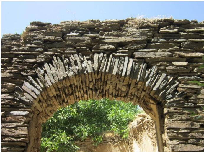
Figura 97: Utilizzo della pietra per la realizzazione di archi in muratura
