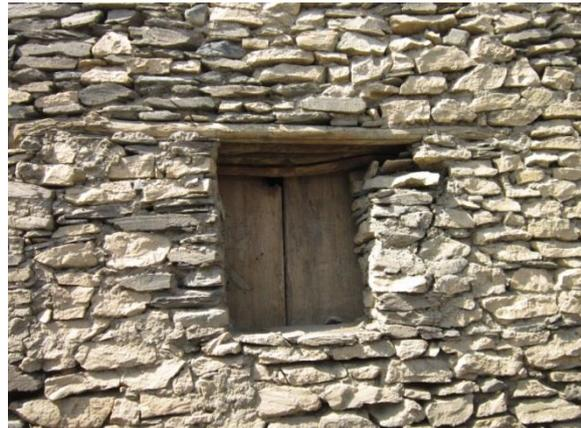
Figura 121 e Figura 122: esempi di finestre con architrave in legno e strombatura molto marcata
