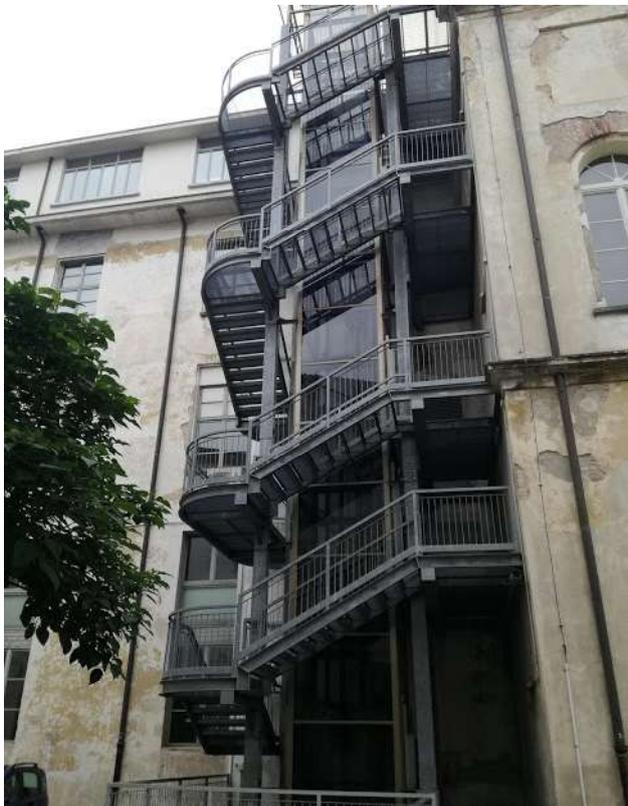
*Figura 7. Particolare della scala metallica realizzata sul lato nord dello scalone nel 1978, fotografia da sopralluogo.*
