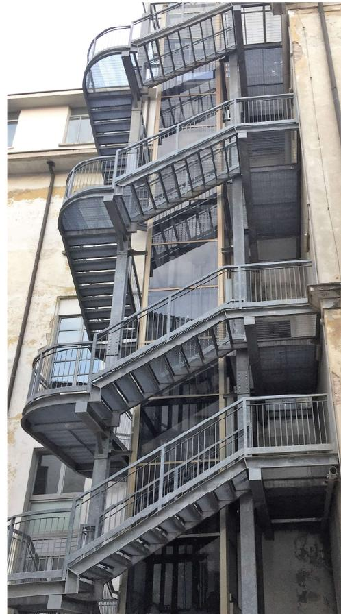
*Figura 10. Particolare della scala metallica prefabbricata realizzata nel 1978 sul lato nord dello scalone.*
