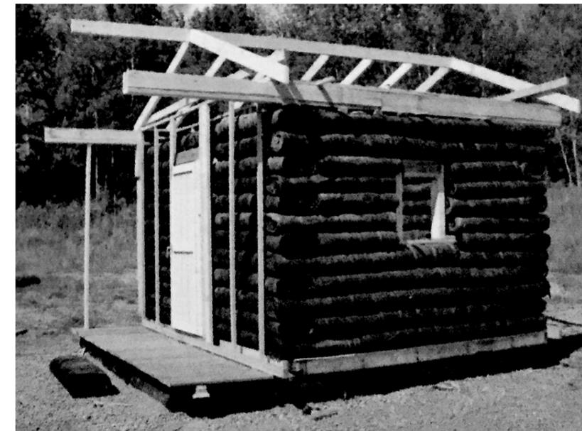
FIGURA 3.52: TIRE-LOGTM HOUSE IN COSTRUZIONE
