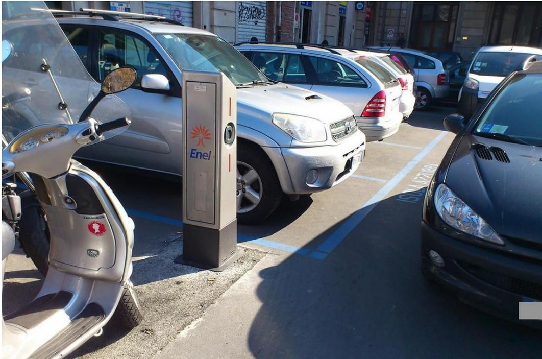
**Figure 41. Occupazione dei posti per la ricarica dei veicoli elettrici dovuta allo scorretto inserimento della colonnina e alla totale assenza di segnaletica.**
