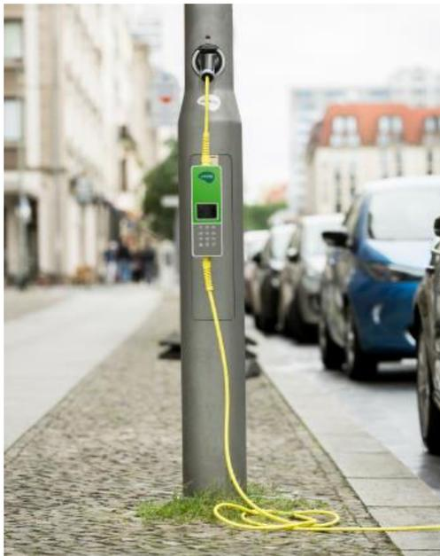
**Figure 47. Dispositivo SimpleSocket di Ubitricity.**
