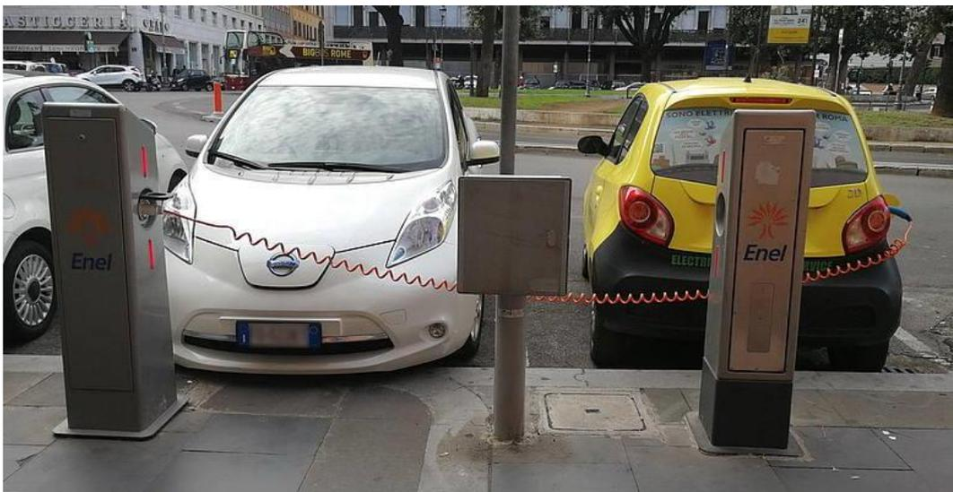
**Figure 34. Scorretto inserimento dell'infrastruttura e conseguente uso sbagliato del modo di ricaricare.**
